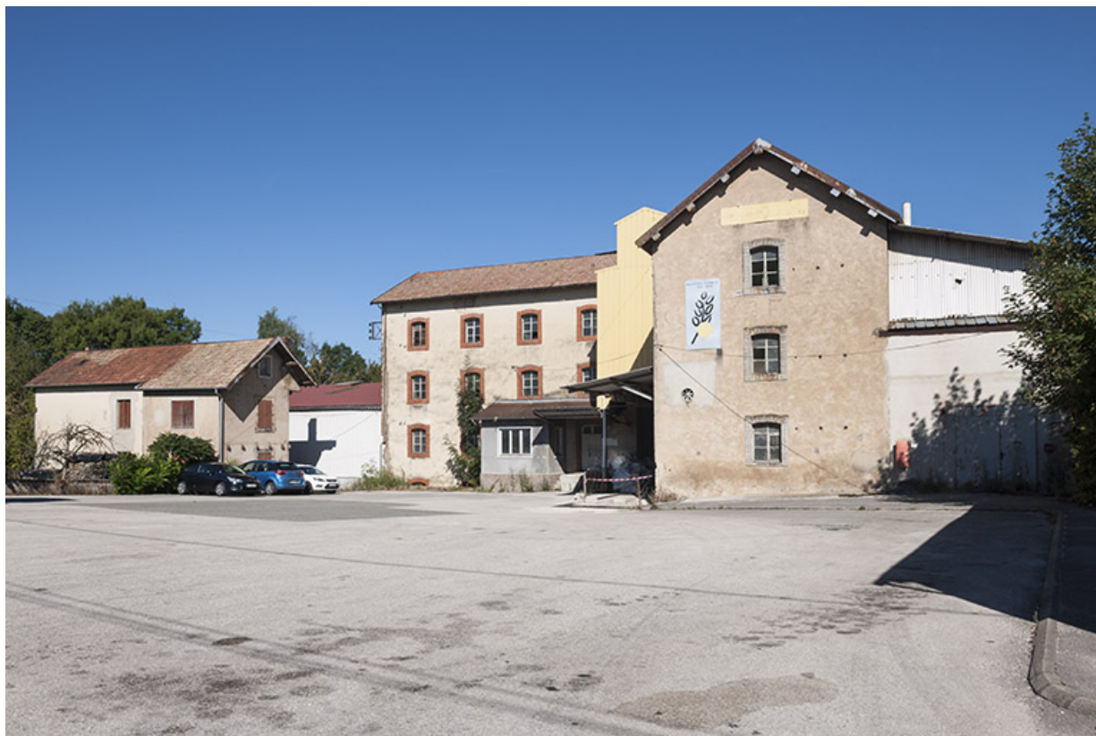
Vue d'ensemble depuis l'est.
