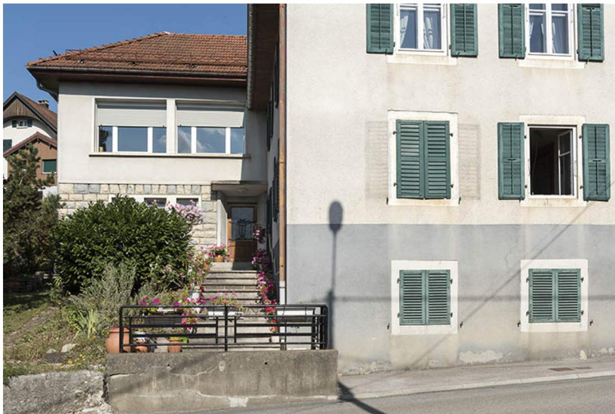
Façade antérieure de l'atelier de fabrication.
