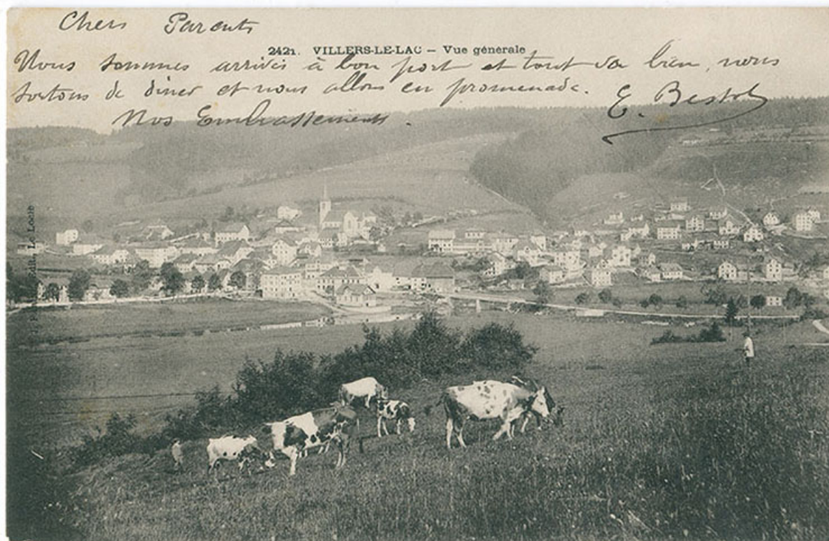
2421. Villers-le-Lac - Vue générale [vue d'ensemble, depuis le sud-est], 1902 ou 1903. Le bâtiment, à droite, est coiffé d'une terrasse.
