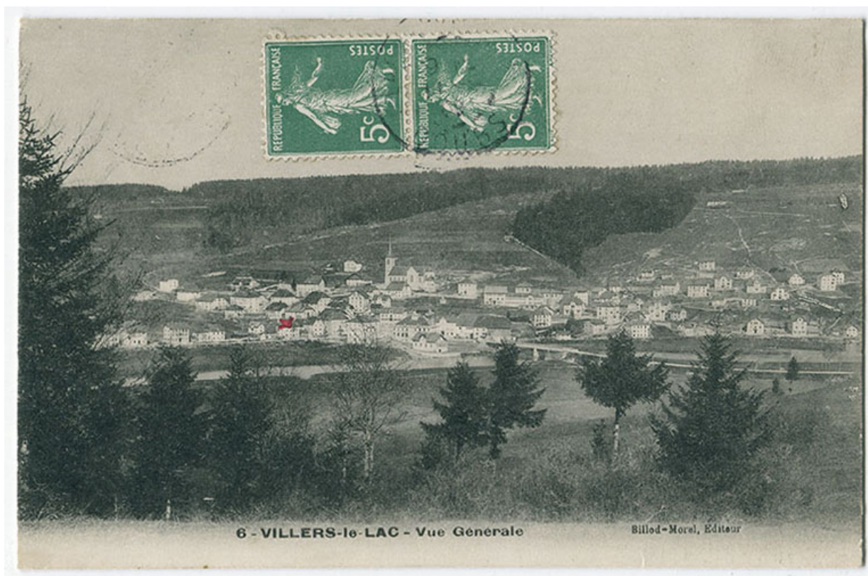
6 - Villers-le-Lac - Vue générale [depuis l'est], 1er quart 20e siècle [avant 1908]. Seul existe le premier bâtiment. 25, Villers-le-Lac
