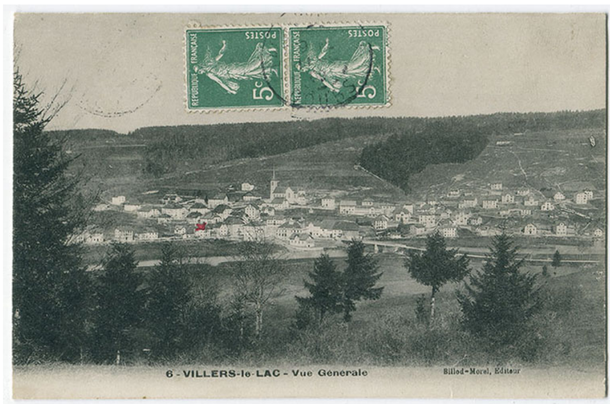
6 - Villers-le-Lac - Vue générale [depuis l'est], 1er quart 20e siècle [avant 1908]. Seul existe le premier bâtiment. 25, Villers-le-Lac
