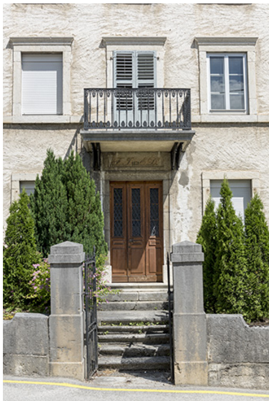
Façade antérieure : travée centrale.
