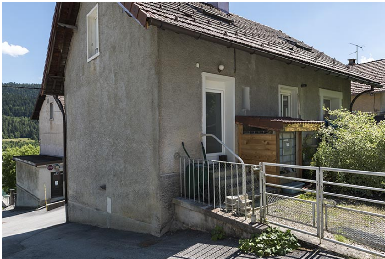
Façade postérieure, de trois quarts gauche. 25, Villers-le-Lac, 5 rue des Châteaux d'Eau
