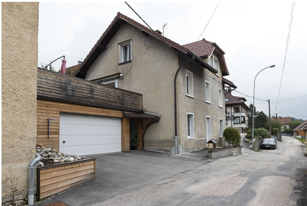
Vue d'ensemble, depuis le sud-ouest (façades antérieure et latérale gauche).
