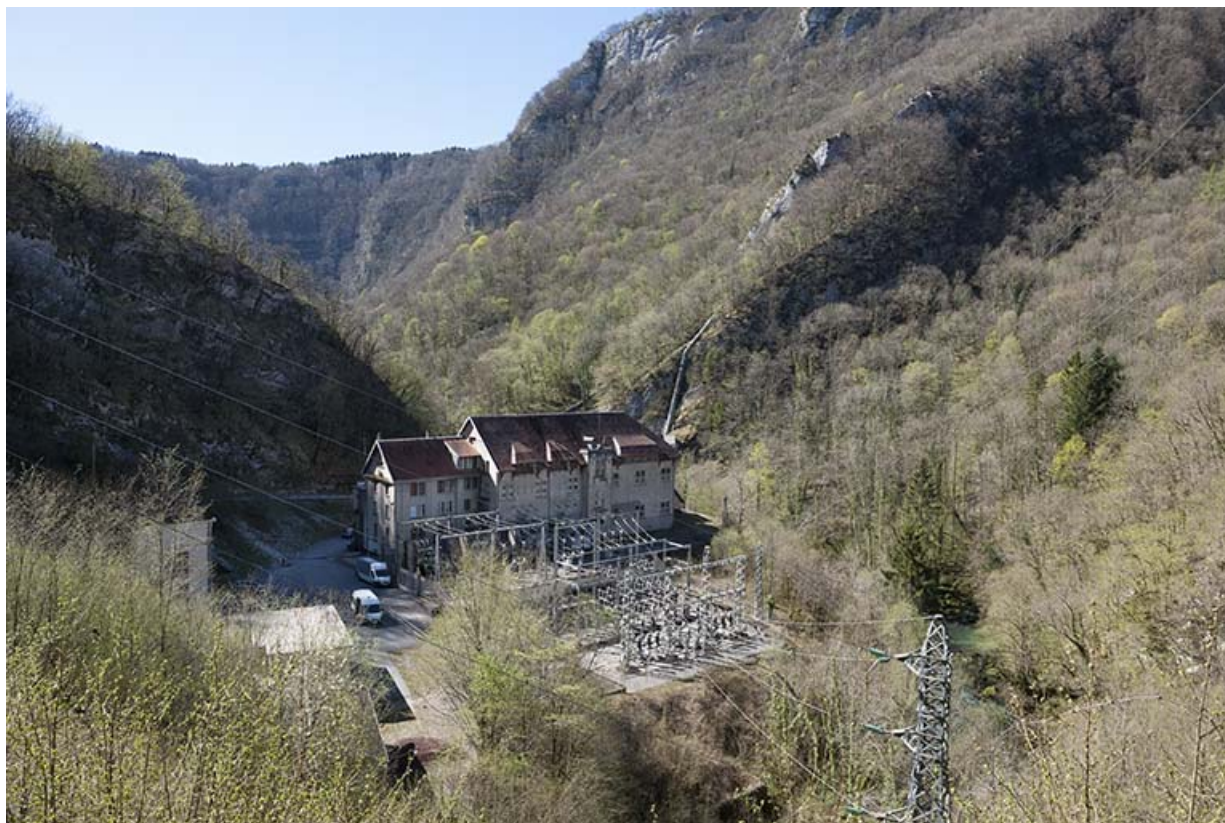
Vue plongeante depuis le nord sur le bâtiment d'exploitation.
