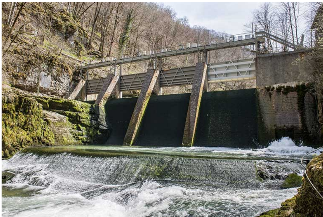
Barrage de la retenue, depuis l'aval.
