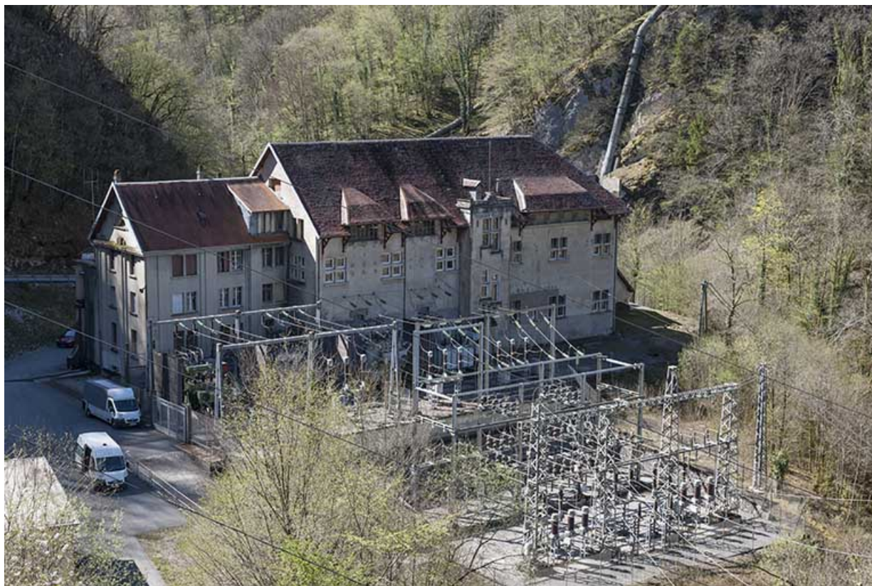
Bâtiment d'exploitation et poste de transformation. Vue rapprochée.
