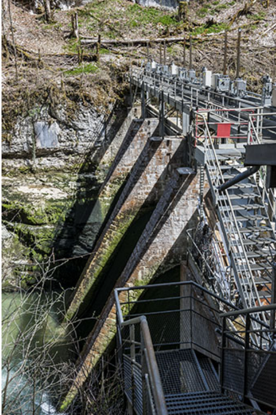
Détail des contreforts du barrage.
