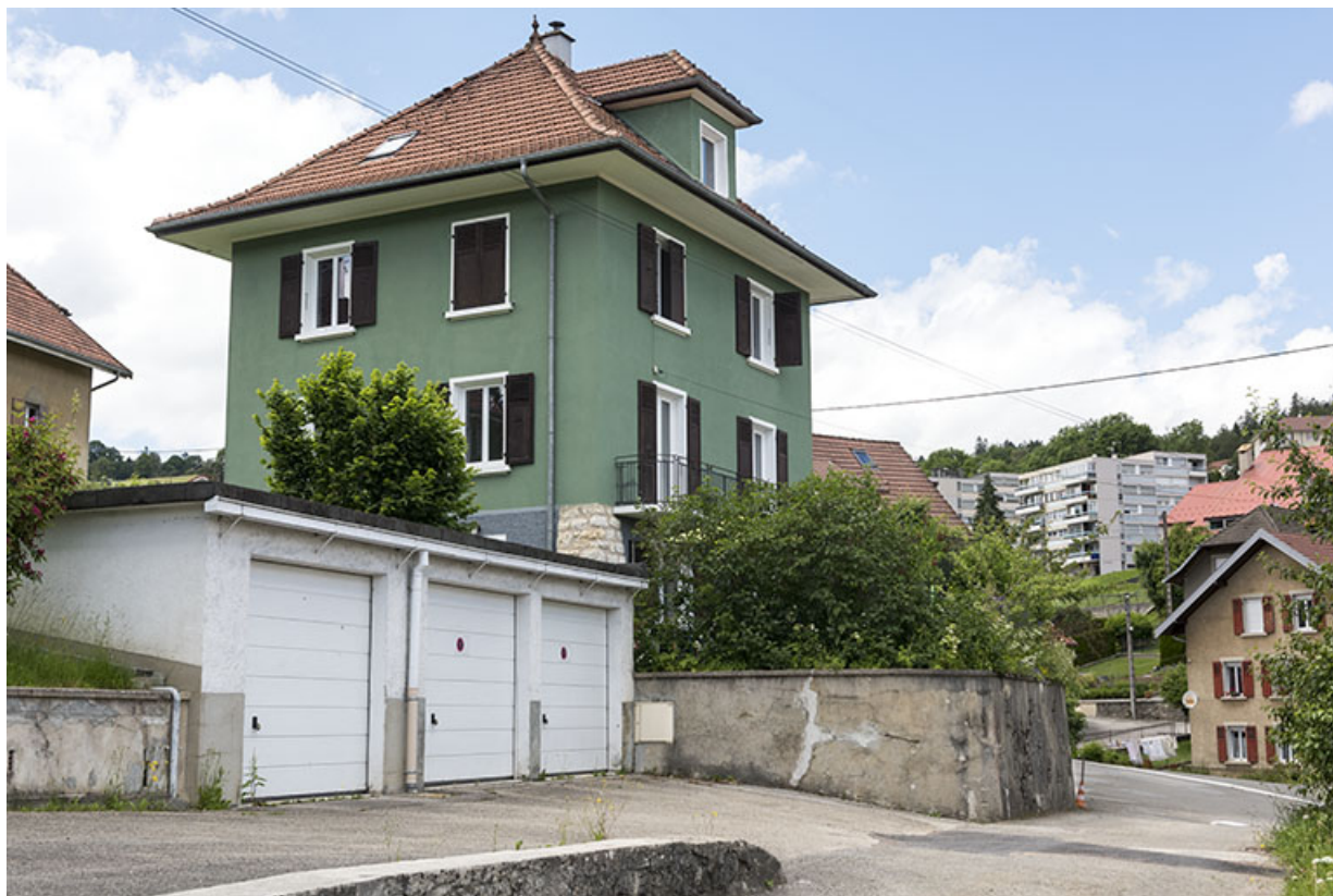
Façades antérieure et latérale gauche.
