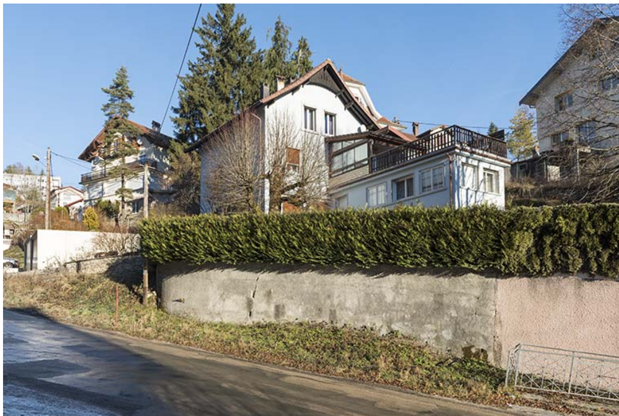
Vue d'ensemble, depuis le sud (façades postérieure et latérale gauche). 25, Villers-le-Lac, 7 rue de l' Horlogerie
