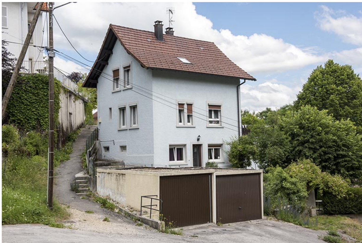
Maison : façades postérieure et latérale droite.
