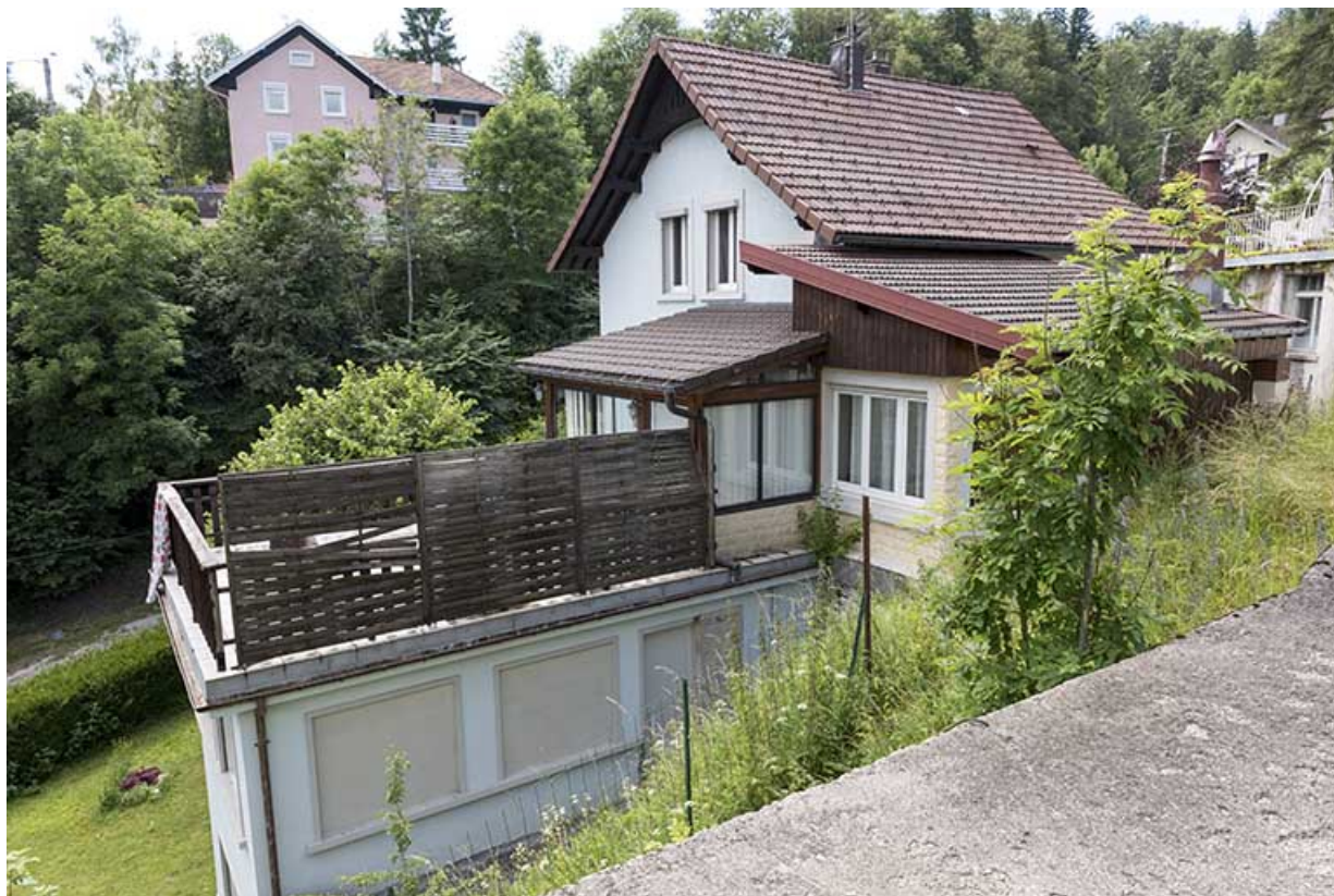
Vue d'ensemble, depuis l'est (façades antérieure et latérale gauche).
