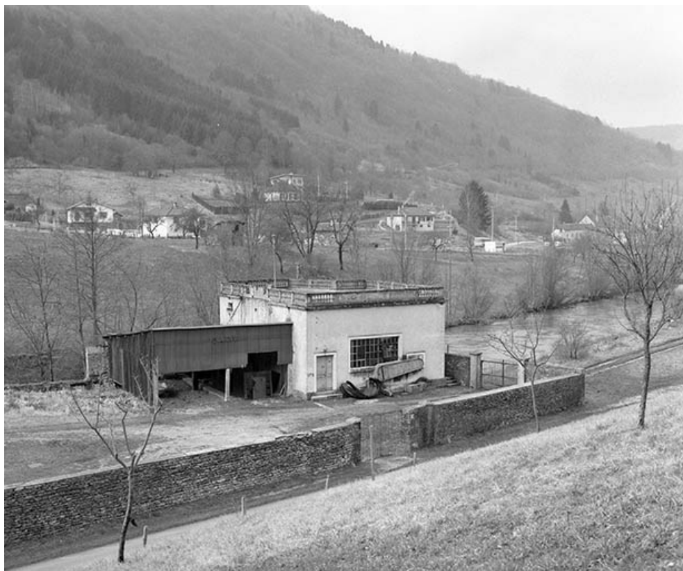
Le bâtiment d'eau de la tréfilerie Bersaillin.
