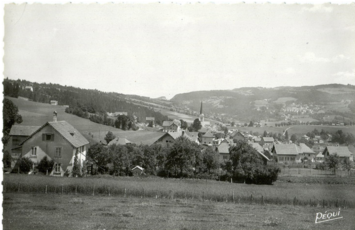
328. Lac ou Villers (Doubs). Vue générale [depuis l'ouest], milieu 20e siècle [1945 ?]. 25, Villers-le-Lac, 2 rue Newton
