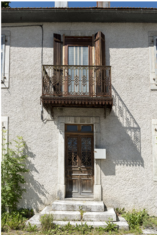
Façade antérieure : travée centrale.
