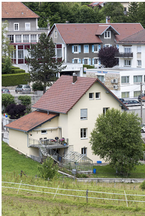
Façades postérieure et latérale droite.
