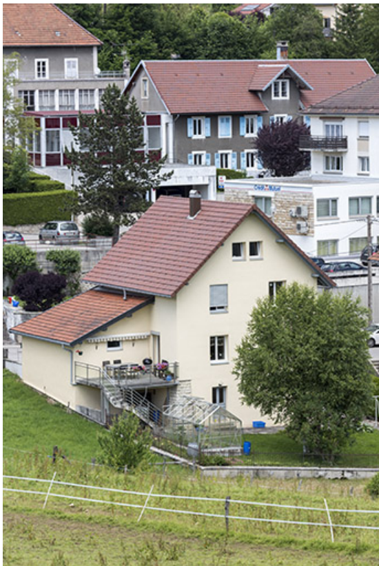
Façades postérieure et latérale droite.
