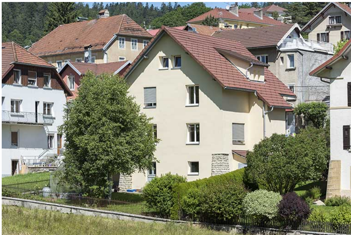
Façades postérieure et latérale gauche.
