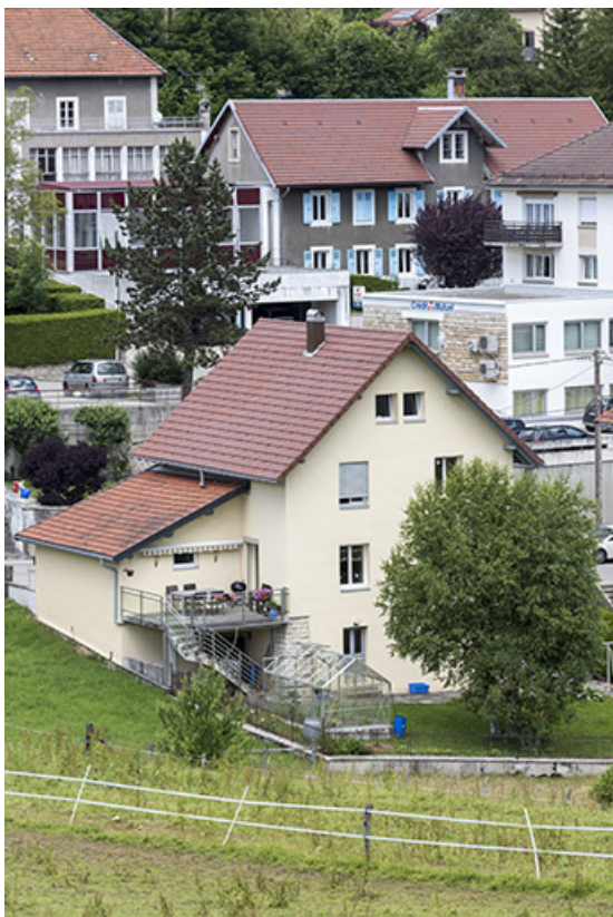
Façades postérieure et latérale droite.
