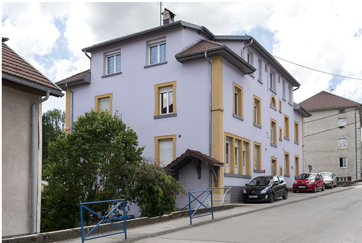
Façades antérieure et latérale gauche.
