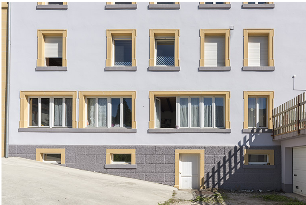
Façade postérieure : baies d'atelier.
