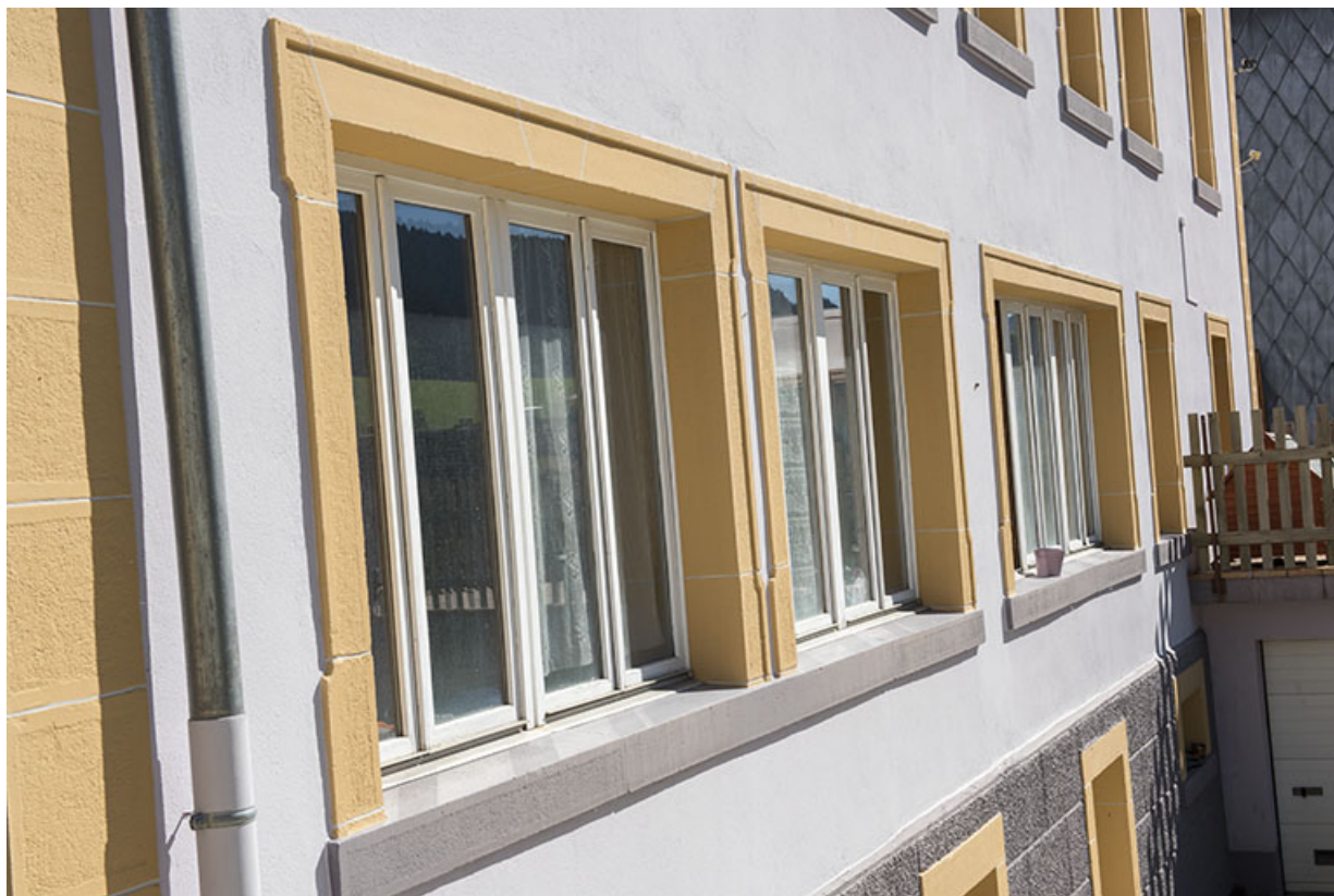
Façade postérieure : baies d'atelier vues en enfilade.
