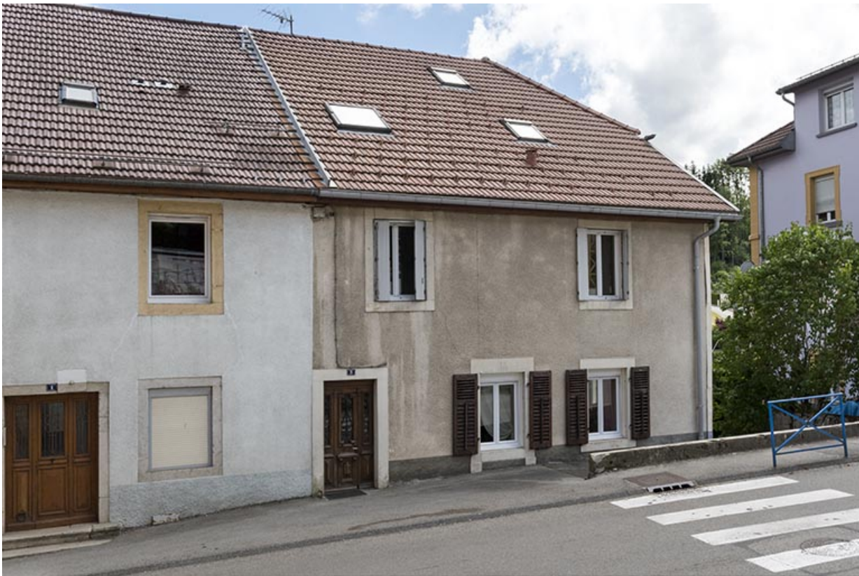
Façade antérieure, de trois quarts gauche. 25, Villers-le-Lac, 3 Grande Rue
