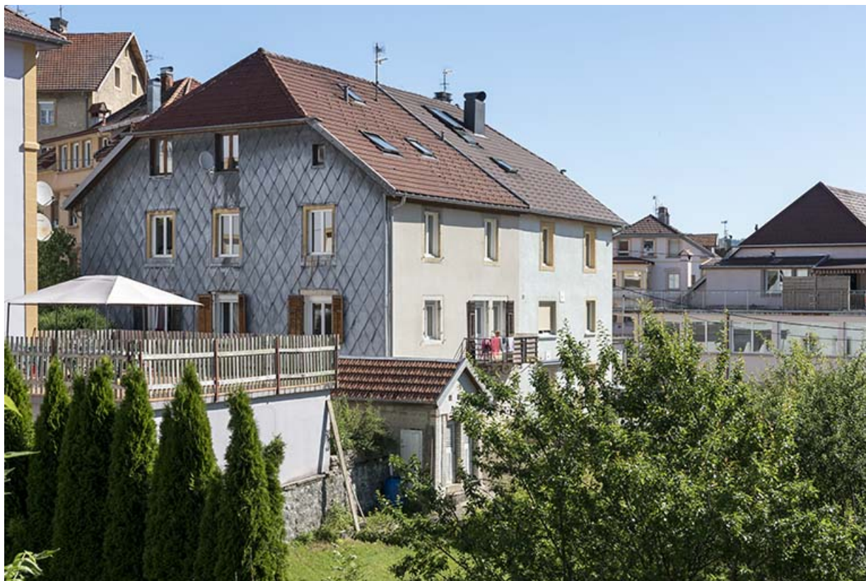
Façades postérieure et latérale droite.
