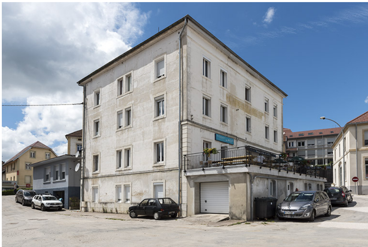
Immeuble : façades postérieure et latérale gauche.
