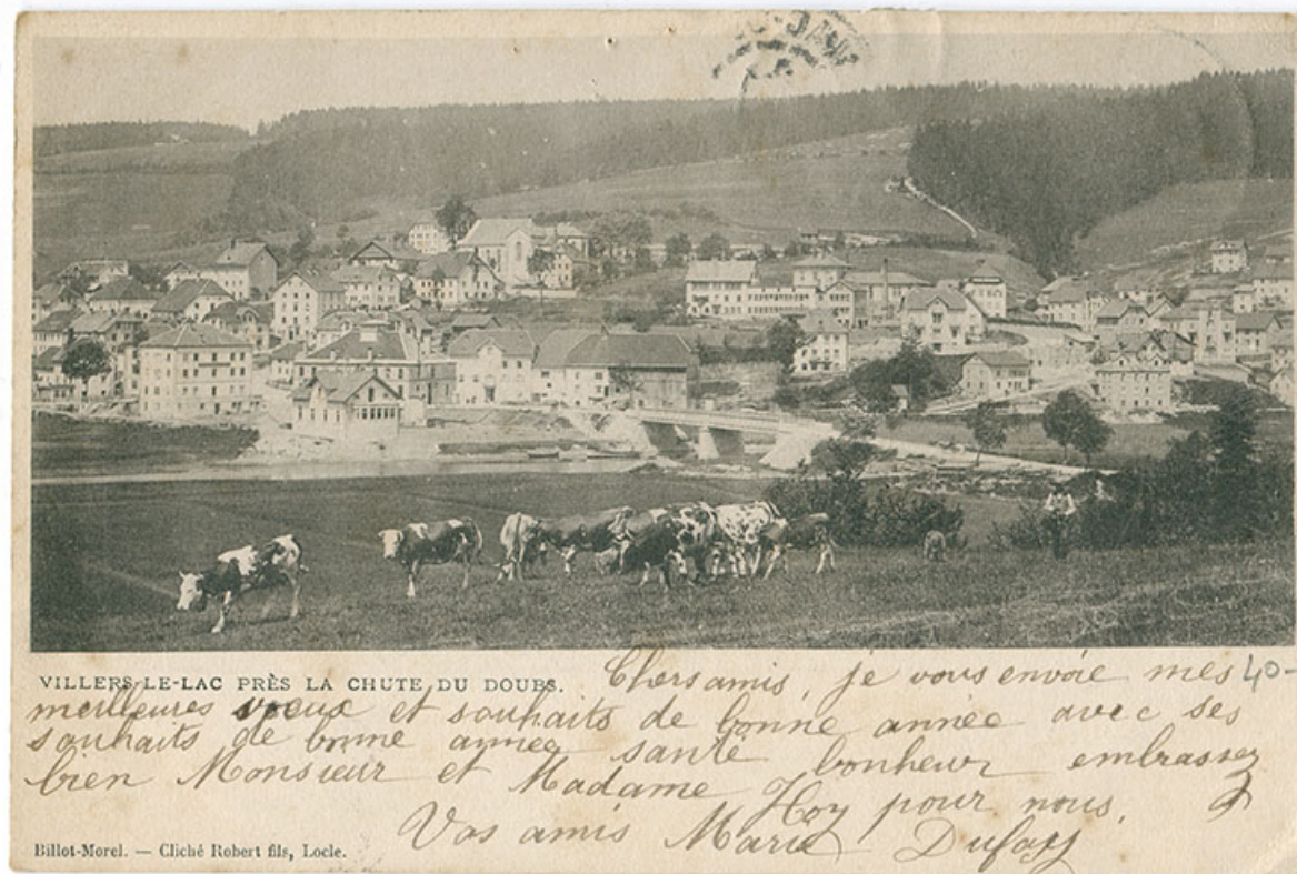
Villers-le-Lac près la chute du Doubs [vue d'ensemble du village depuis la rive droite, en amont du pont], 1898 ou 1899. Le bâtiment est visible dans la partie droite.
