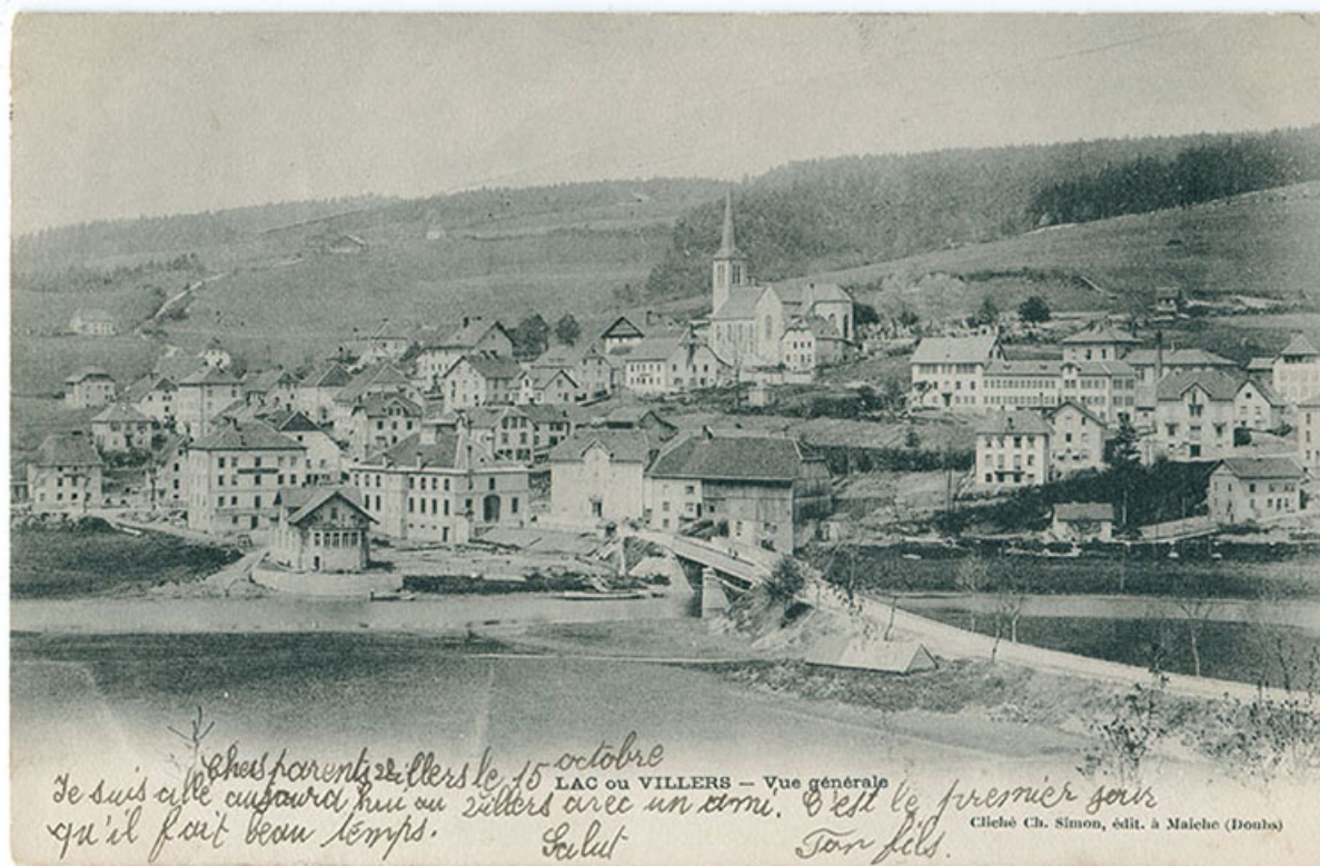
Lac ou Villers - Vue générale [le village, depuis l'est], 1902 ou 1903. Le bâtiment est visible au premier plan à droite. 25, Villers-le-Lac
