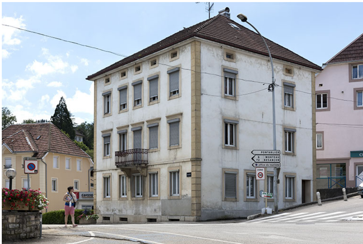
Façades antérieure et latérale droite. 25, Villers-le-Lac
