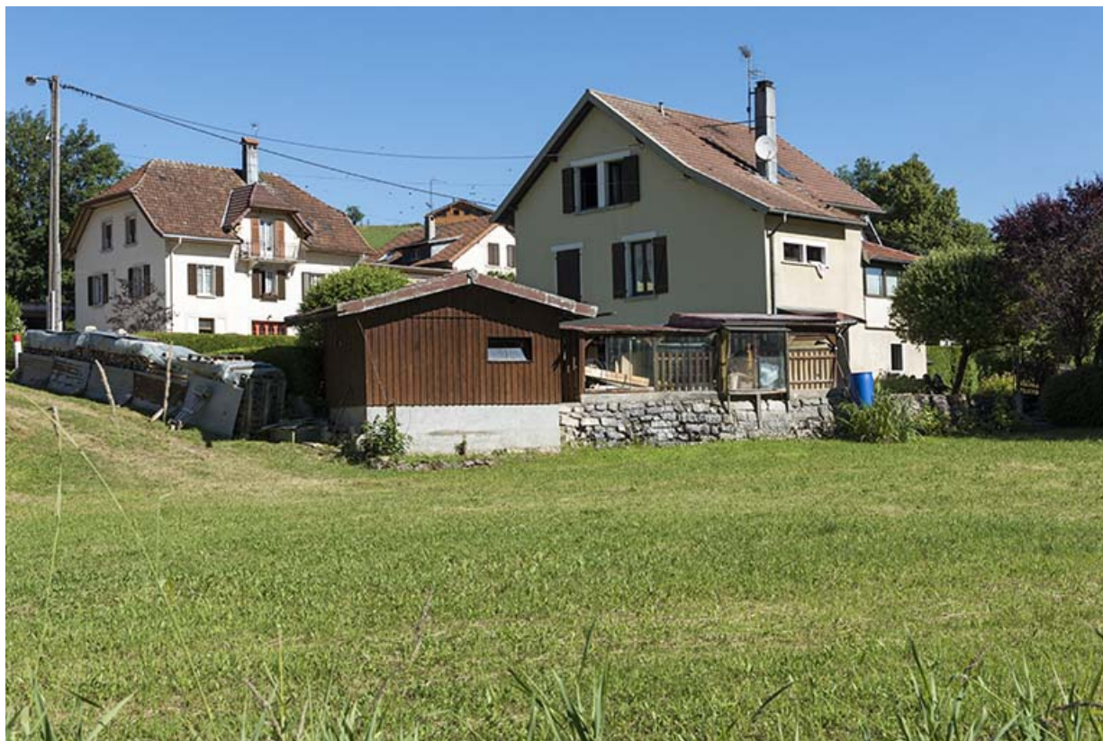
Vue d'ensemble, depuis le sud (façades postérieure et latérale droite).
