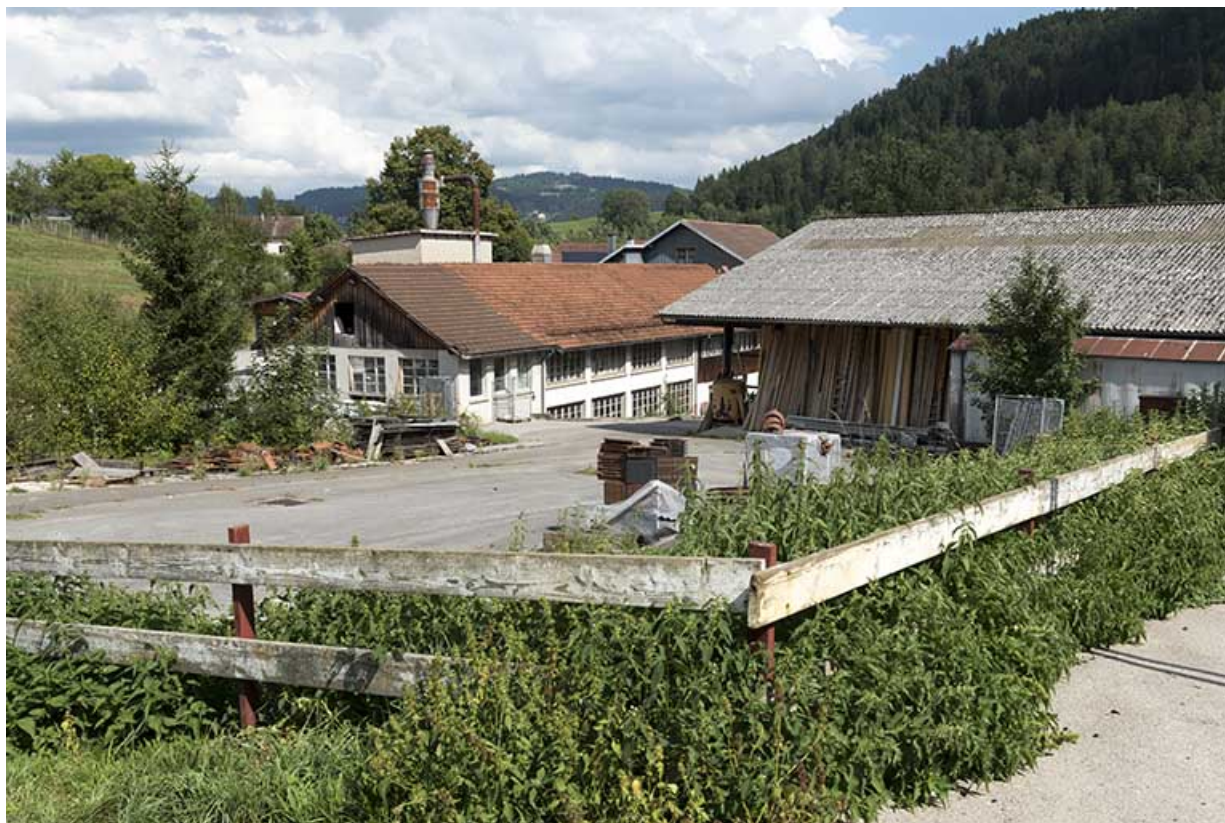
Site d'origine : atelier de fabrication nord et hangar industriel, depuis l'ouest. 25, Villers-le-Lac rue Pierre Berçot, lieudit : les Terres rouges
