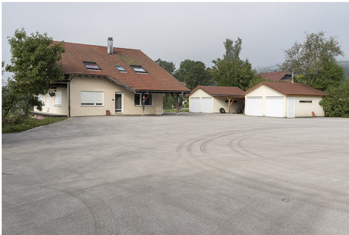
Nouveau site (route des Fins) : bureau, bureau d'études et garage.
