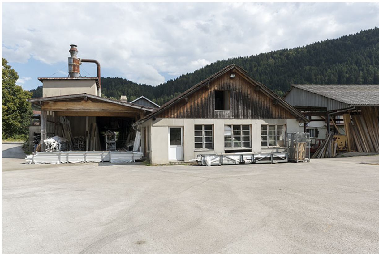
Site d'origine : façade postérieure de l'atelier de fabrication nord.
