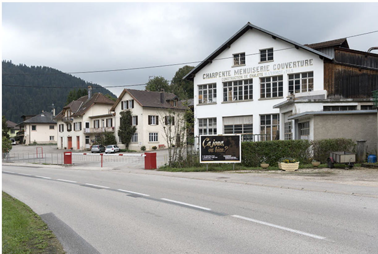
Site d'origine (rue Pierre Berçot) : vue d'ensemble, depuis le nord-est. 25, Villers-le-Lac rue Pierre Berçot, lieudit : les Terres rouges
