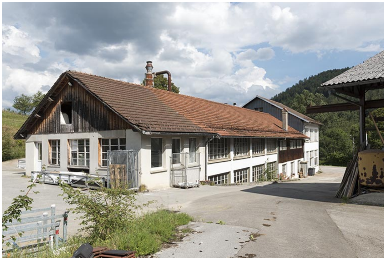
Site d'origine : façades postérieure et latérale gauche de l'atelier de fabrication nord. 25, Villers-le-Lac rue Pierre Berçot, lieudit : les Terres rouges
