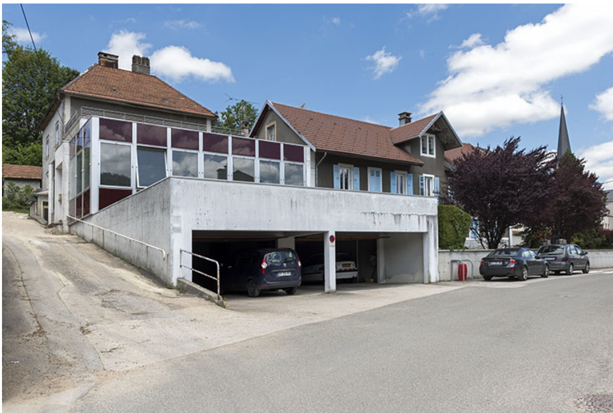
Vue d'ensemble, depuis le sud-ouest (garage, atelier et maison à gauche, extension à droite). 25, Villers-le-Lac, 4-8 rue Pasteur
