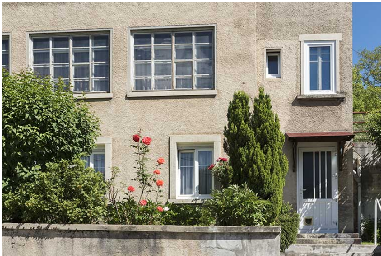
Façade sud : entrée à droite.
