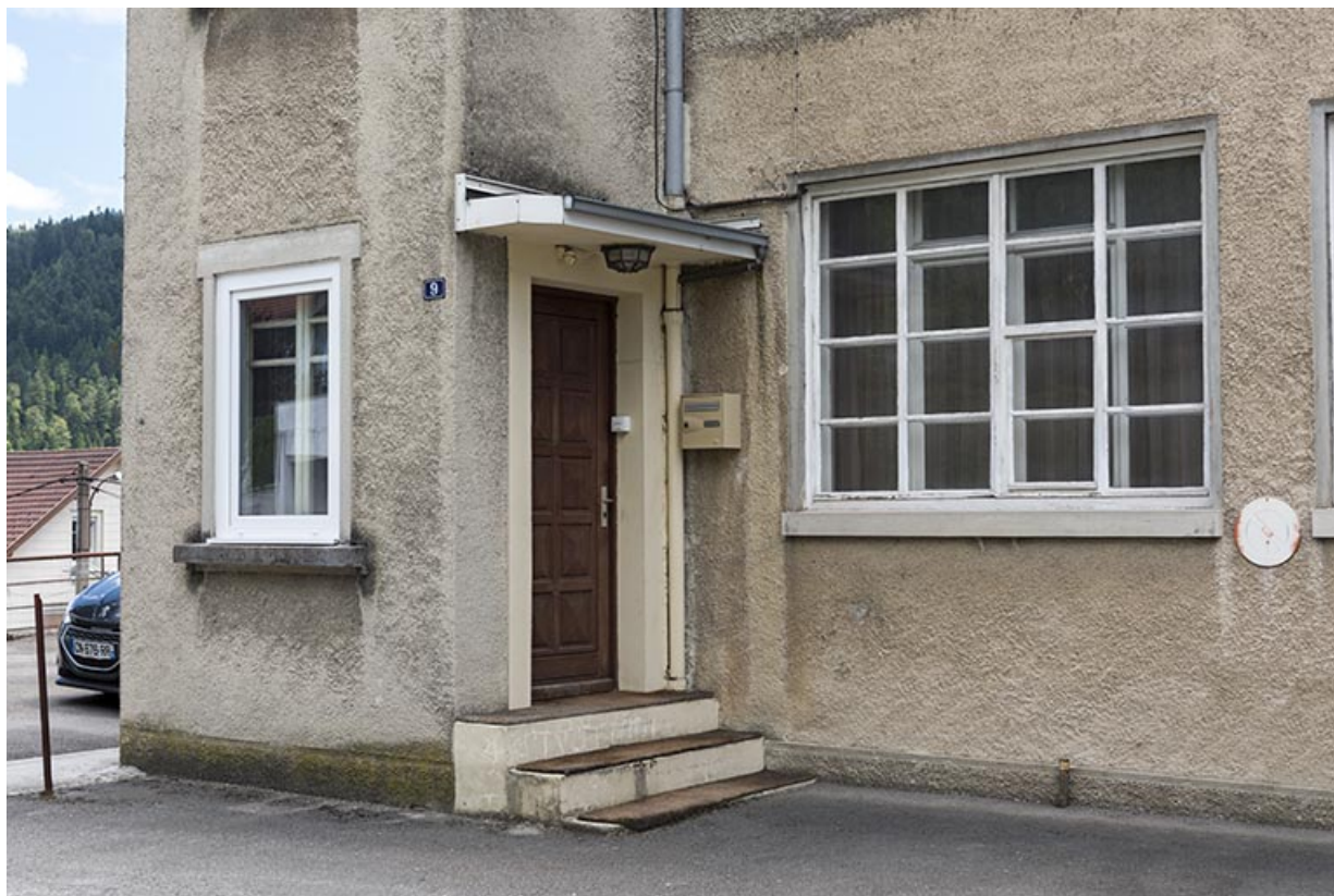
Façade nord : entrée rue Pasteur. 25, Villers-le-Lac, 12 Grande Rue
