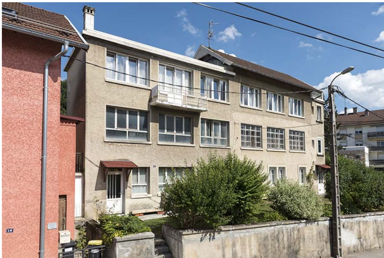
Façade sud, de trois quarts gauche.
