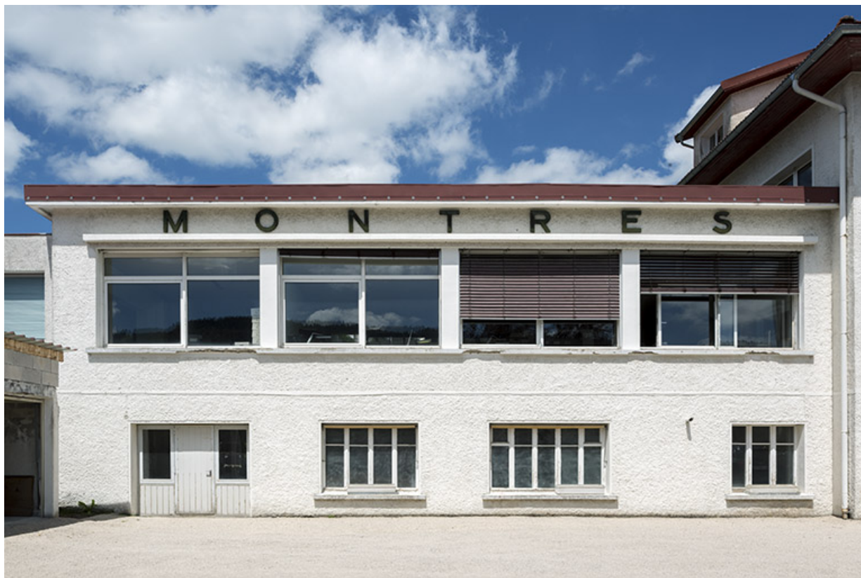
Façade antérieure de l'usine.
