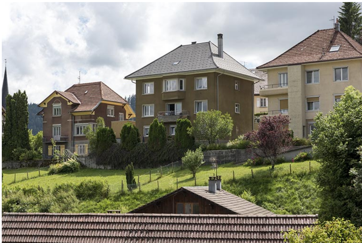
Vue d'ensemble depuis le nord-est (façades postérieure et latérale gauche). 25, Villers-le-Lac, 10 rue des Genévriers
