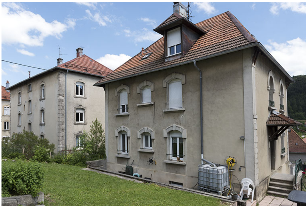
Vue d'ensemble, depuis l'ouest (façades postérieure et latérale gauche). 25, Villers-le-Lac, 7 rue Virgile Cupillard
