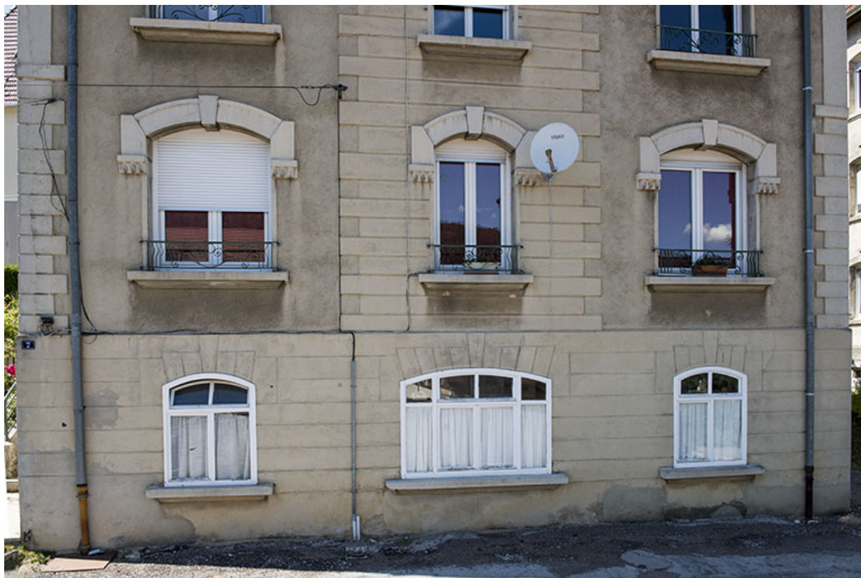
Façade antérieure : baies de l'étage de soubassement (atelier de Léon Vuillemin) et du rez-de-chaussée surélevé (atelier d'Alfred Bonnet).
