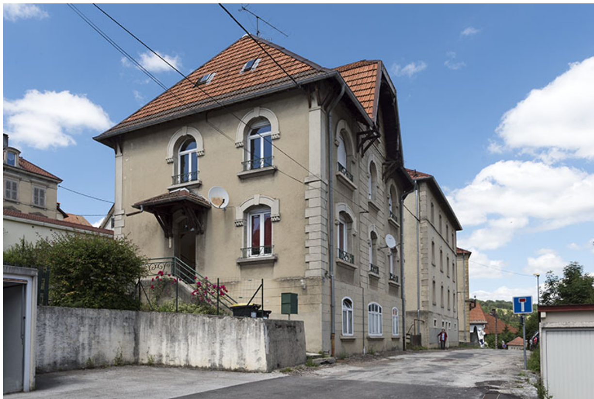
Vue d'ensemble, depuis le sud (façades antérieure et latérale gauche). 25, Villers-le-Lac, 7 rue Virgile Cupillard
