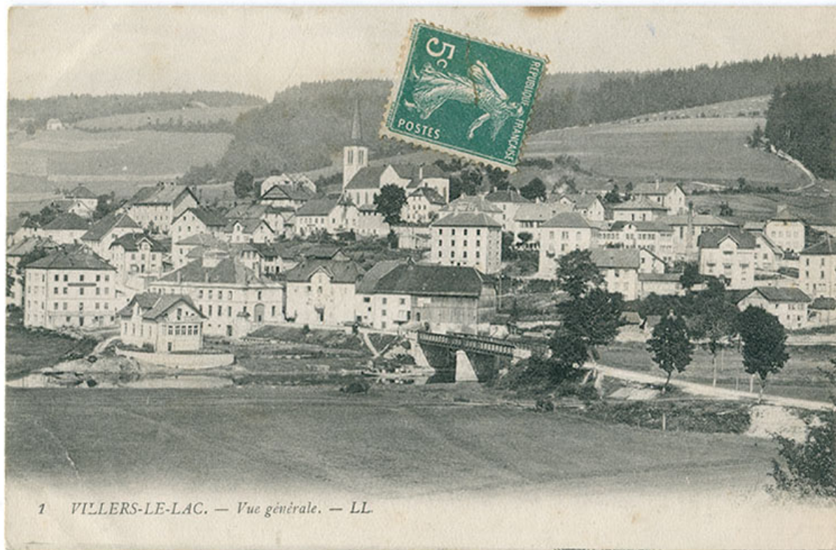
1 Villers-le-Lac. - Vue générale [vue d'ensemble, depuis l'est], 1er quart 20e siècle. Le bâtiment est visible au centre, sous le timbre. 25, Villers-le-Lac, 9 rue Virgile Cupillard
