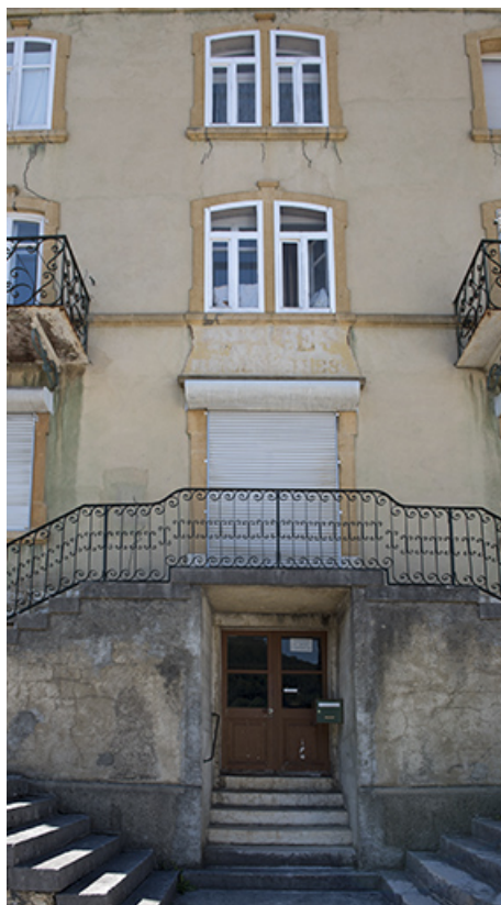
Façade antérieure : travée centrale et escalier. 25, Villers-le-Lac, 11 rue Virgile Cupillard
