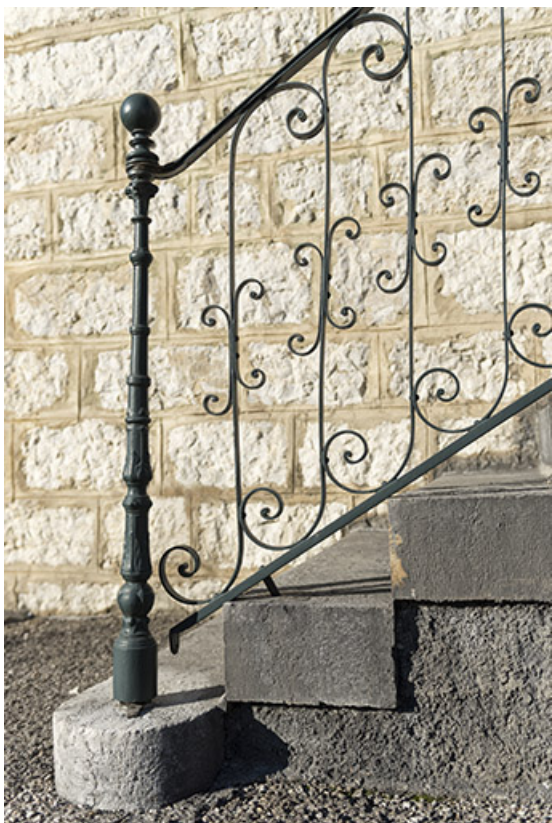
Façade antérieure : garde-corps de l'escalier.
