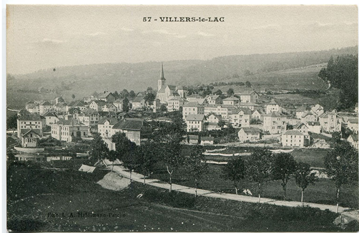
57 - Villers-le-Lac [vue d'ensemble, depuis l'est], 1er quart 20e siècle [entre 1908 et 1914 ?]. Les bâtiments sont visibles au centre, entre les Ets Lambert et Parrenin.
