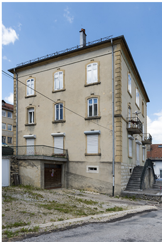
Façade latérale gauche, de trois quarts.
