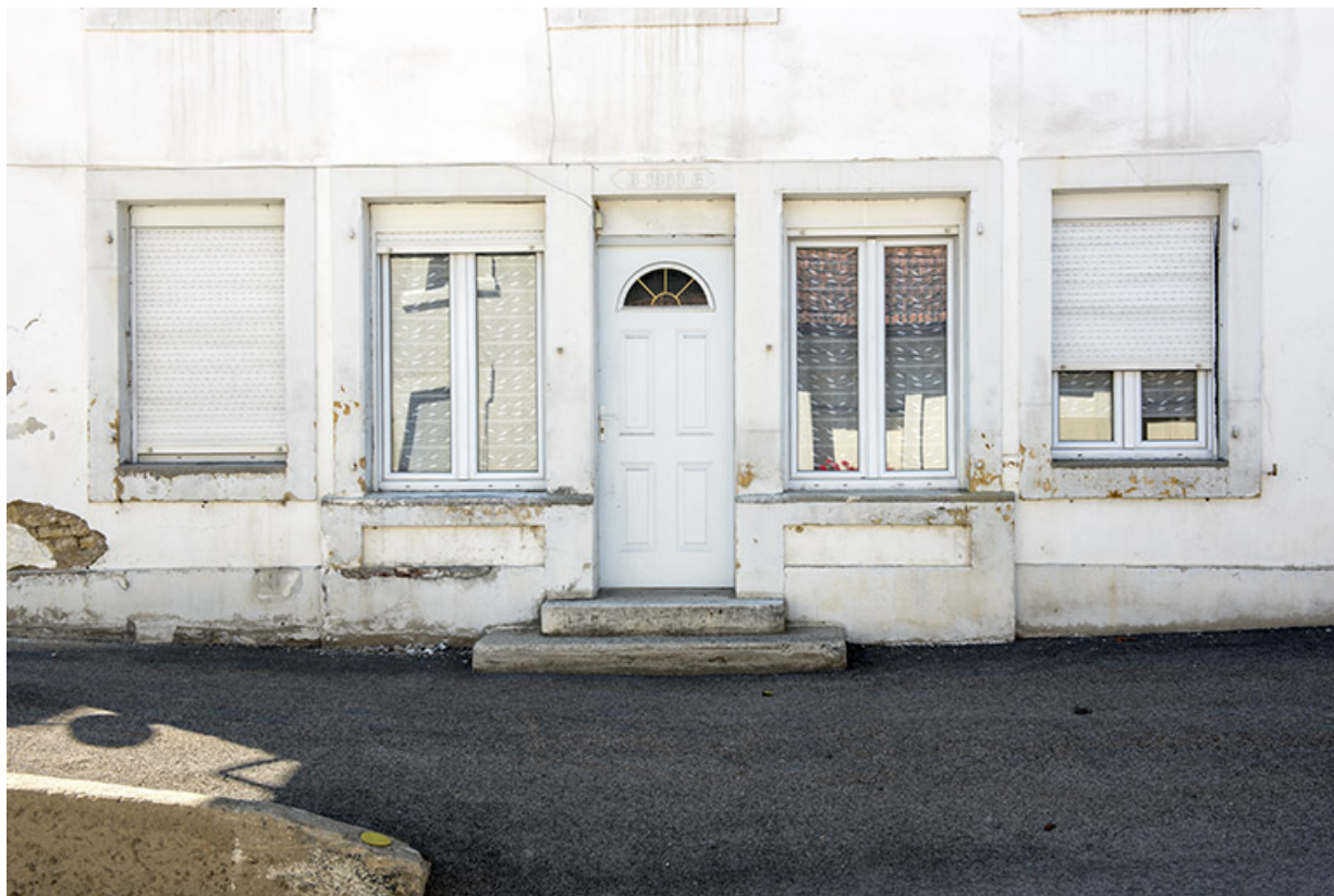
Façade antérieure : baies de l'étage de soubassement.
