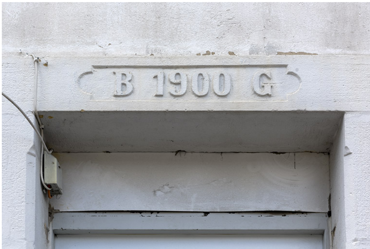
Façade antérieure, étage de soubassement : date et initiales sur le linteau de la porte.
