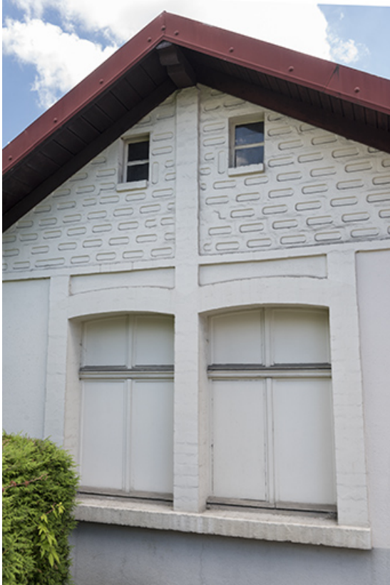
Atelier de fabrication de 1905 environ : mur pignon, avec fenêtre horlogère et briques silico-calcaires. 25, Villers-le-Lac, 6 rue du Maréchal Foch
