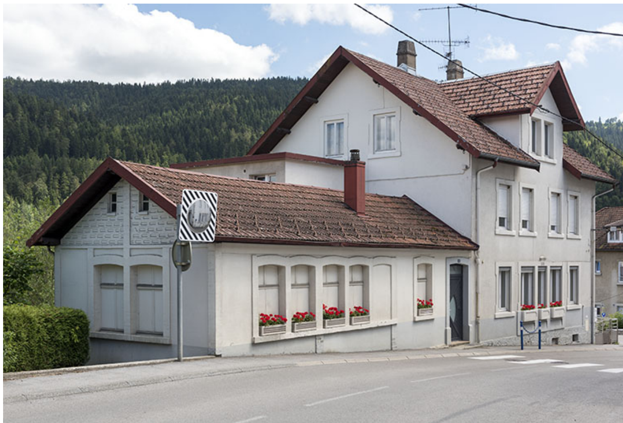
Façades antérieure et latérale gauche.
