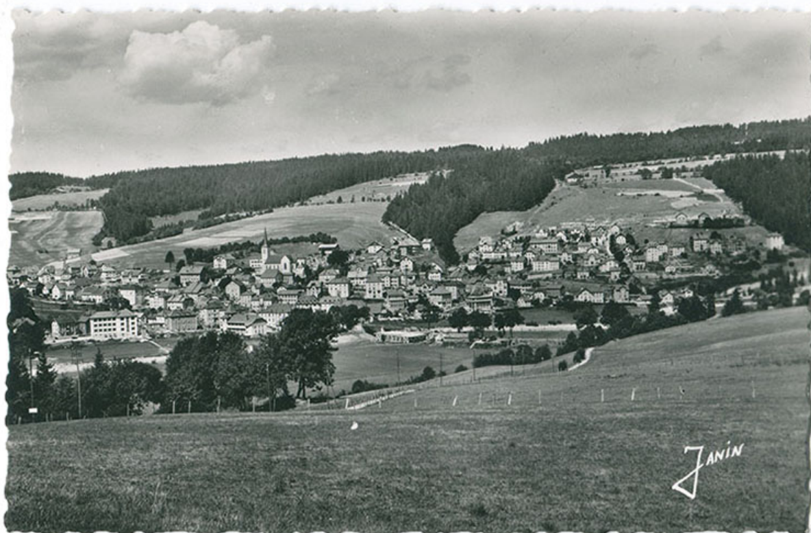
Frontière franco-suisse. 105 - Vue générale de Villers-le-Lac [depuis le sud], entre 1948 et 1952. Le bâtiment rehaussé est visible au centre droit de l'image.
