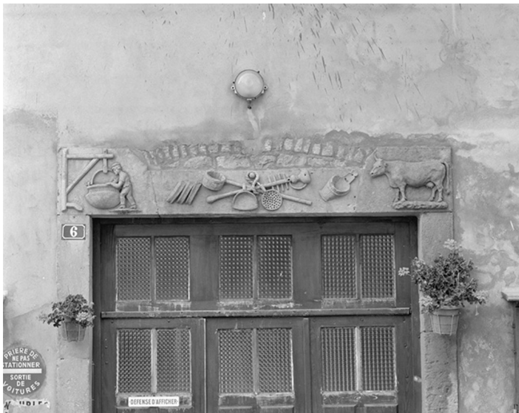
Linteau de la porte d'entrée.
