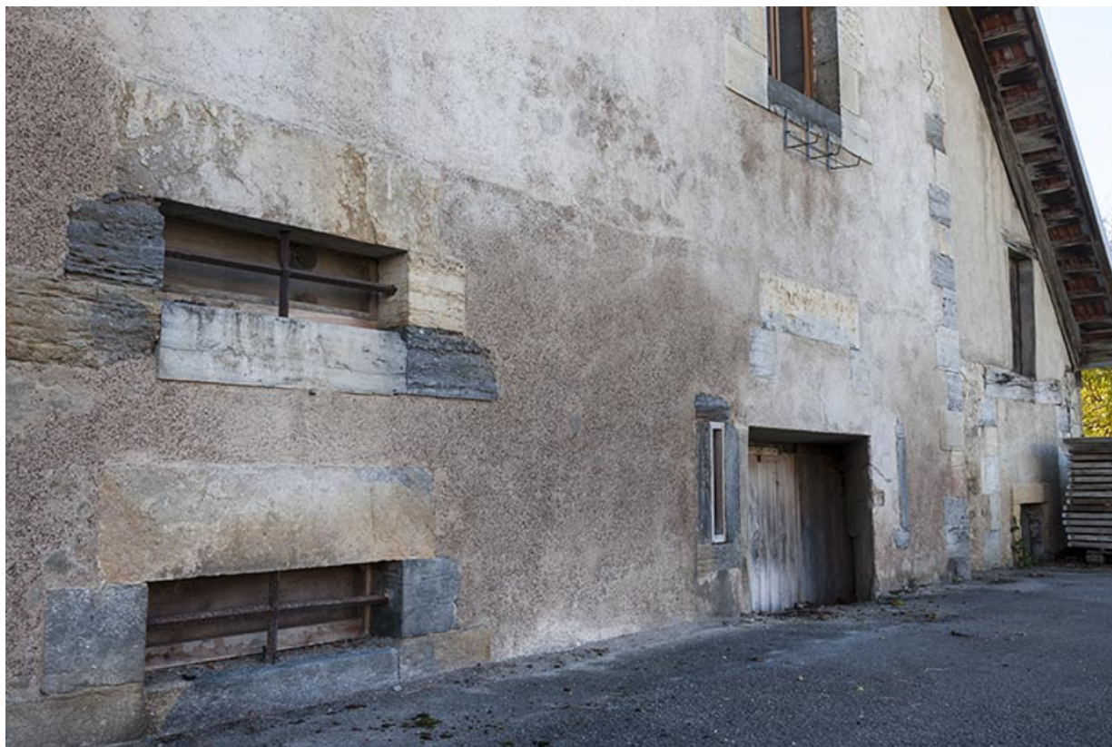
Ouvertures (caves d'affinage) sur la façade postérieure.
