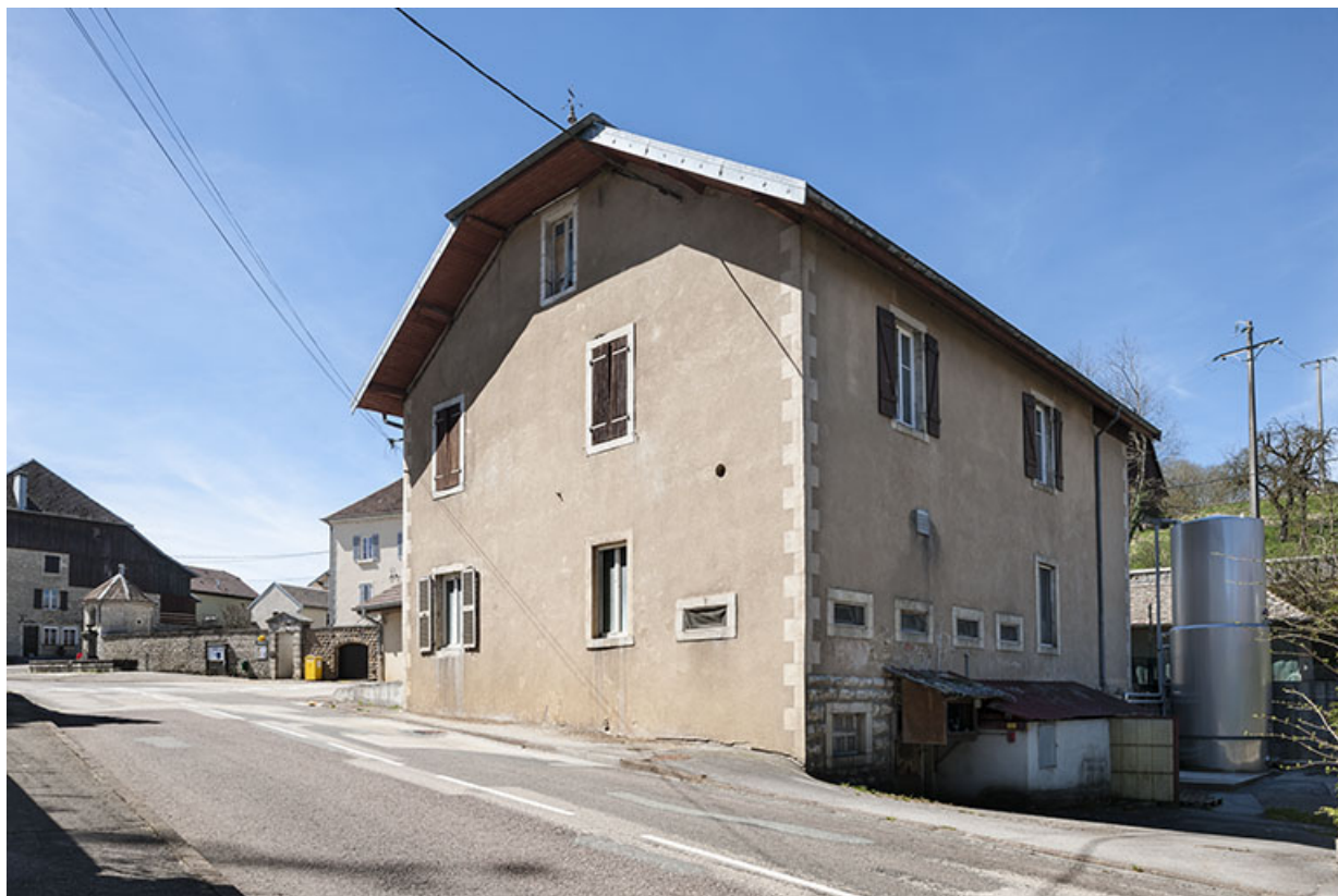
Vue de trois quarts arrière. 25, Ouhans, 2 rue du Moulin
