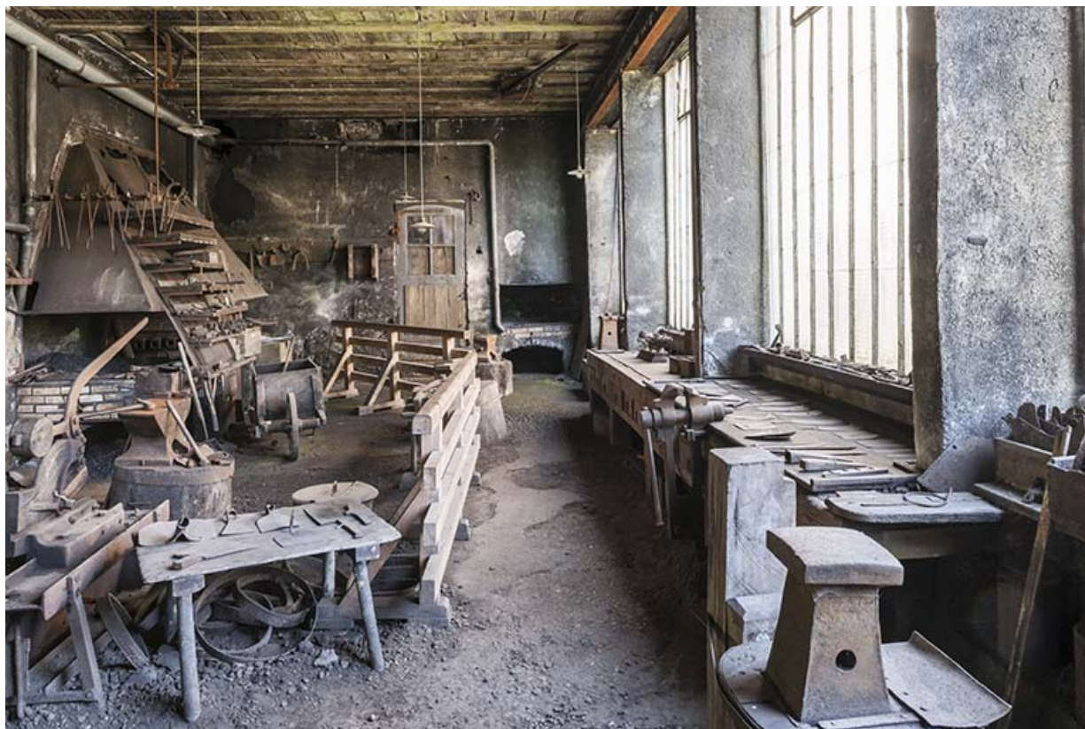
Partie ouest de l'atelier des martinets.
