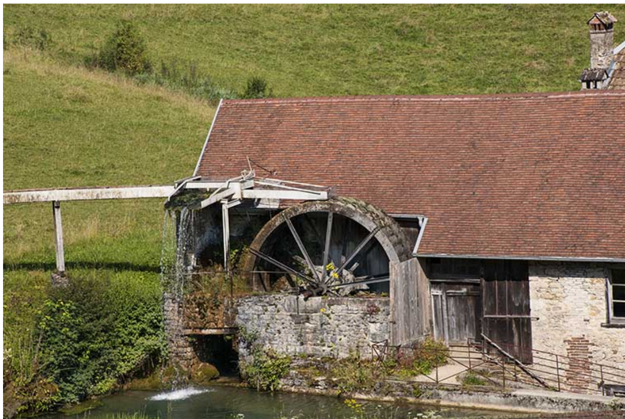
Roue hydraulique de la machine soufflante.
