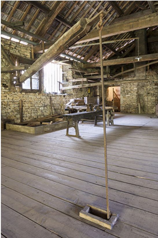
Système de commande pour l'admission de l'eau sur la roue (est) des martinets. 25, Nans-sous-Sainte-Anne rue du Four
