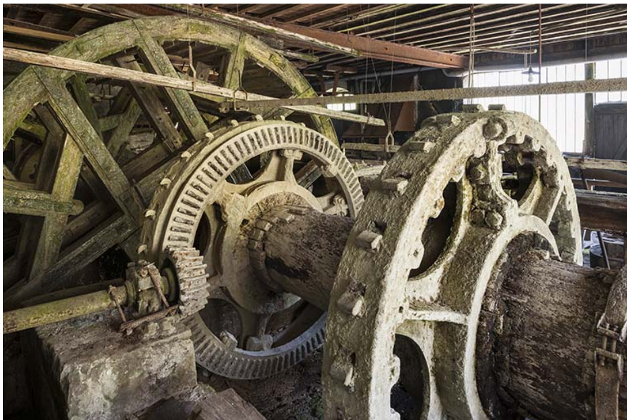
Arbre de couche couplé à la roue hydraulique. Au premier plan, couronne porte cames. 25, Nans-sous-Sainte-Anne rue du Four
