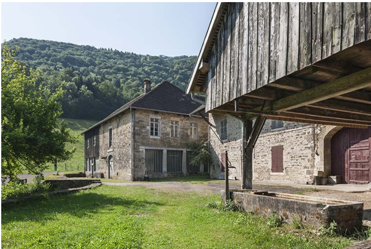
Atelier de fabrication vu de trois quarts droite.
