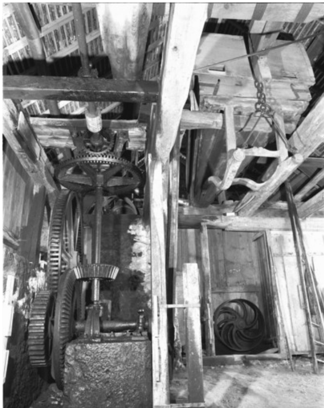
Vue d'un soufflet et du mécanisme.
