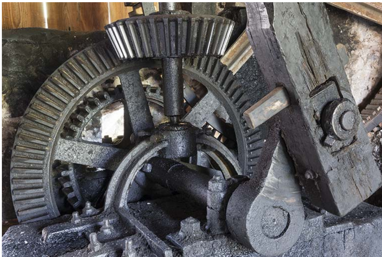
Mécanisme de transmission de la machine soufflante. Détail du système bielle-manivelle. 25, Nans-sous-Sainte-Anne rue du Four
