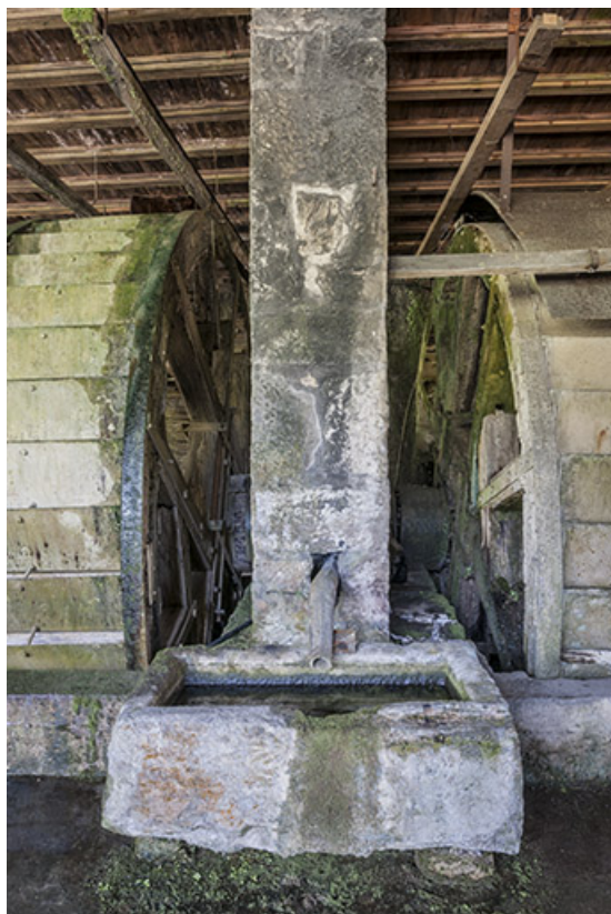
Les roues hydrauliques des martinets de part et d'autre du pilier central.
