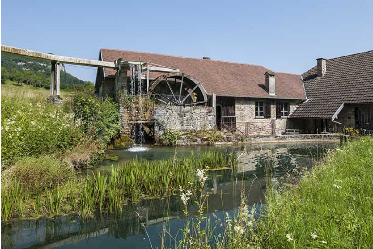
Bâtiment de la machine soufflante (avec sa roue hydraulique) et de l'atelier de mécanique. 25, Nans-sous-Sainte-Anne rue du Four
