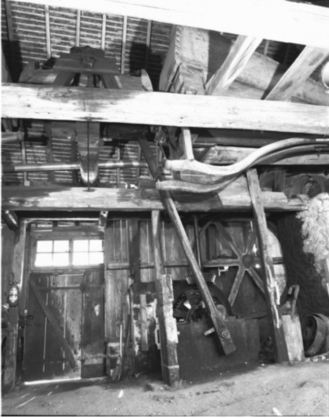
Vue du mécanisme des soufflets depuis le fond de l'atelier.
