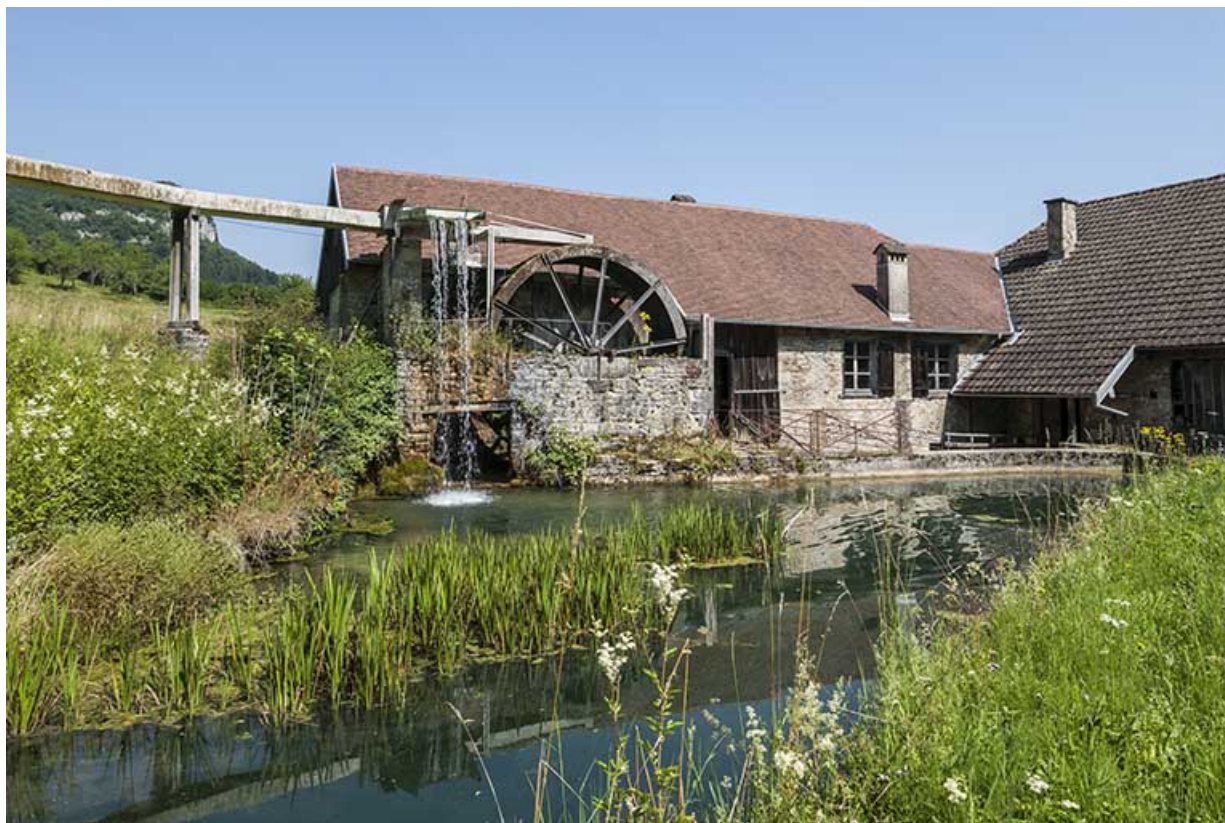
Bâtiment de la machine soufflante (avec sa roue hydraulique) et de l'atelier de mécanique. 25, Nans-sous-Sainte-Anne rue du Four
