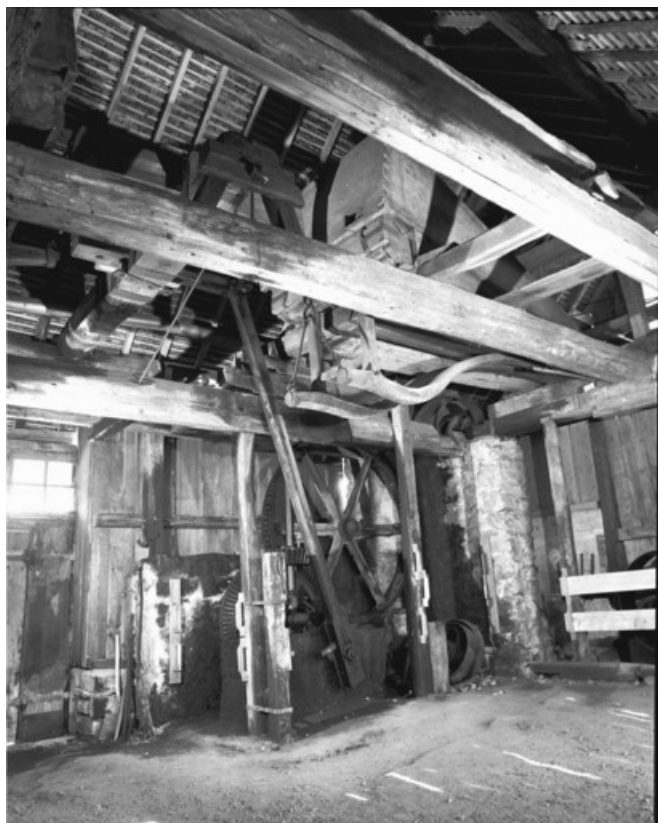
Vue d'ensemble du mécanisme et des soufflets de trois quarts gauche. 25, Nans-sous-Sainte-Anne rue du Four
