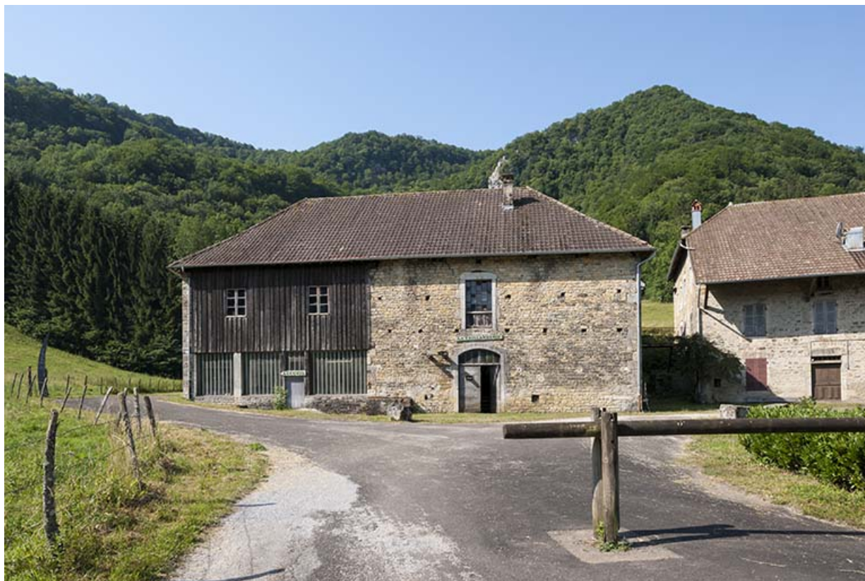
Façade antérieure de l'atelier de fabrication. 25, Nans-sous-Sainte-Anne rue du Four
