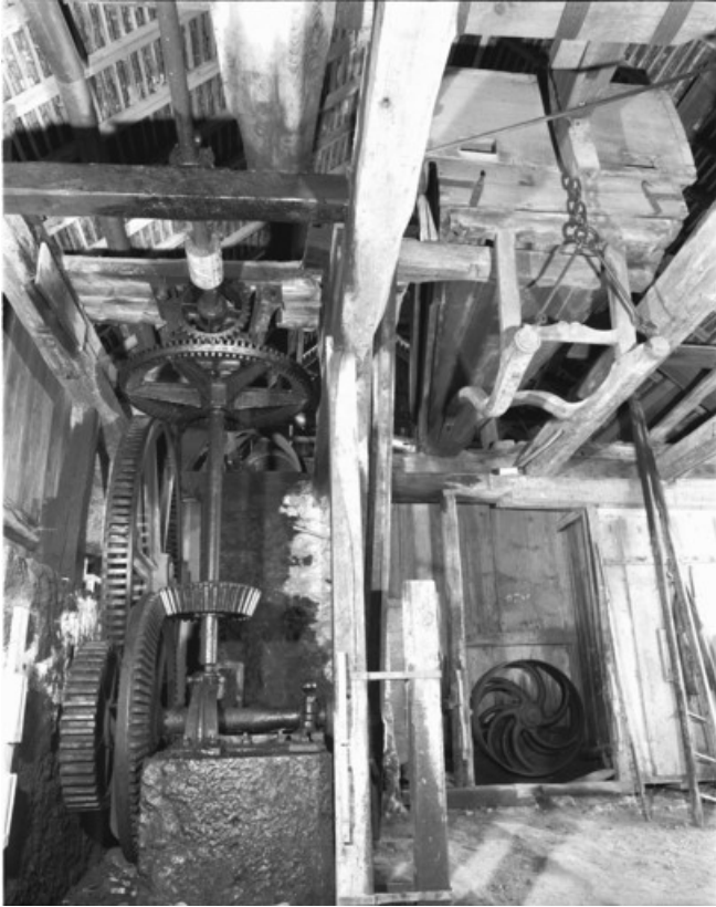
Vue d'un soufflet et du mécanisme.
