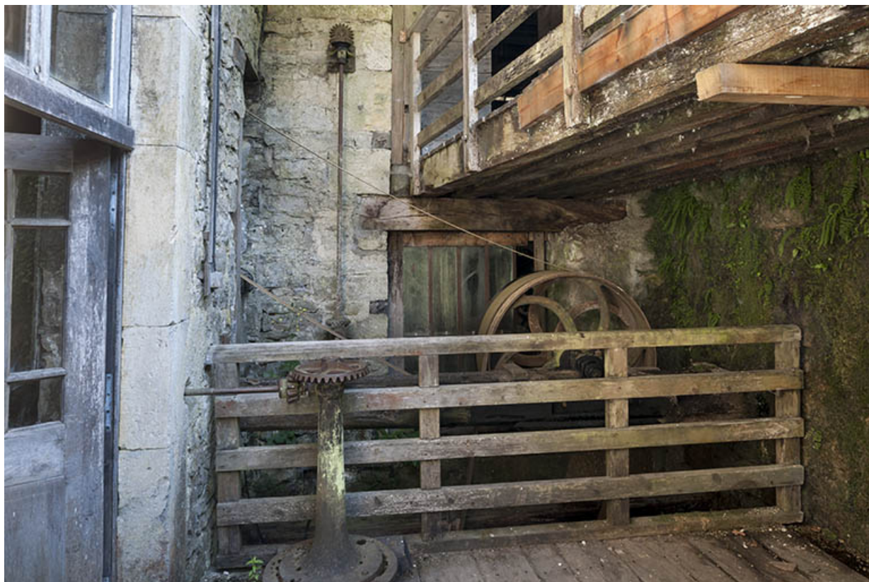
Aplomb de la turbine hydraulique, transmission par courroie et système de contrôle de l'admission d'eau. 25, Nans-sous-Sainte-Anne rue du Four
