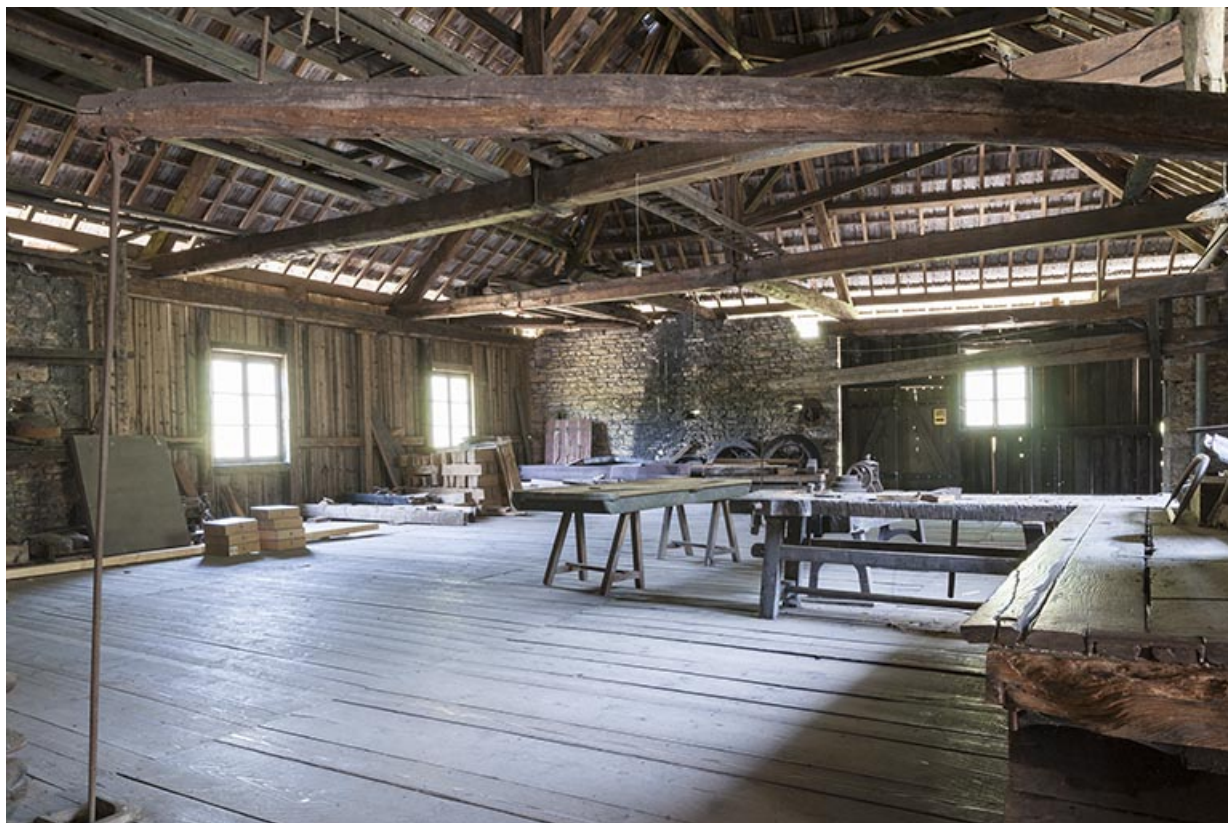
Etage supérieur de l'atelier de forge. Système de commande pour l'admission de l'eau sur la roue (ouest) des martinets. 25, Nans-sous-Sainte-Anne rue du Four
