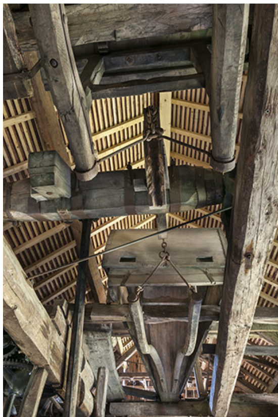
Mécanisme de bascule du soufflet double (caisson sud en position haute). 25, Nans-sous-Sainte-Anne rue du Four
