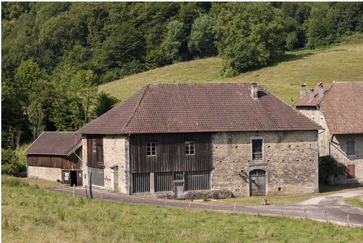
Façade nord de l'atelier de fabrication.
