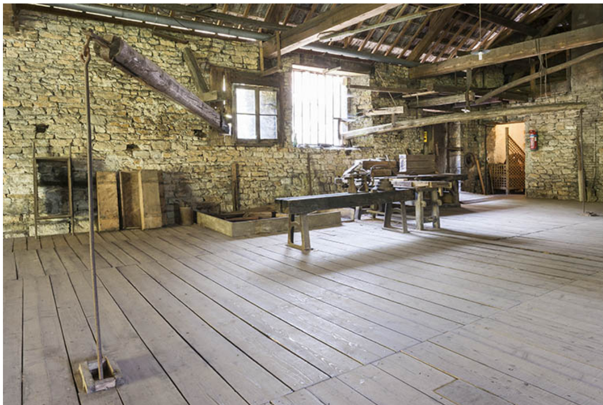
Etage supérieur de l'atelier de forge. A gauche, tige et bras de commande pour l'admission de l'eau sur les roues des martinets. 25, Nans-sous-Sainte-Anne rue du Four
