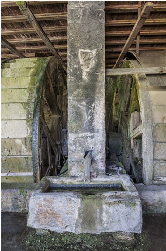
Les roues hydrauliques des martinets de part et d'autre du pilier central.
