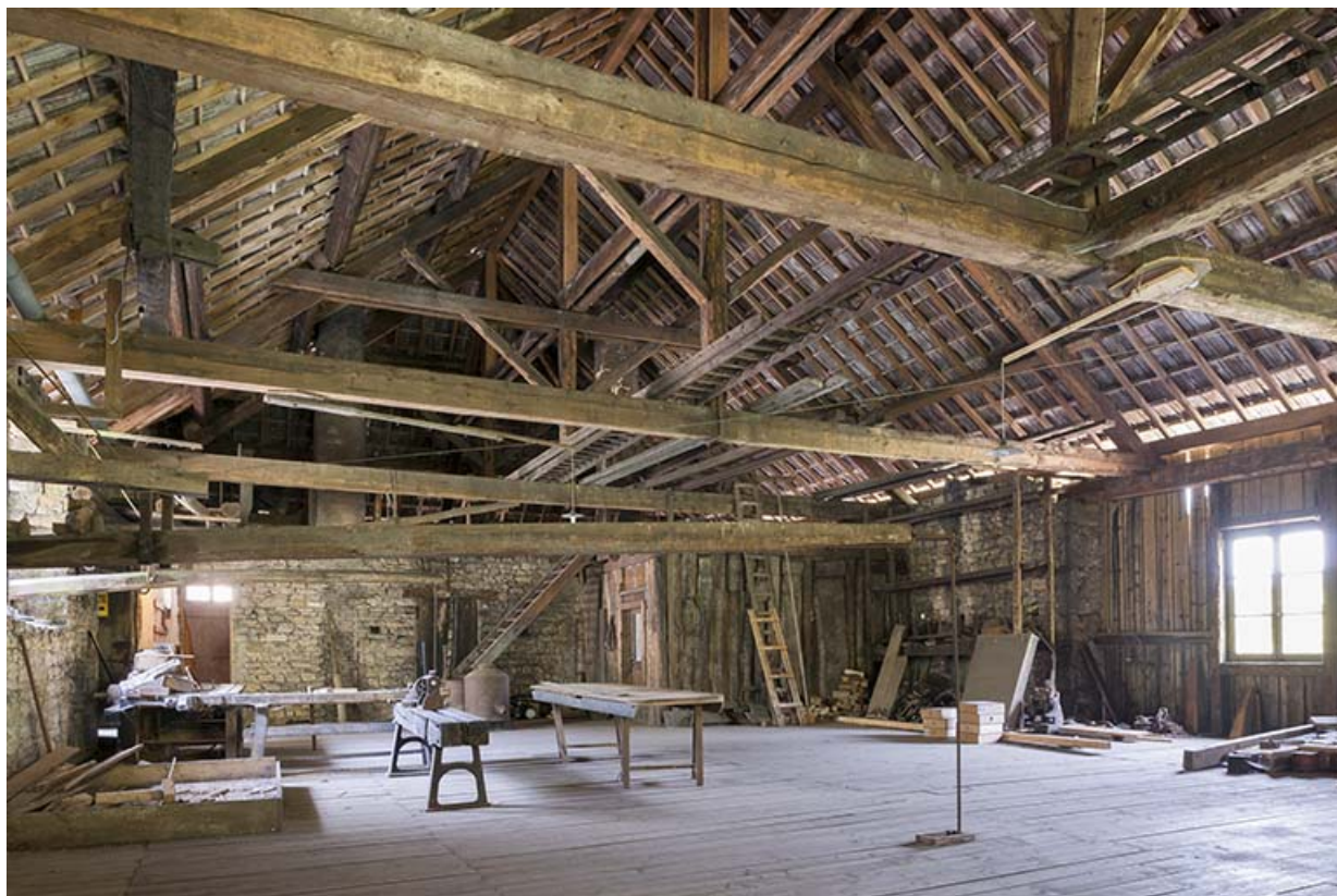
Vue d'ensemble de l'étage supérieur de l'atelier de forge.
