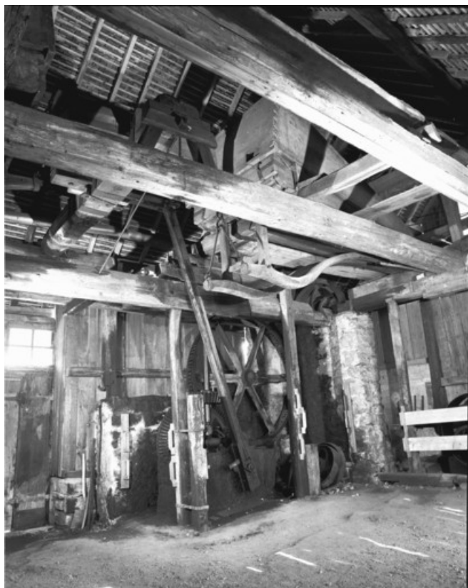
Vue d'ensemble du mécanisme et des soufflets de trois quarts gauche. 25, Nans-sous-Sainte-Anne rue du Four
