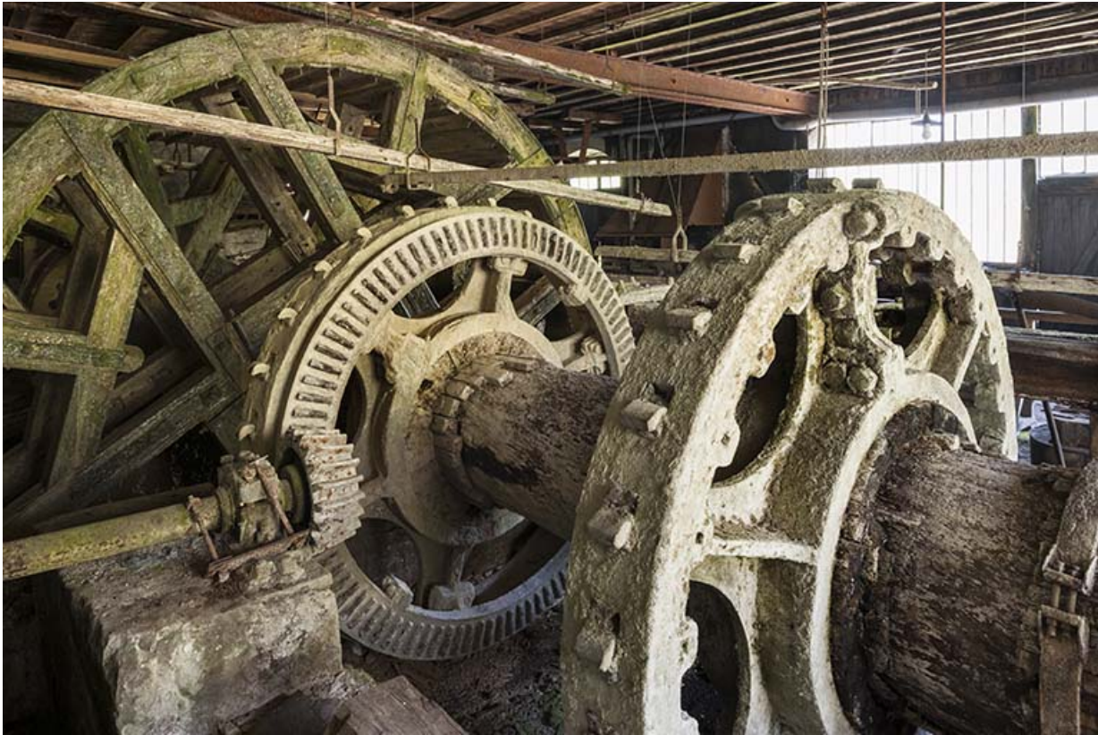
Arbre de couche couplé à la roue hydraulique. Au premier plan, couronne porte cames. 25, Nans-sous-Sainte-Anne rue du Four
