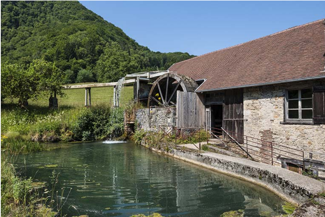
Bassin de retenue et bâtiment de la machine soufflante.
