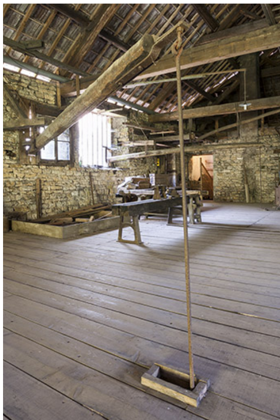
Système de commande pour l'admission de l'eau sur la roue (est) des martinets. 25, Nans-sous-Sainte-Anne rue du Four
