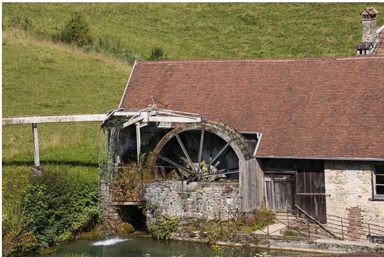
Roue hydraulique de la machine soufflante.
