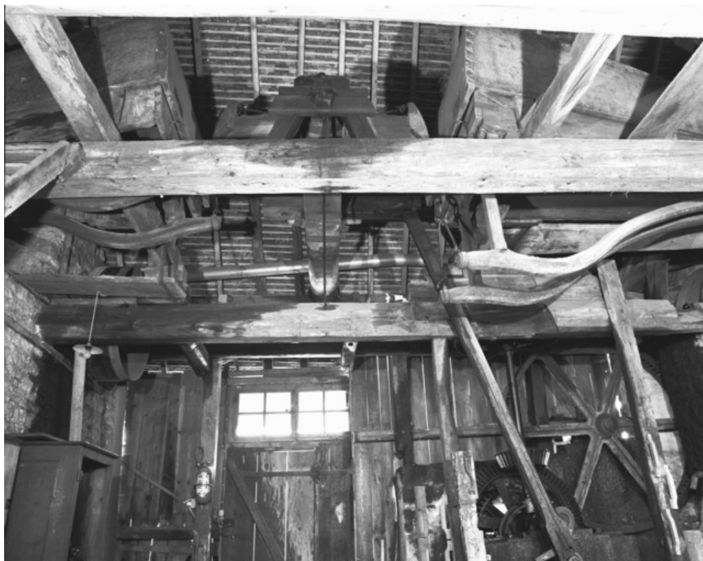
Vue des installations face à la porte d'entrée du local de soufflerie.
