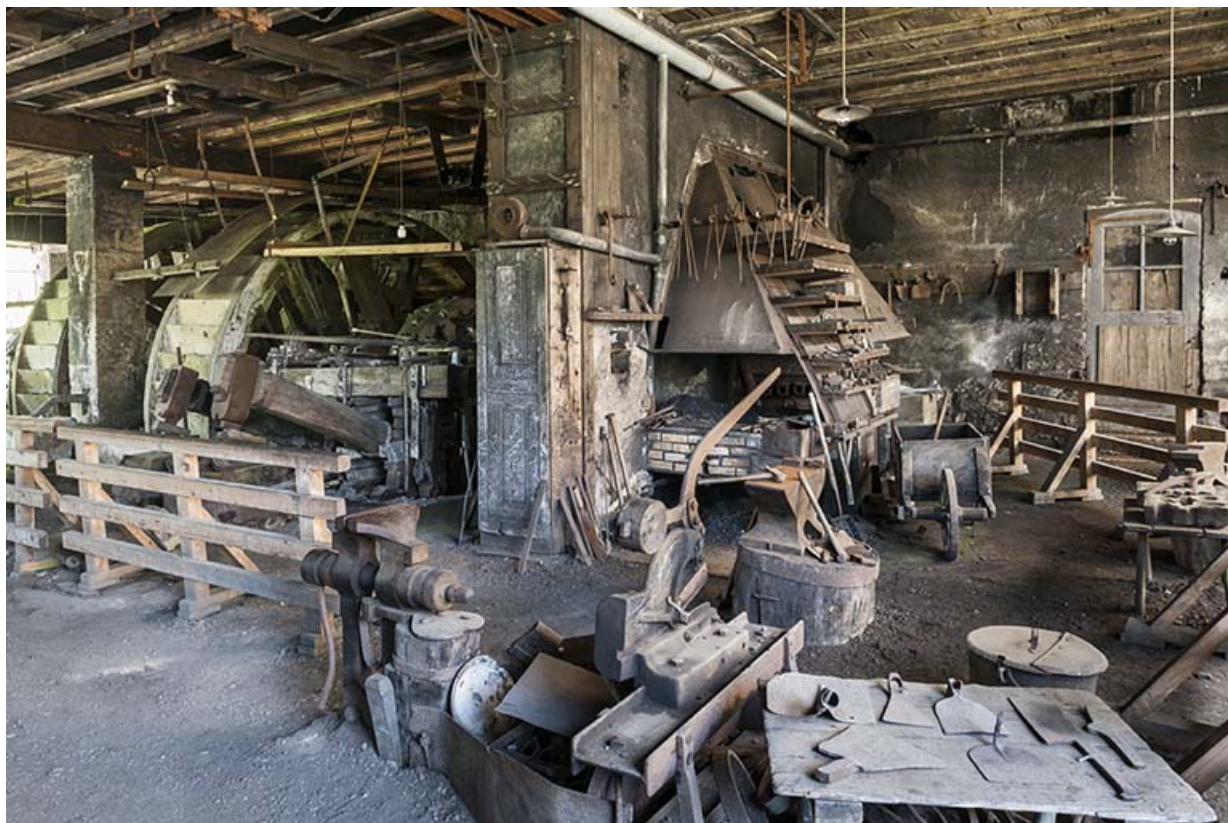
Atelier de forge. Vue d'ensemble depuis le nord. 25, Nans-sous-Sainte-Anne rue du Four
