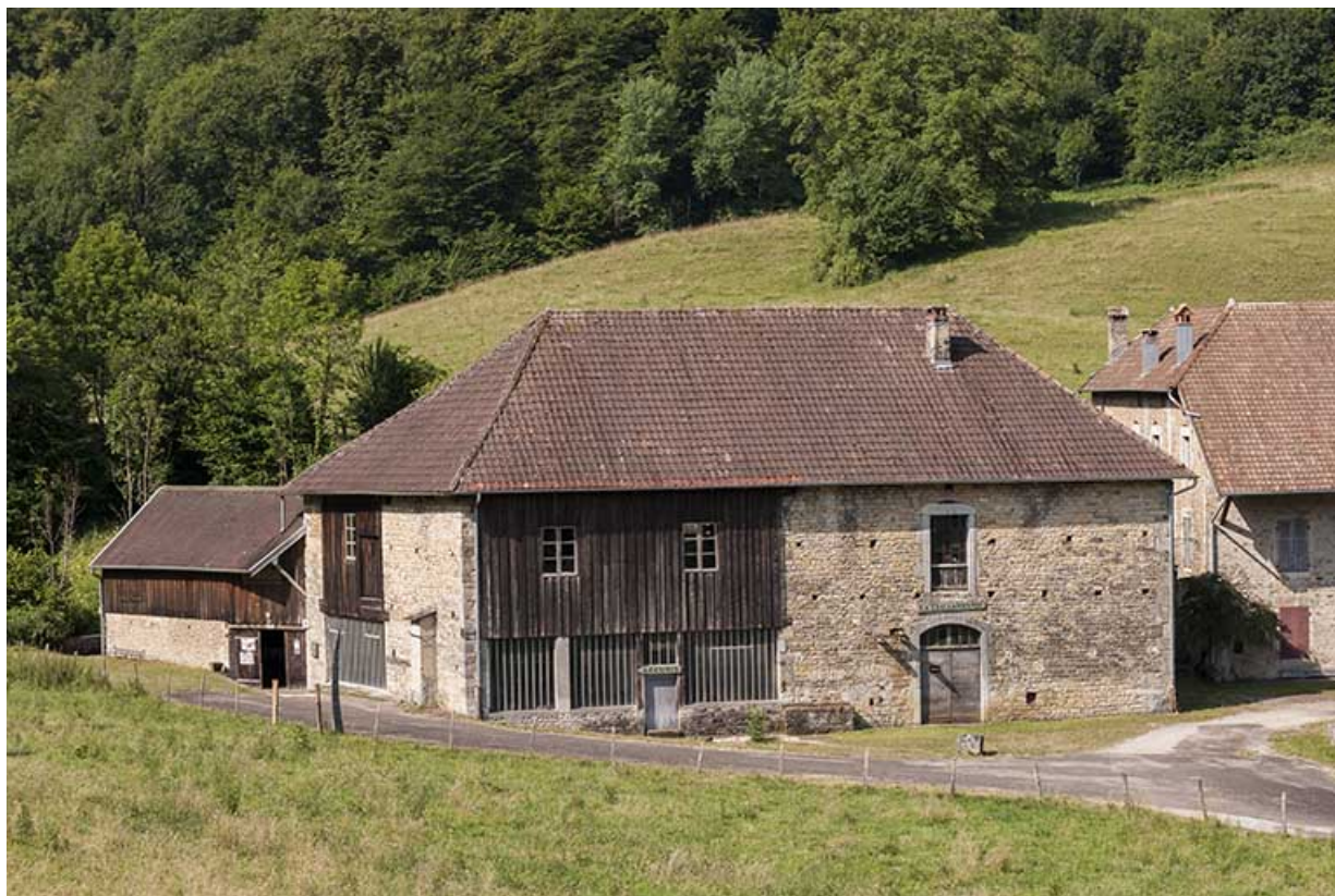
Façade nord de l'atelier de fabrication.
