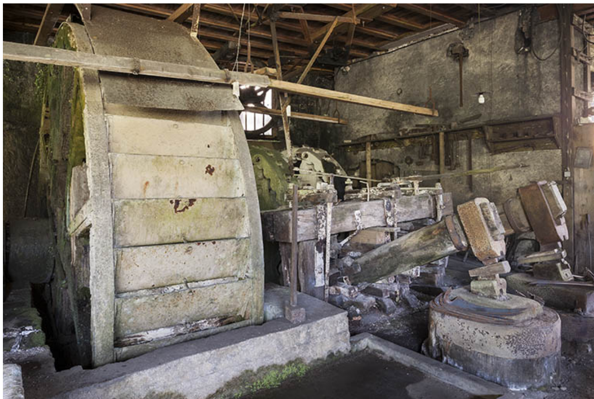
Roue hydraulique et les deux martinets ouest.
