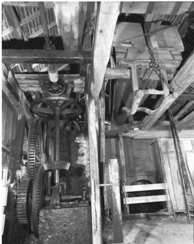
Vue d'un soufflet et du mécanisme.
