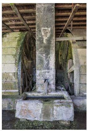
Les roues hydrauliques des martinets de part et d'autre du pilier central. 25, Nans-sous-Sainte-Anne rue du Four
