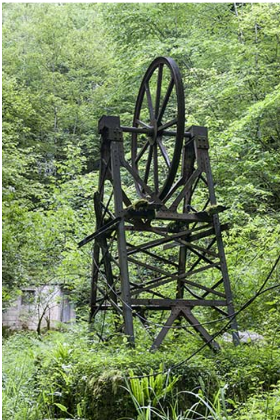
Support métallique (amont) de la transmission par câble. 25, Éternoz, 4 rue du Moulin
