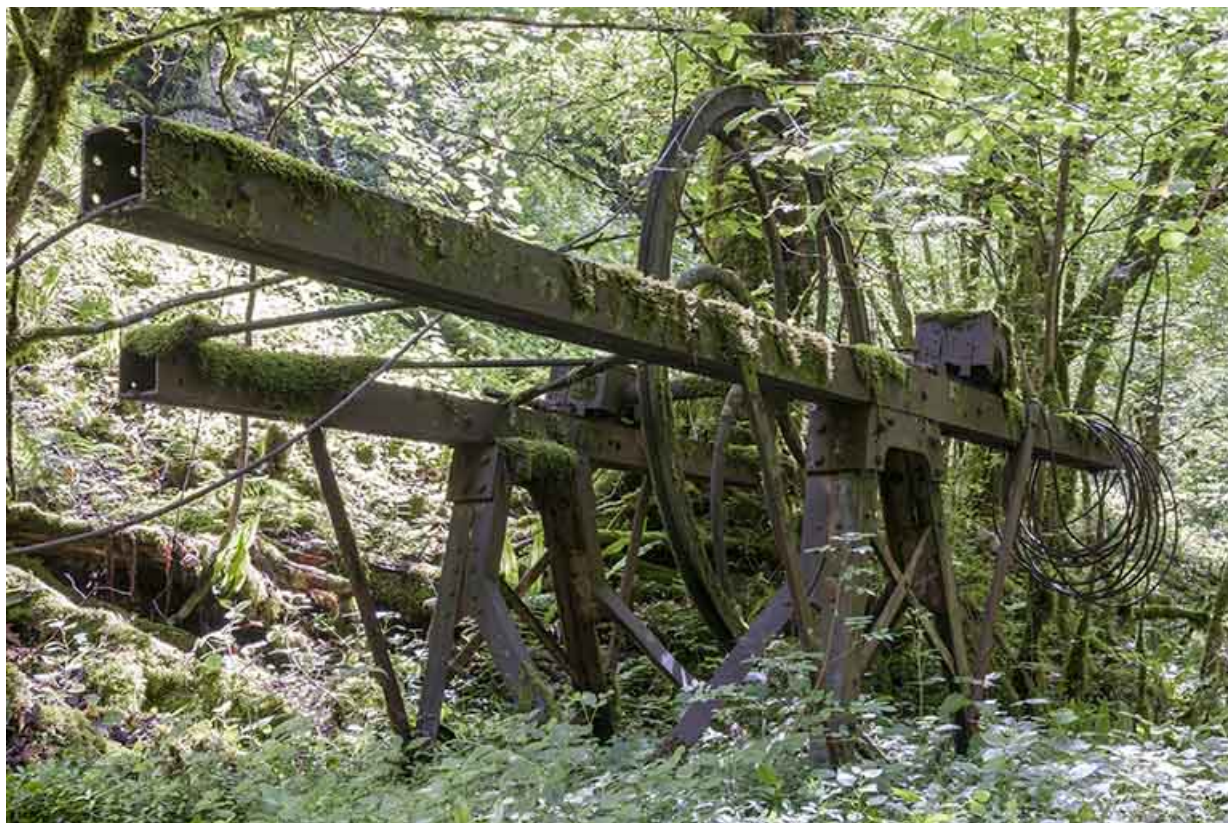
Support métallique (aval) de la transmission par câble.
