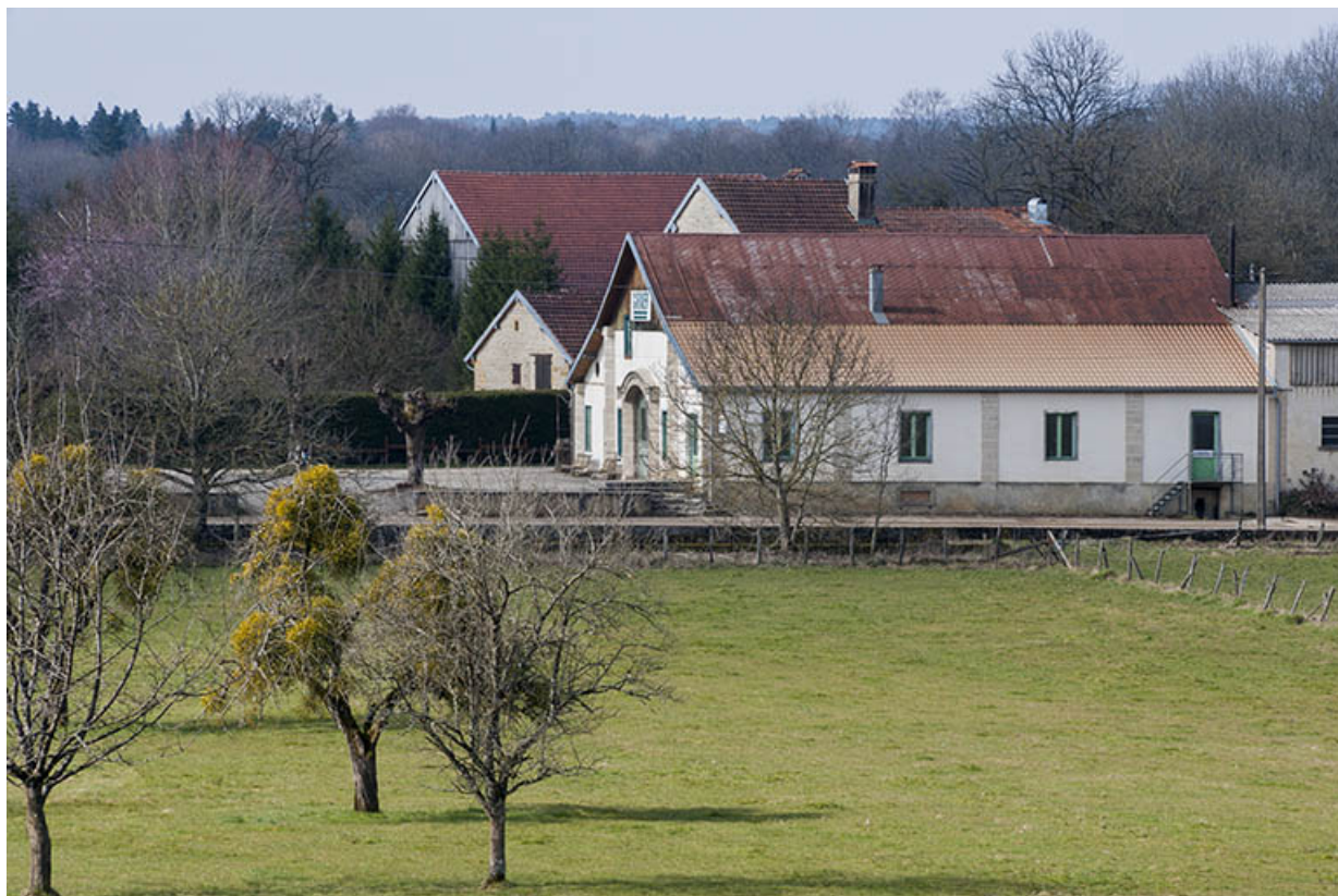
Façade nord de l'atelier de fabrication.
