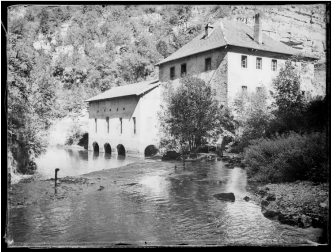
Vue d'ensemble depuis l'aval, fotogr., s.d. [vers 1930].
