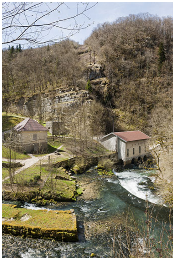
Vue d'ensemble plongeante depuis le sud.
