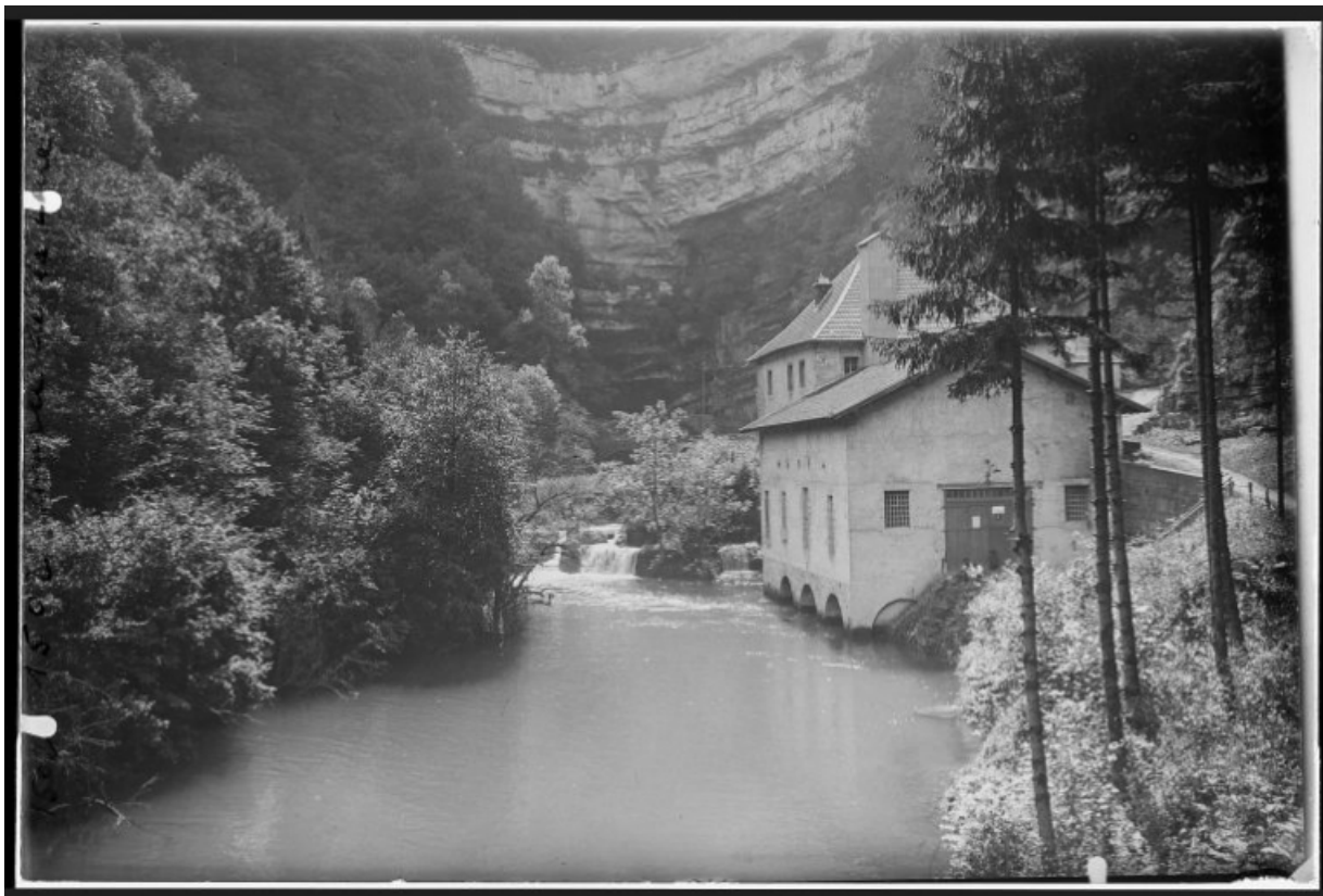
Vue d'ensemble depuis l'aval, fotogr., s.d. [vers 1930].
