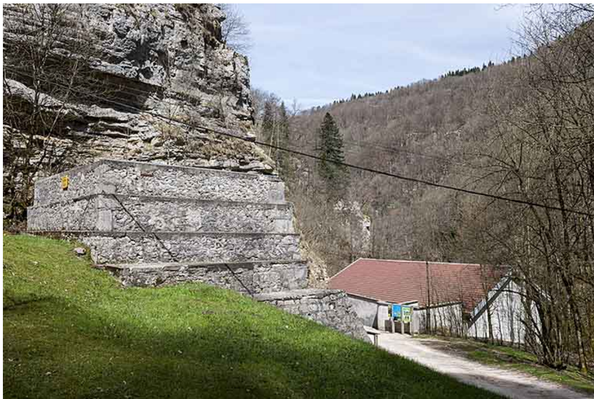
La cheminée d'équilibre et la centrale depuis l'arrivée.
