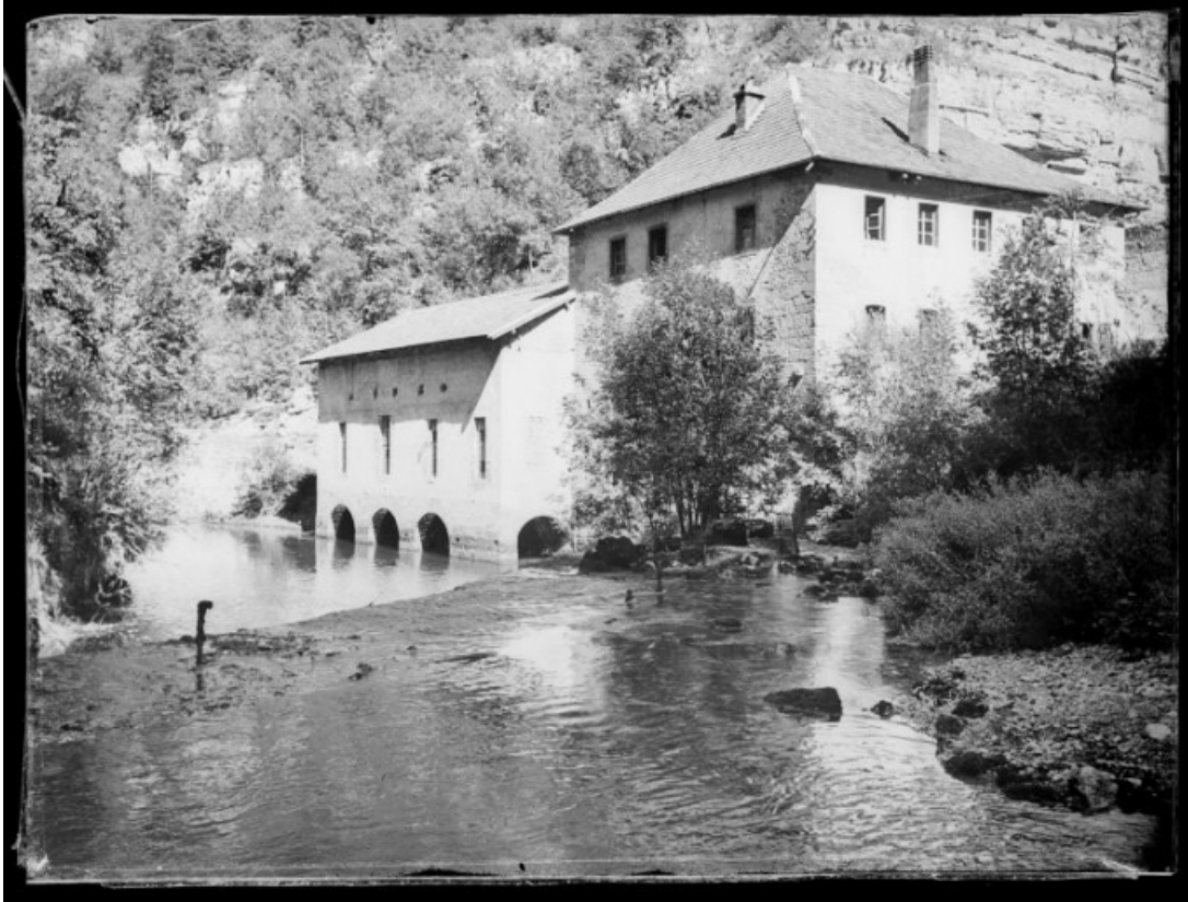
Vue d'ensemble depuis l'aval, fotogr., s.d. [vers 1930].
