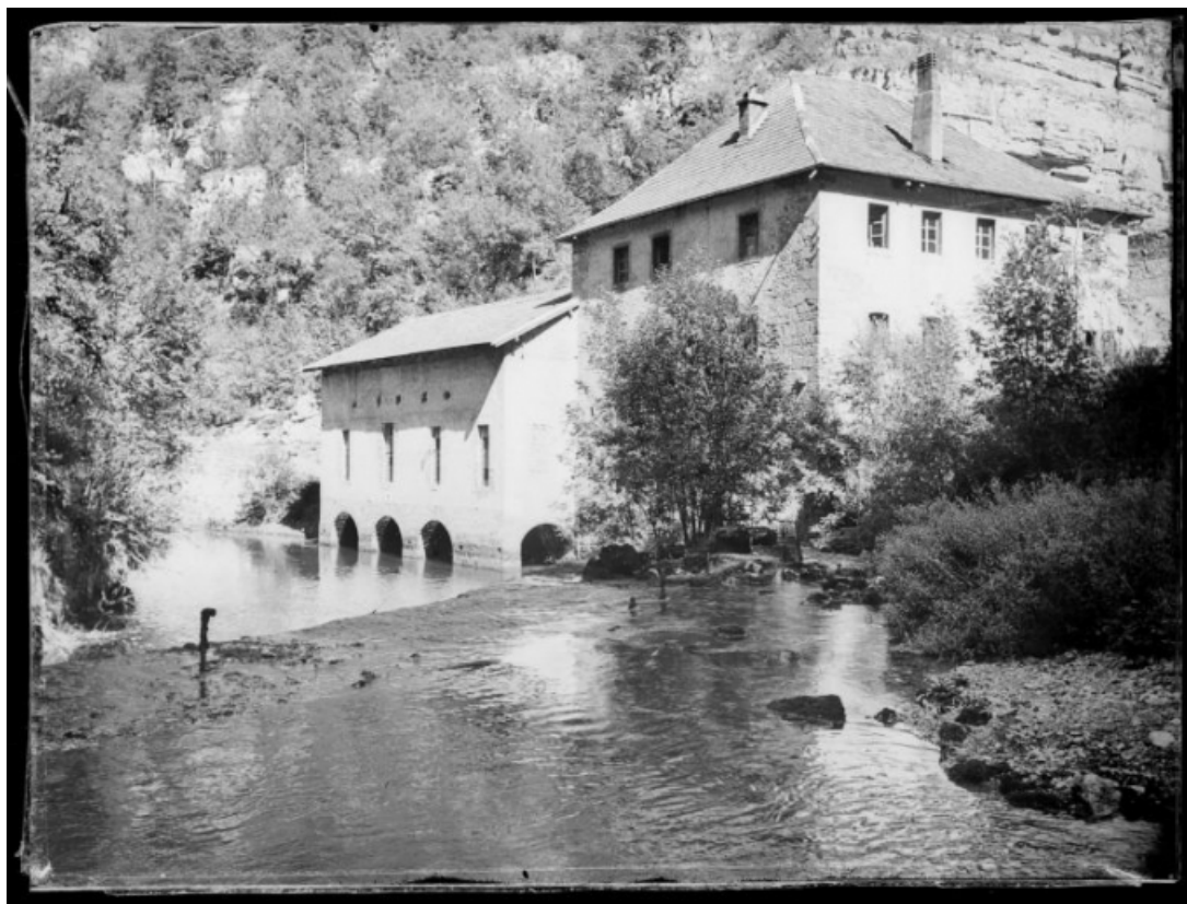
Vue d'ensemble depuis l'aval, fotogr., s.d. [vers 1930].
