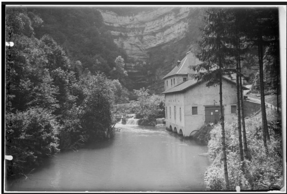
Vue d'ensemble depuis l'aval, fotogr., s.d. [vers 1930].
