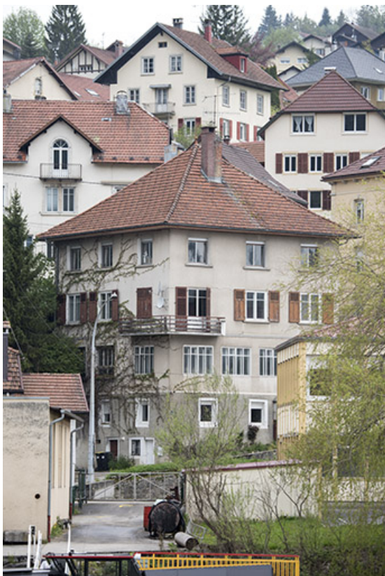
Vue d'ensemble, depuis le sud-est (façade sur la rue du Doubs). 25, Villers-le-Lac, 1 rue du Doubs
