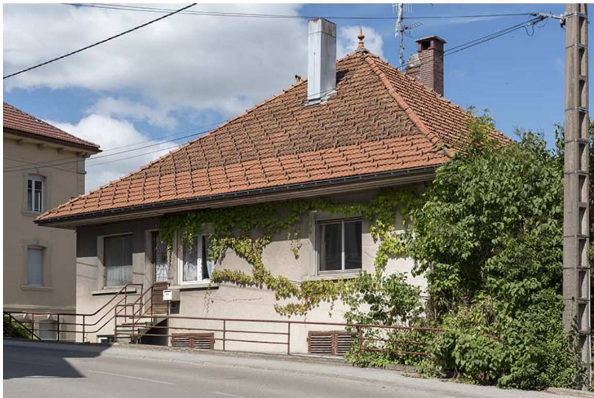
Façade postérieure (rue du Maréchal Foch). 25, Villers-le-Lac, 1 rue du Doubs
