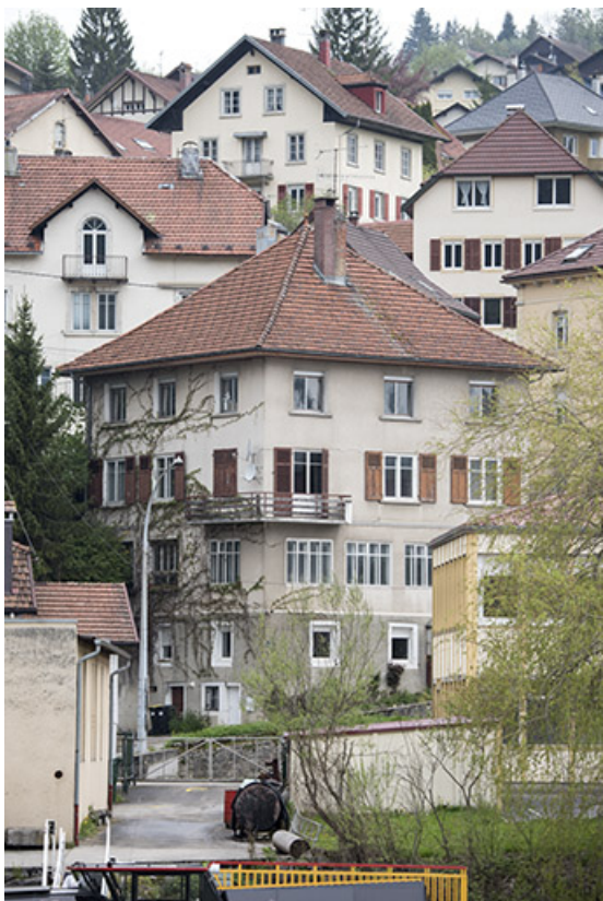
Vue d'ensemble, depuis le sud-est (façade sur la rue du Doubs). 25, Villers-le-Lac, 1 rue du Doubs
