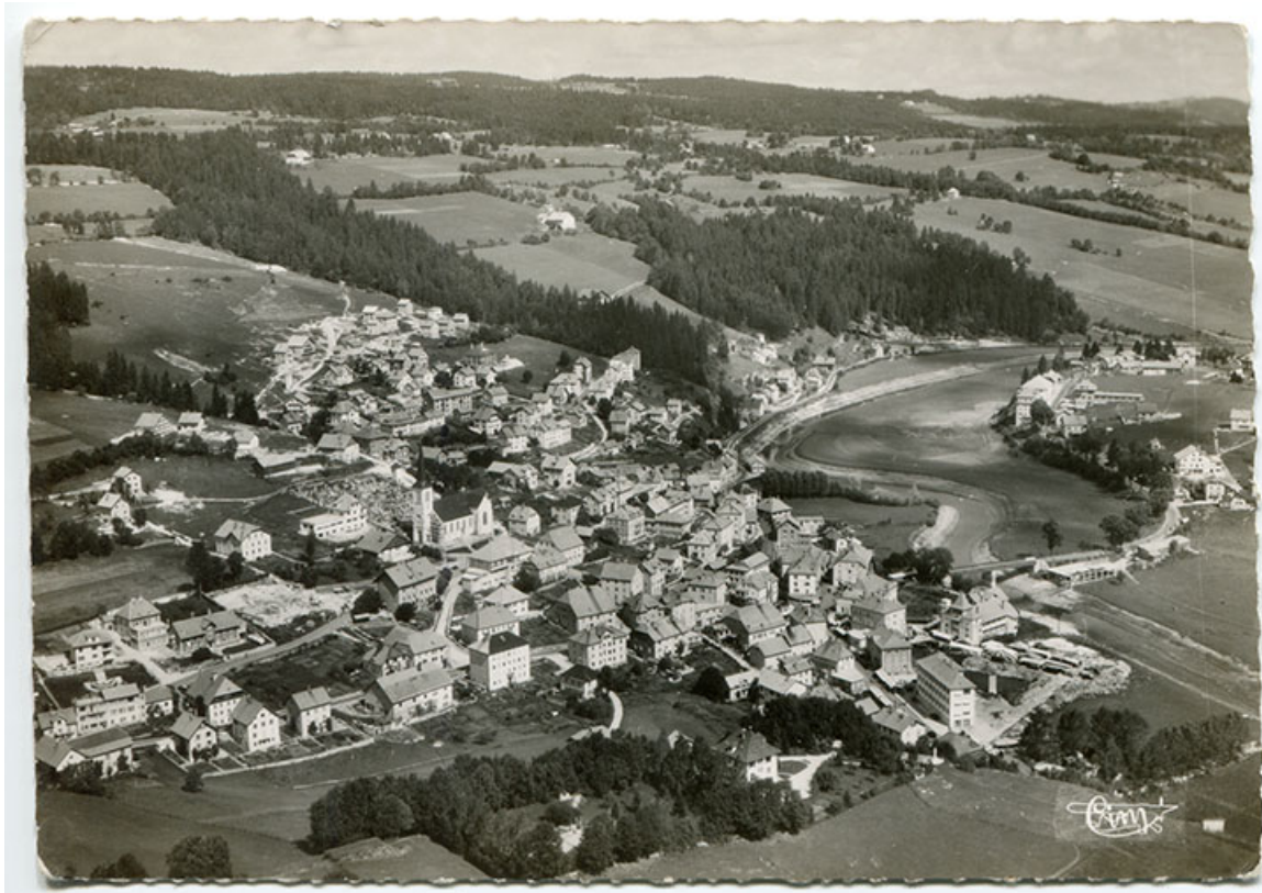
Villers-le-Lac (Doubs). 22173 - Vue panoramique aérienne [depuis le sud], 1952. L'usine est visible à droite. 25, Villers-le-Lac
