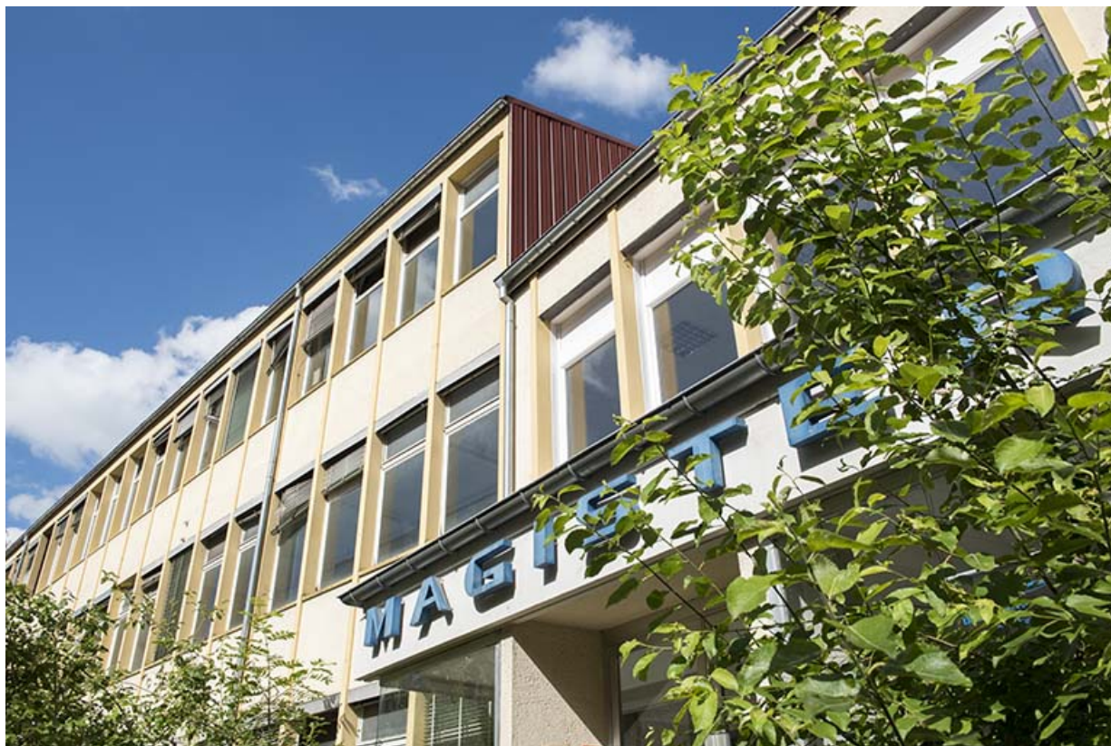
Site récent : entrée, vue en contre-plongée.
