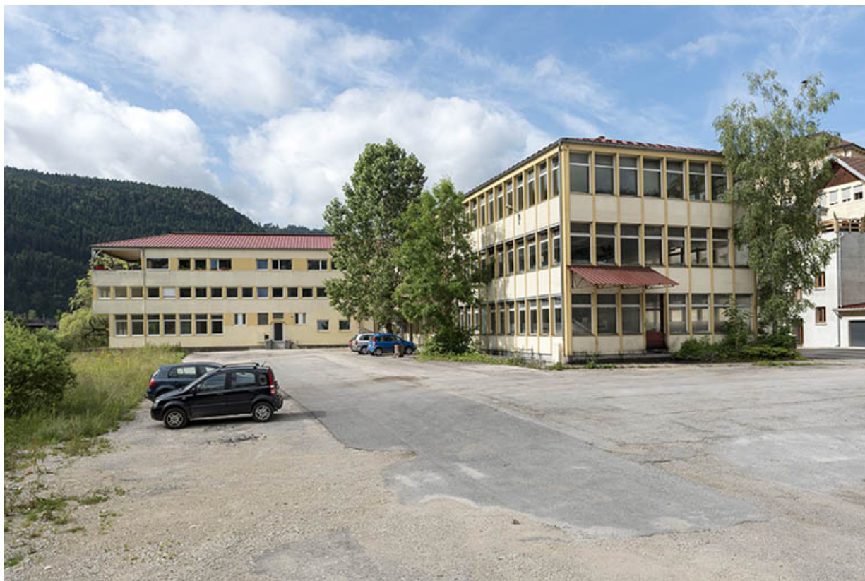
Site récent, vu du nord.
