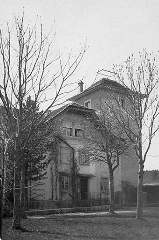
[La maison : façade latérale droite], 1936.
