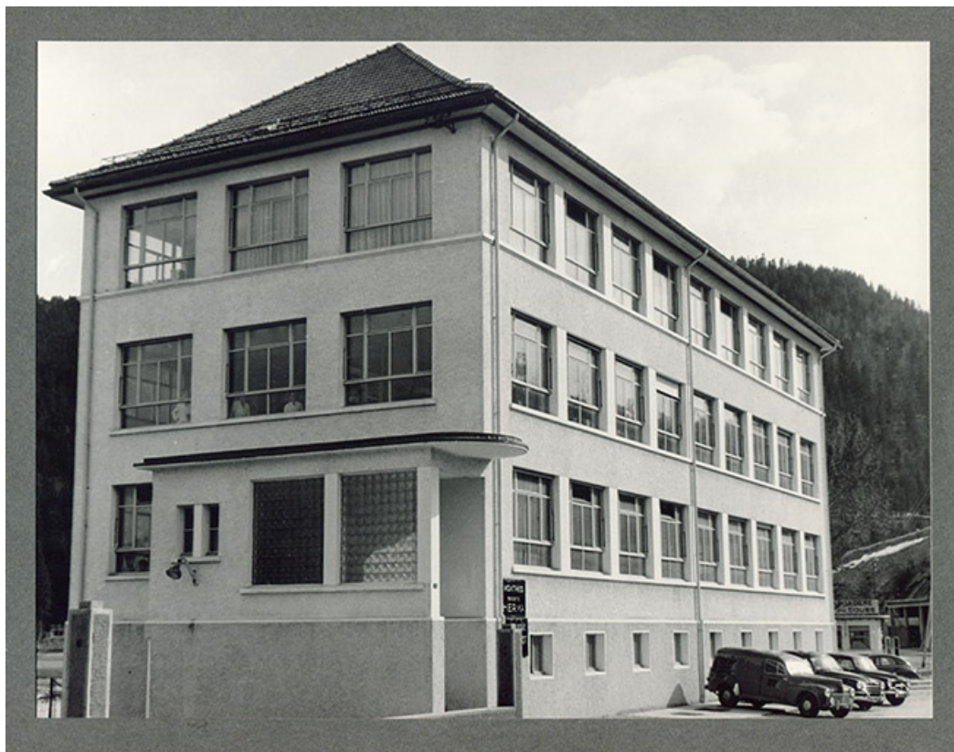
Façades antérieure et latérale gauche, années 1960.
