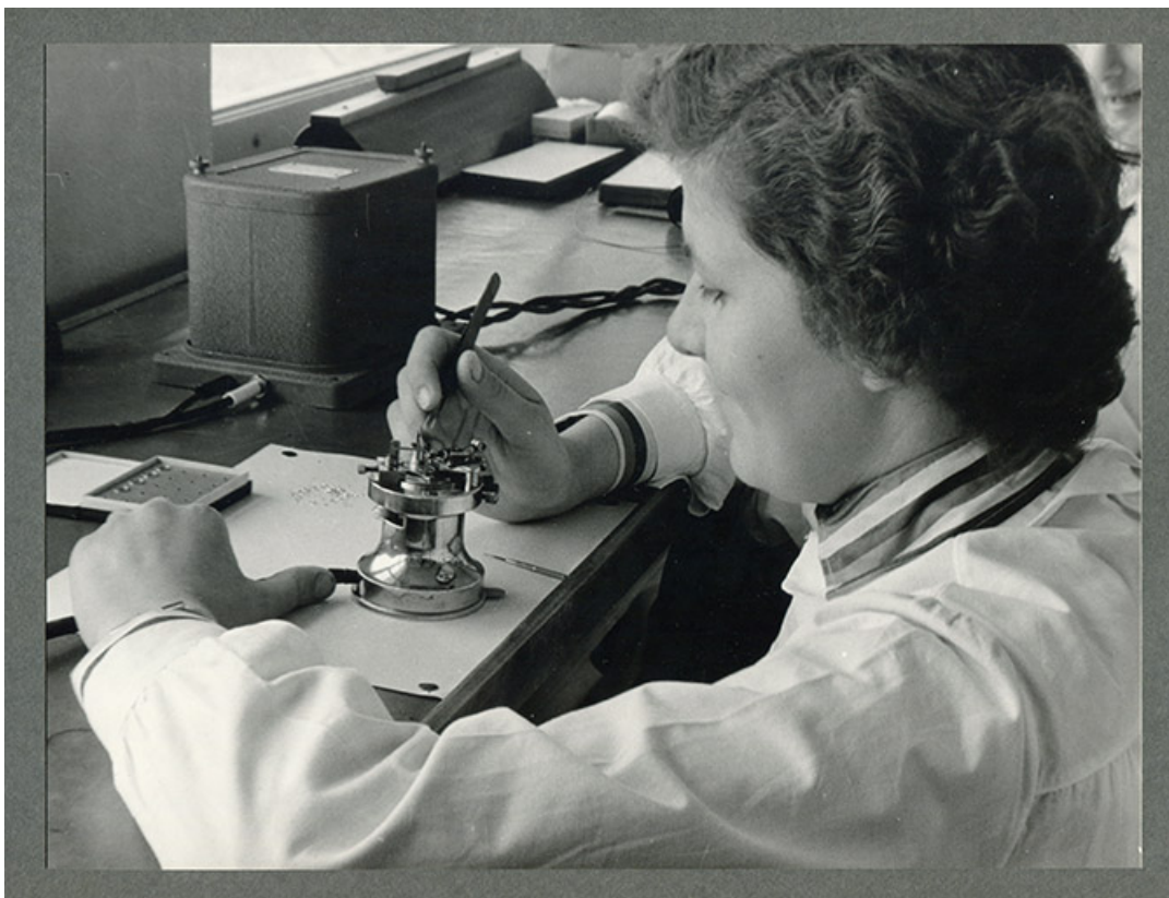
Ouvrière au travail : réglage du balancier-spiral, années 1960.
