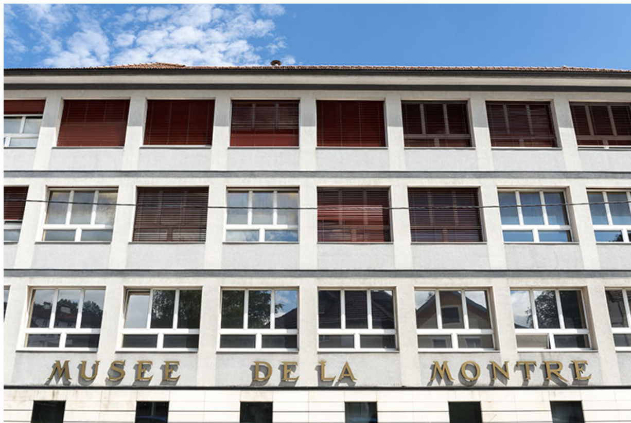
Façade antérieure, vue en contre-plongée.
