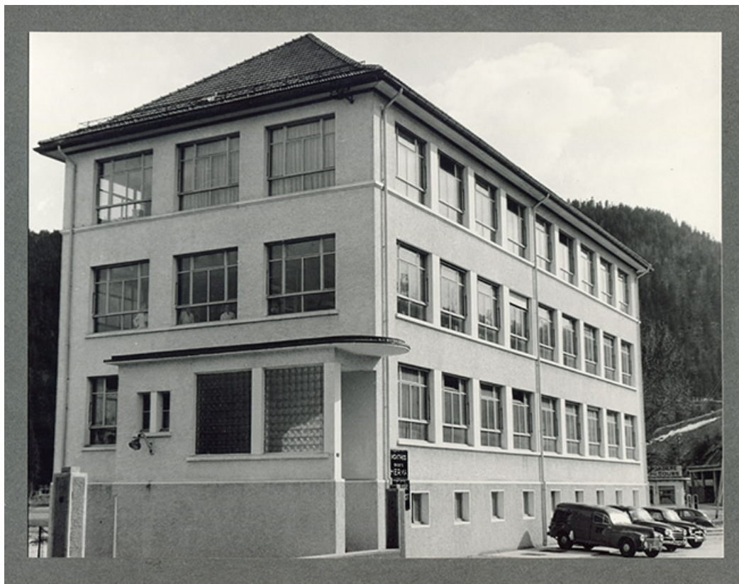
Façades antérieure et latérale gauche, années 1960.
