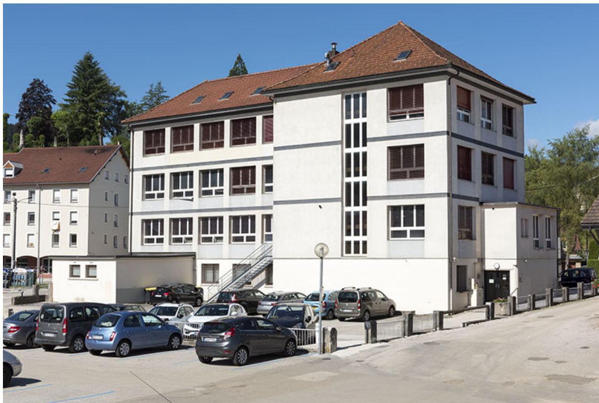
Façades postérieure et latérale gauche.
