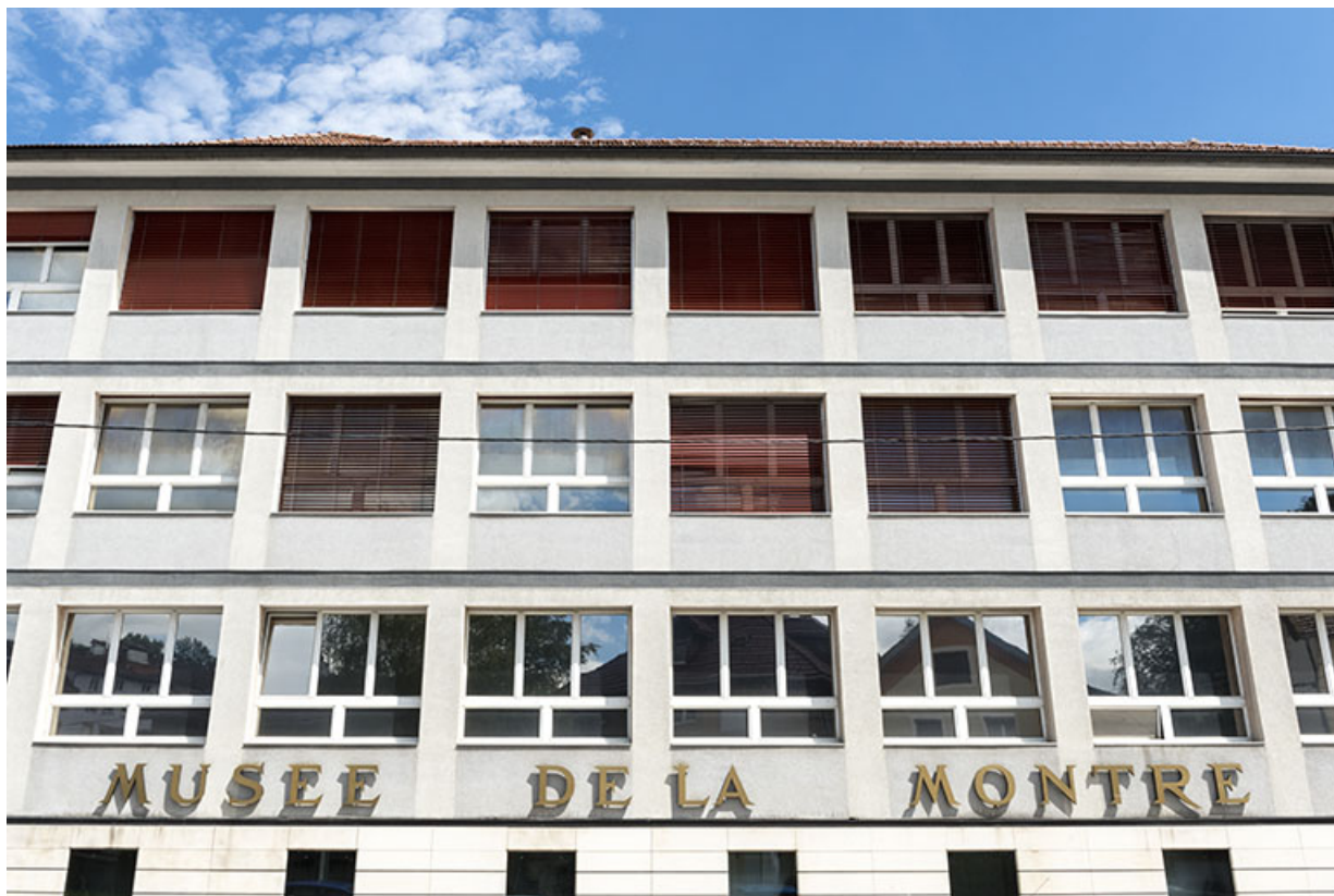
Façade antérieure, vue en contre-plongée.
