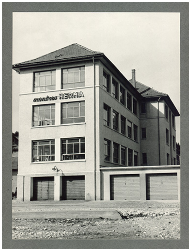
Façades postérieure et latérale droite, années 1960. 25, Villers-le-Lac, 5 rue Pierre Berçot
