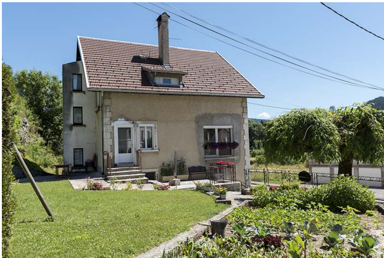
Maison : façade latérale gauche.
