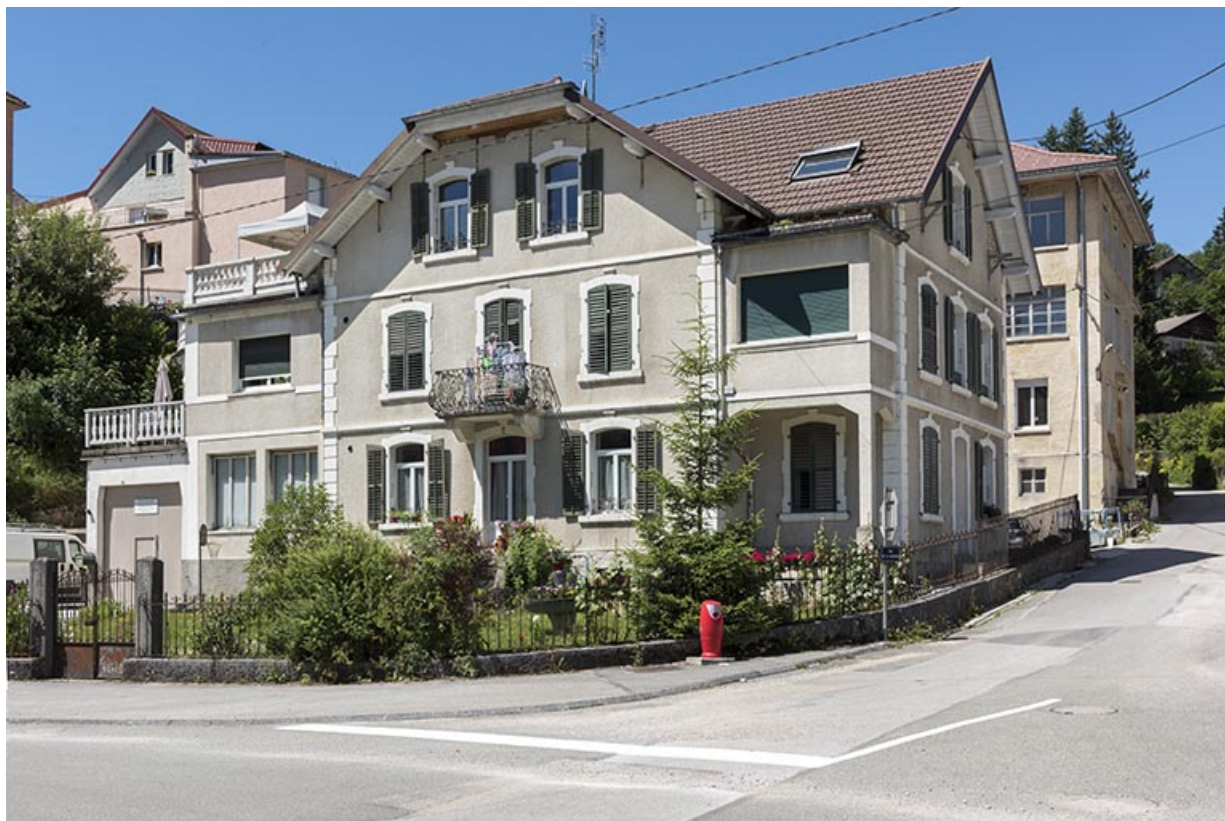
Maison et usine de montres dite fabrique de La Perrière ou Manufacture Marius Anguenot (vers 1907, 1924-1925, 1938-1951), aux 1 et 3 rue de la Perrière : la maison.
