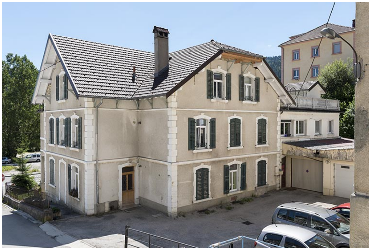
Maison : façades postérieure et latérale droite.
