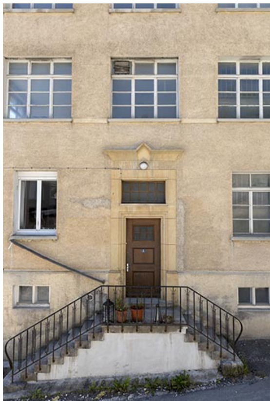
Usine : entrée sur la façade antérieure. 25, Villers-le-Lac, 1-3 B rue de la Perrière
