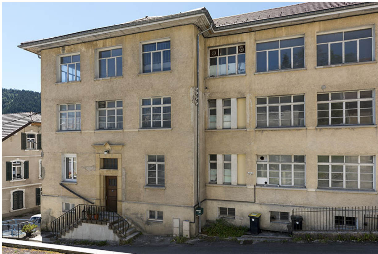
Usine : façade antérieure.
