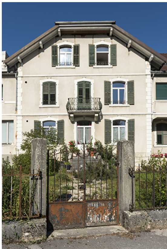
Mason : avant-corps central sur la façade antérieure.
