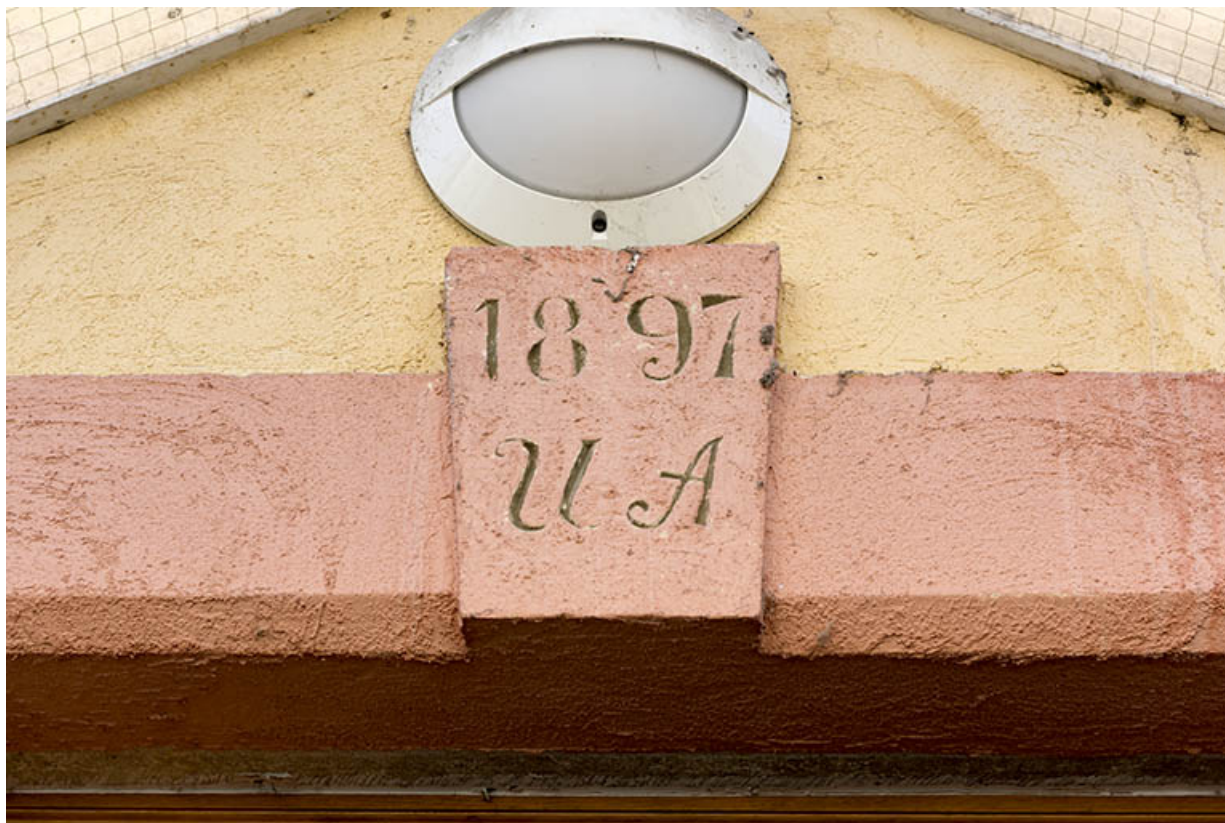
Façade antérieure : date et initiales au-dessus de l'entrée.
