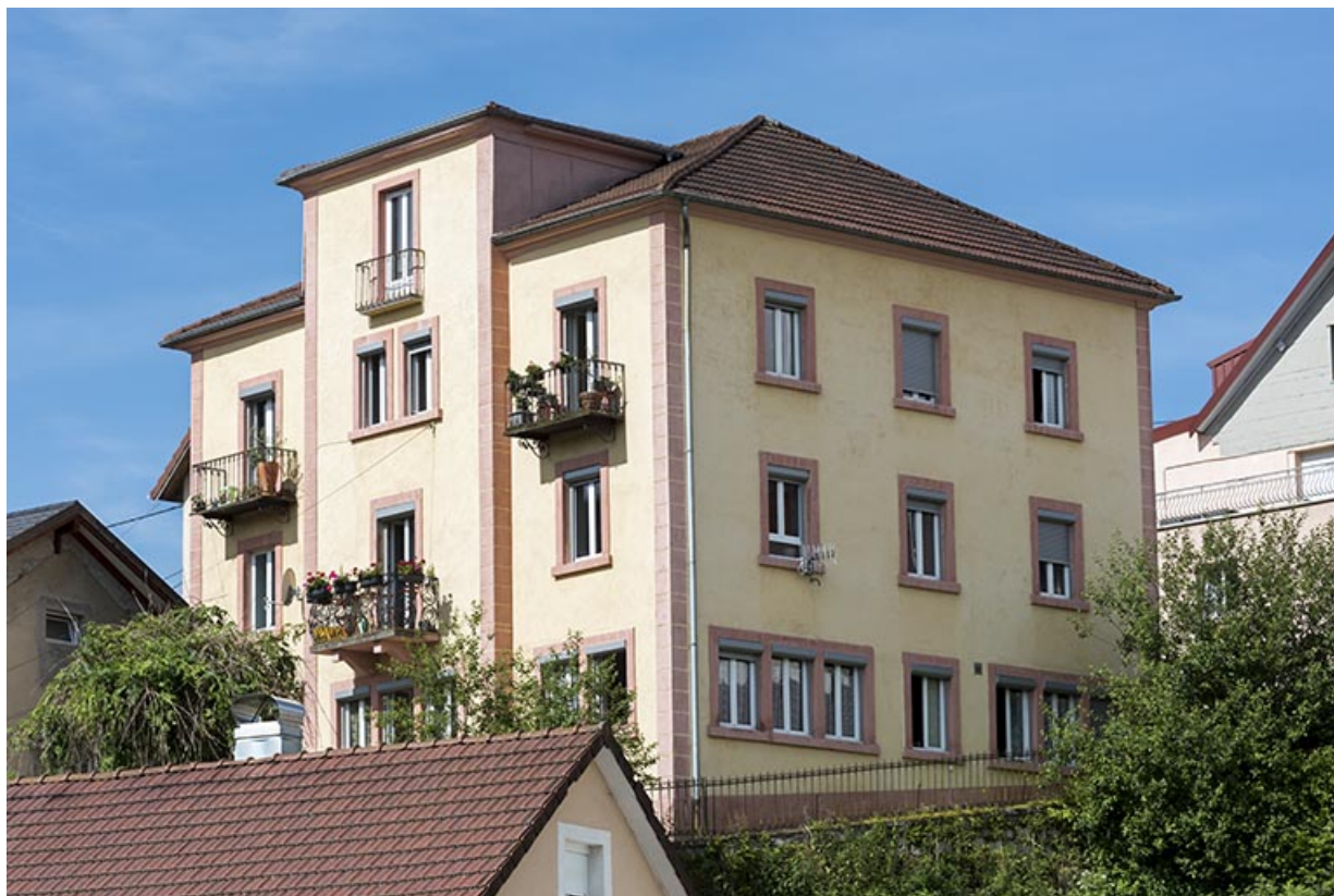
Façades postérieure et latérale gauche.
