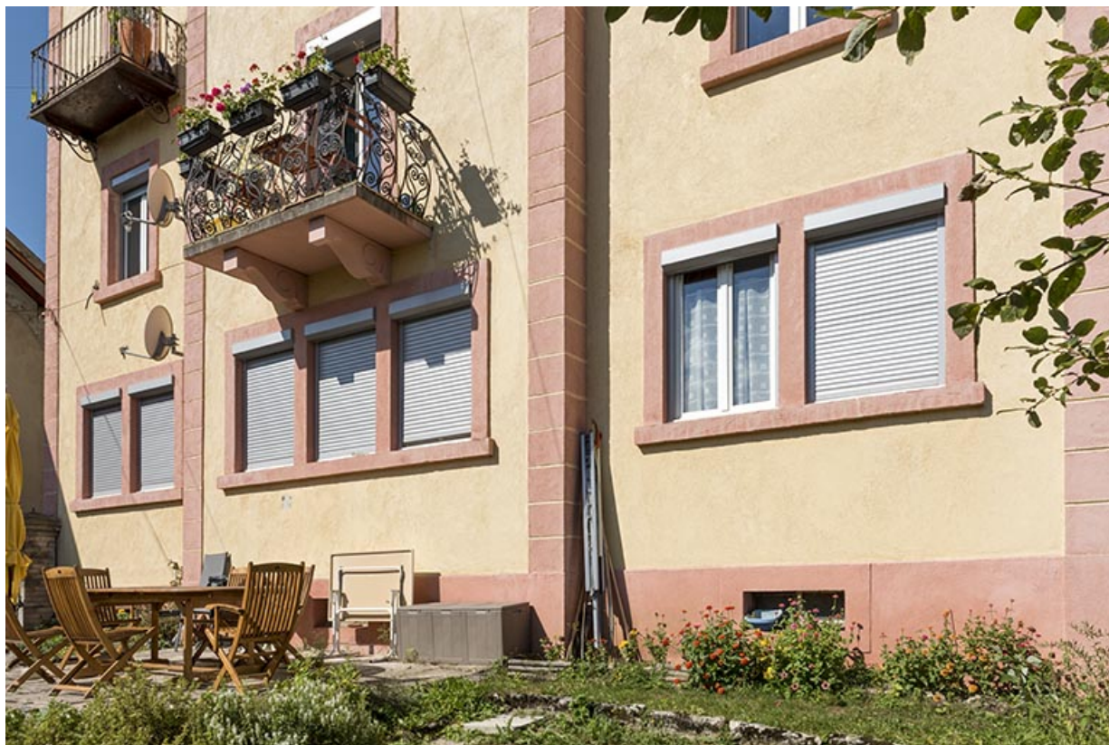
Façade postérieure : fenêtres horlogères et multiples, à l'étage de soubassement.
