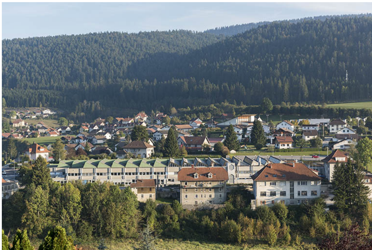
Vue d'ensemble plongeante, depuis le nord-ouest.
