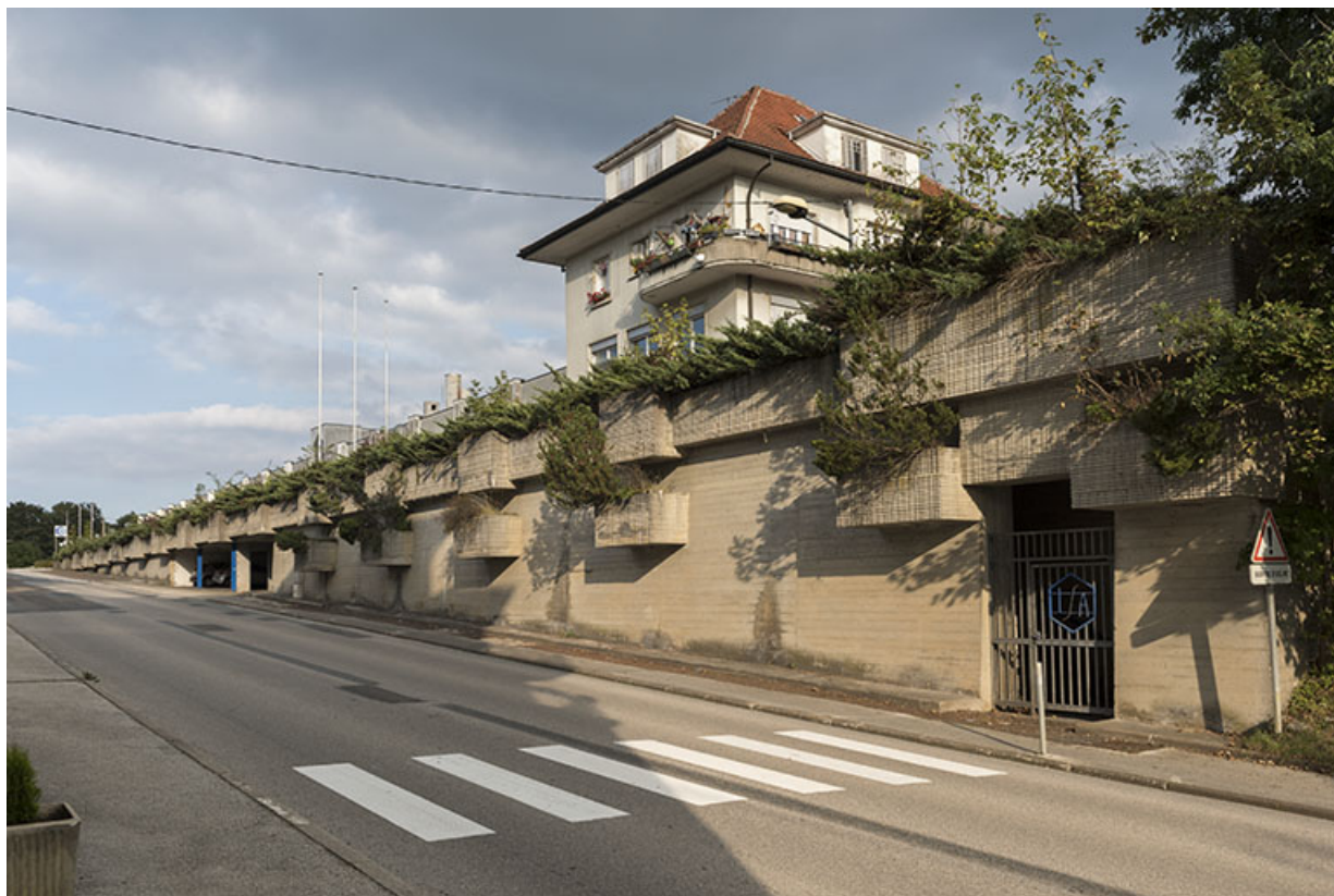
Inscription de l'usine dans la pente côté rue des Clos Rondot, à l'ouest. 25, Villers-le-Lac, 8 rue des Clos Rondot
