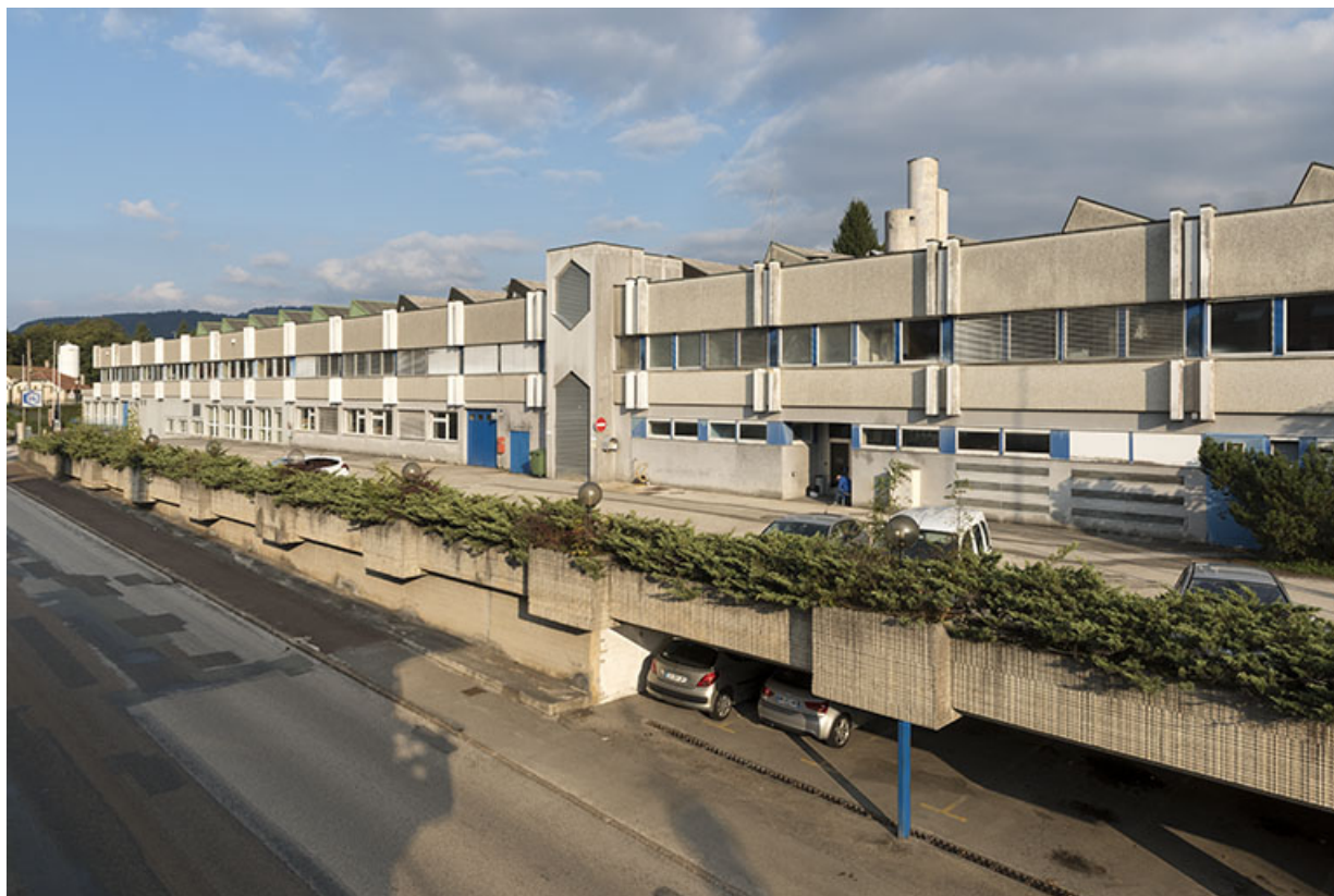
Vue d'ensemble, depuis l'ouest.
