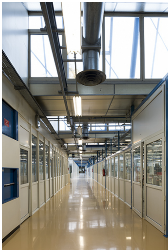
Couloir central (long de 108 m) au 1er étage.
