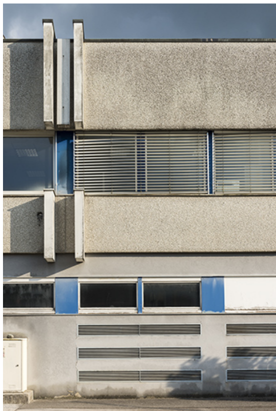
Façade ouest : une travée de l'atelier de 1970.
