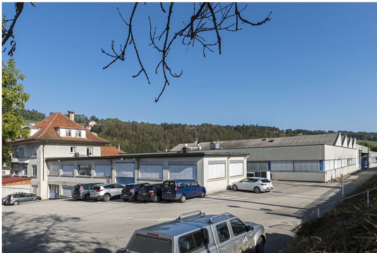
Logement et atelier de fabrication d'origine, depuis le sud, avec l'atelier de 1970 à droite. 25, Villers-le-Lac, 8 rue des Clos Rondot
