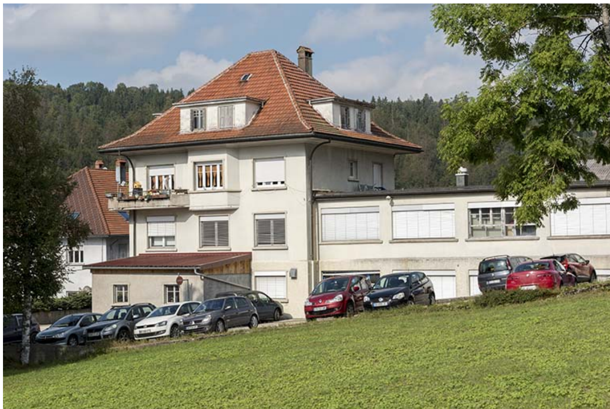
Logement et atelier de fabrication d'origine, depuis le sud (vue rapprochée). 25, Villers-le-Lac, 8 rue des Clos Rondot
