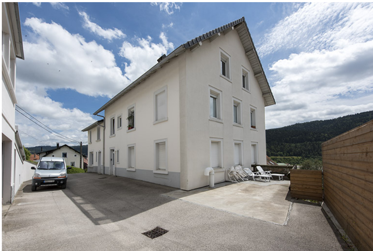
Bâtiments rue de l'Horlogerie : façades nord et ouest. 25, Villers-le-Lac, 3 rue des Essarts
