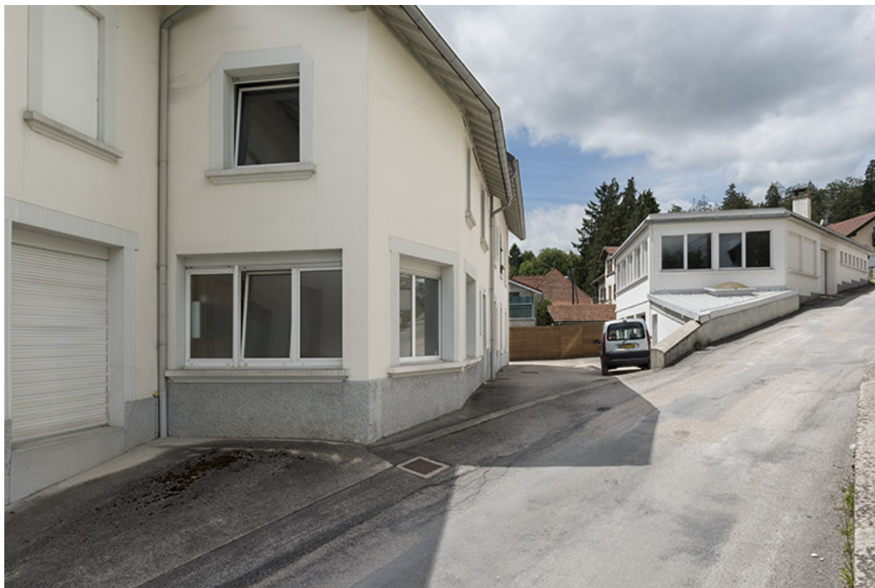
Bâtiments rue de l'Horlogerie à gauche, ancien atelier de l'outillage au carbure à droite. 25, Villers-le-Lac, 3 rue des Essarts
