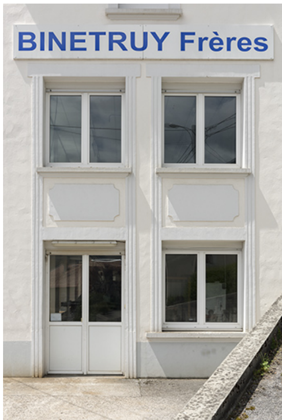
Bâtiments rue de l'Horlogerie : deux premiers niveaux de la façade latérale est. 25, Villers-le-Lac, 3 rue des Essarts
