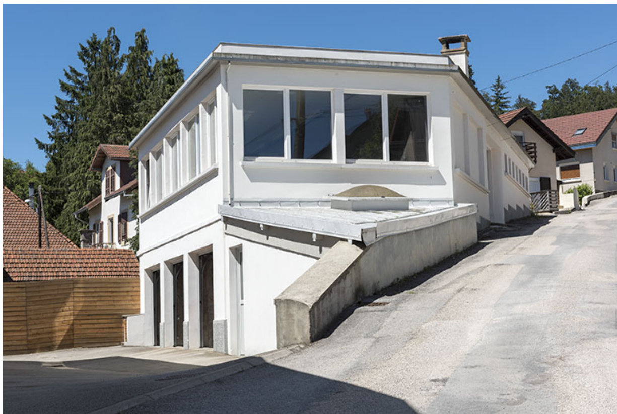
Garages et anciens bureau et atelier de l'outillage au carbure, au nord. 25, Villers-le-Lac, 3 rue des Essarts
