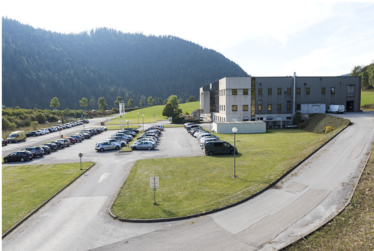
Façade latérale droite et stationnement.
