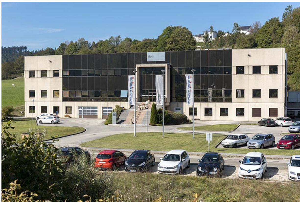
Façade antérieure. 25, Villers-le-Lac
