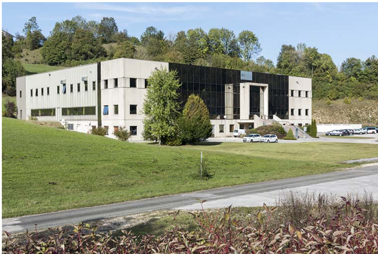
Vue d'ensemble, depuis le sud (façades antérieure et latérale gauche). 25, Villers-le-Lac, 2 rue des Combottes
