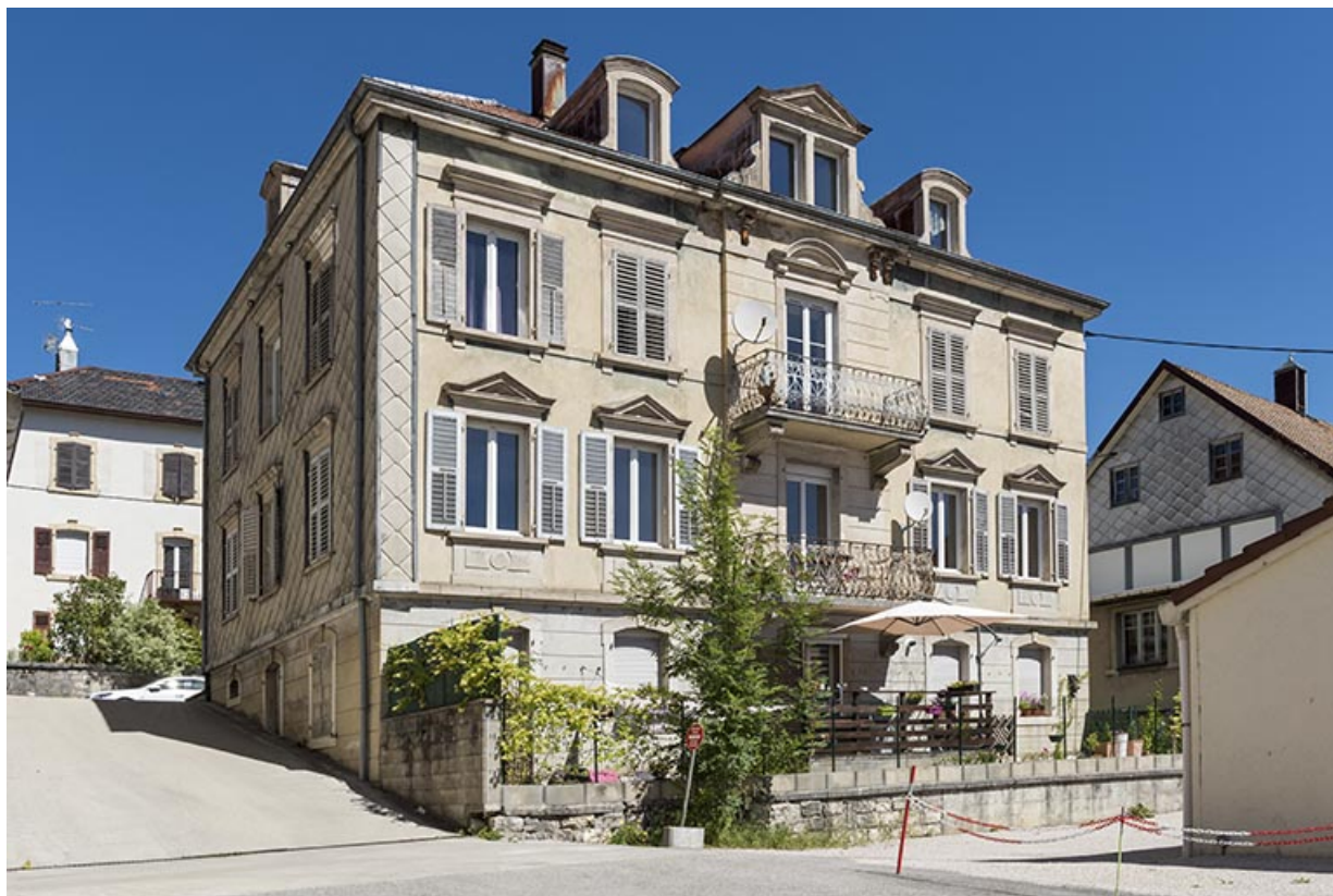
Maison : façades postérieure et latérale droite.
