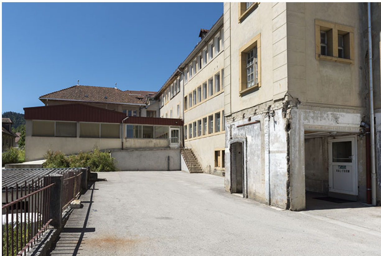
Usine : atelier de mécanique (façade latérale gauche). 25, Villers-le-Lac, 5-9 rue Hippolyte Parrenin
