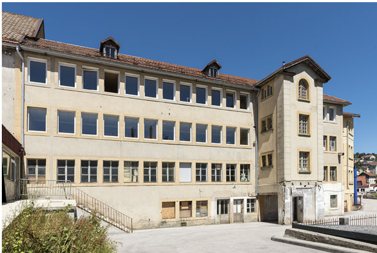
Usine : façade postérieure, de trois quarts gauche. 25, Villers-le-Lac
