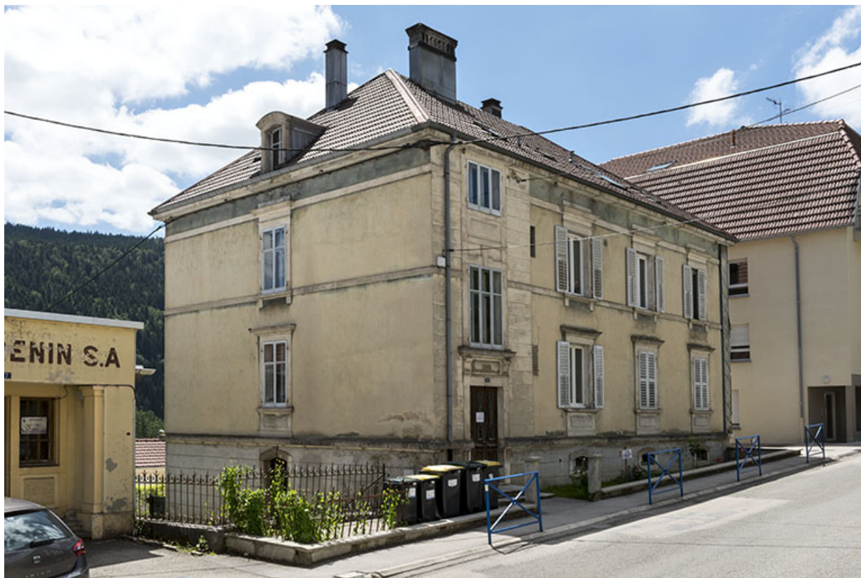
Maison : façades antérieure (rue Parrenin) et latérale gauche.
