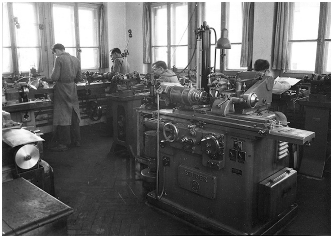
ATELIER DE MÉCANIQUE (construction d'outillage)
