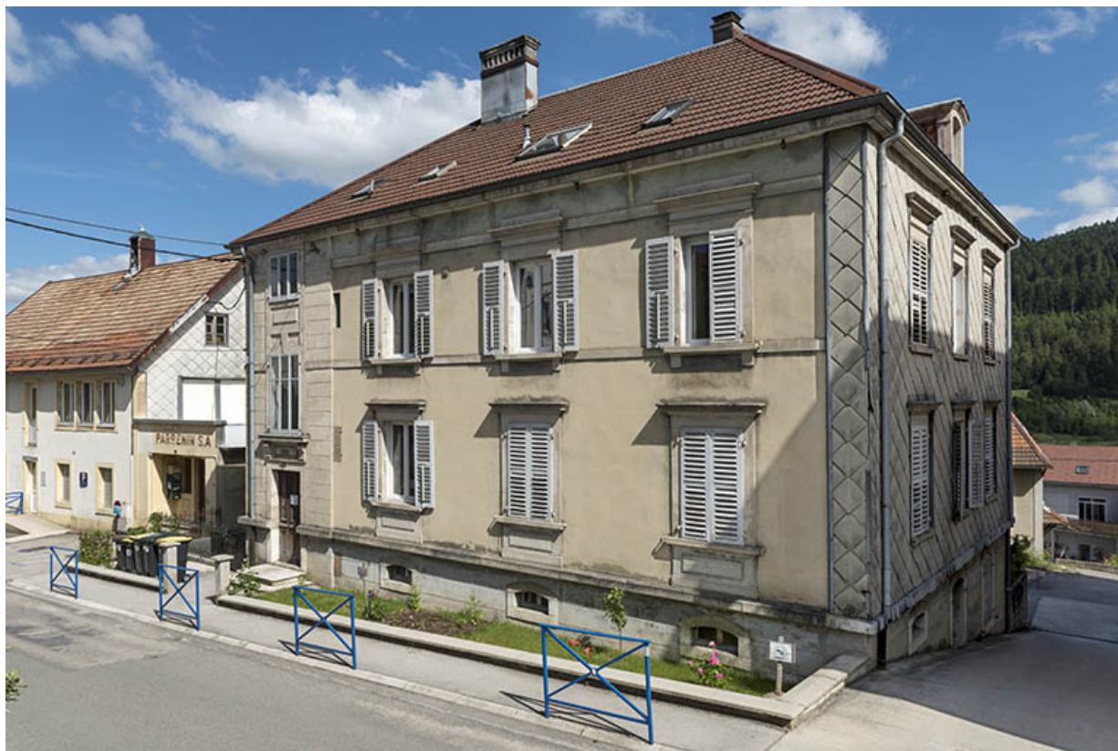
Maison : façades antérieure (rue Parrenin) et latérale droite.
