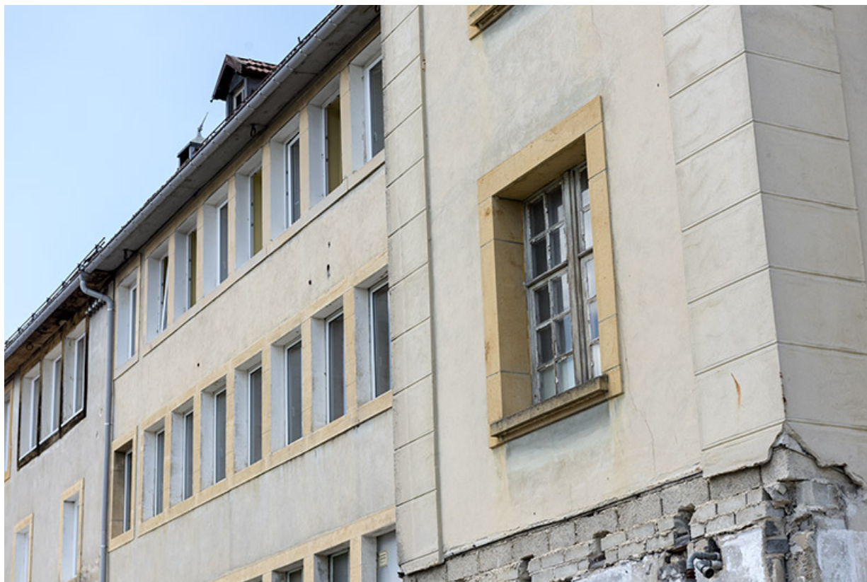
Usine : fenêtres multiples sur la façade postérieure.
