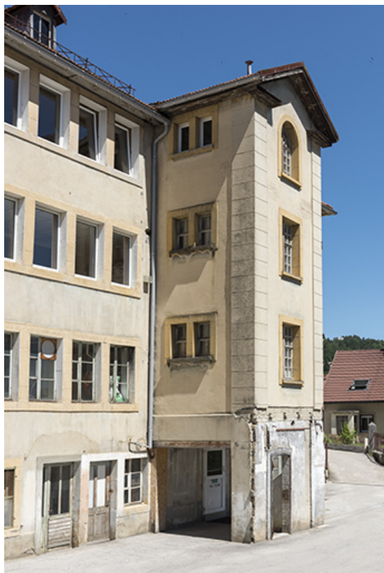
Usine : extrémité nord de la façade postérieure. 25, Villers-le-Lac, 5-9 rue Hippolyte Parrenin
