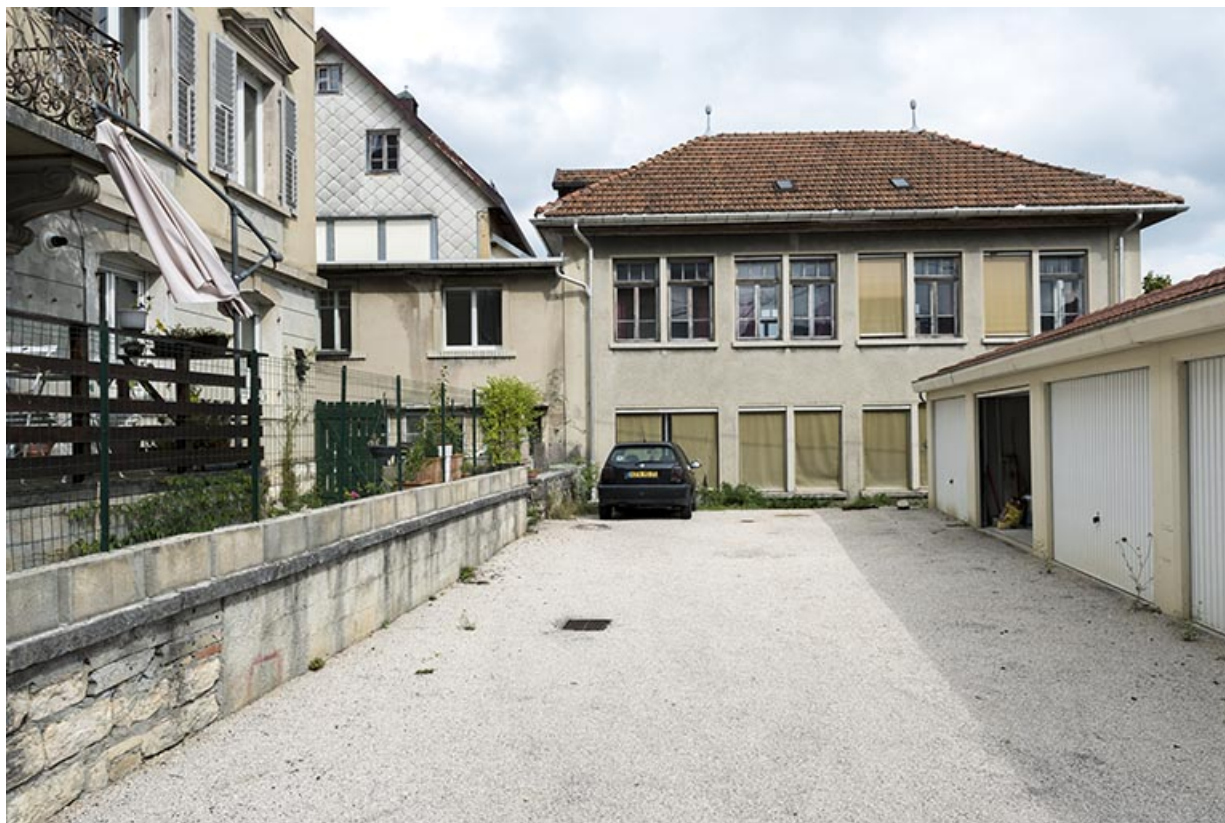
Usine : atelier de mécanique (façade latérale droite). 25, Villers-le-Lac, 5-9 rue Hippolyte Parrenin
