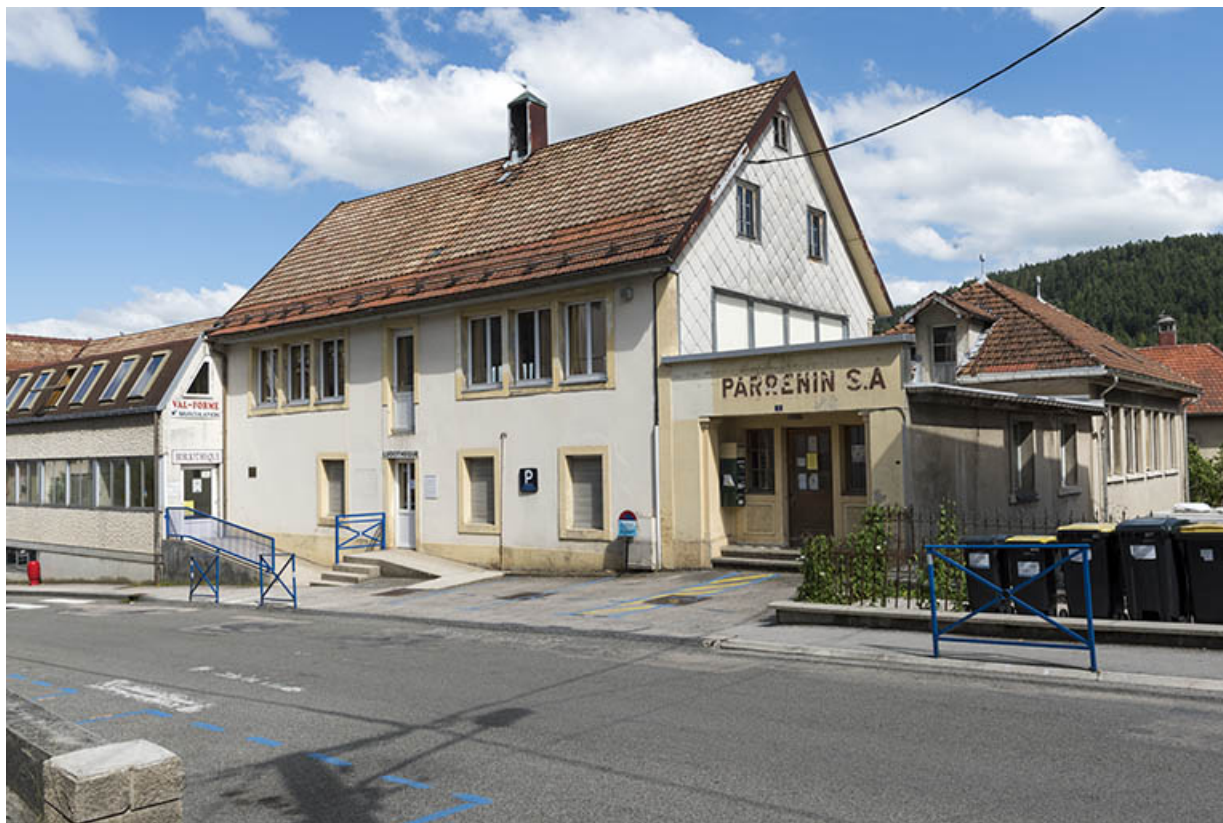
Usine : corps d'entrée et bureau, de trois quarts droite.
