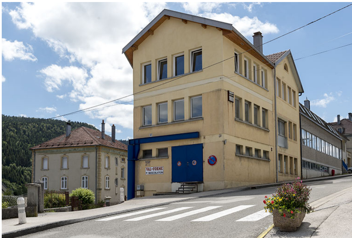
Usine : façade antérieure (rue Parrenin), de trois quarts gauche. 25, Villers-le-Lac, 5-9 rue Hippolyte Parrenin
