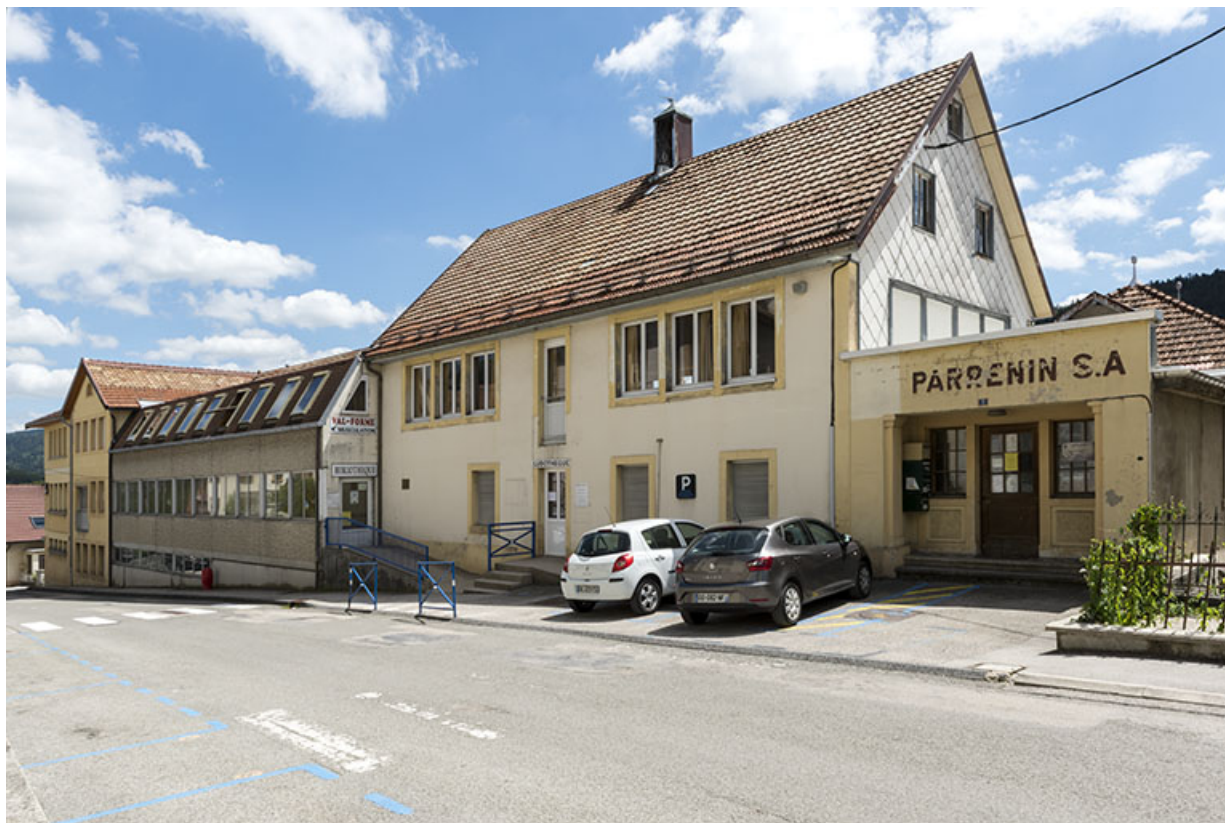
Usine : façade antérieure (rue Parrenin), de trois quarts droite. 25, Villers-le-Lac
