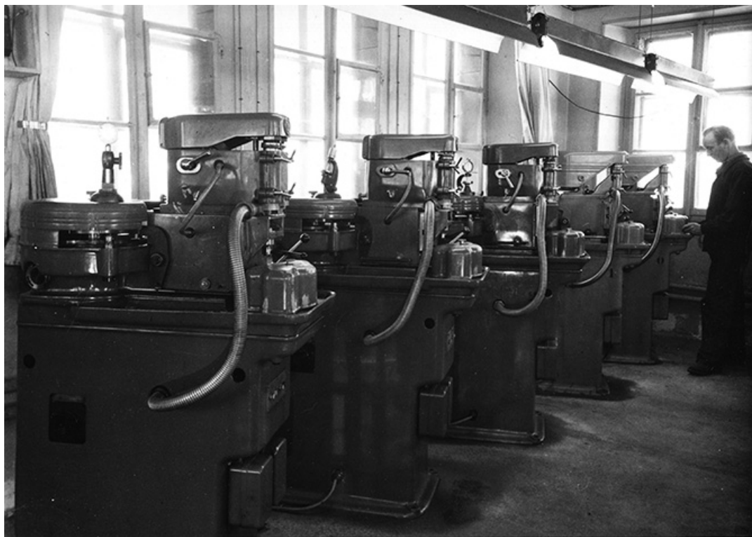
ATELIER DE FRAISAGE (groupe de contourneuses CROUZET à 12 profondeurs) — fabrication française
