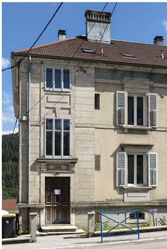
Maison : travée d'entrée sur la façade antérieure.
