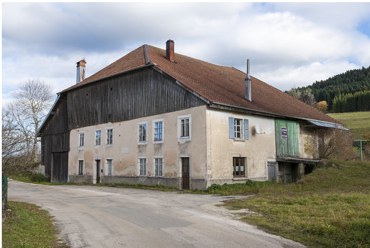
Vue depuis le sud-ouest.
