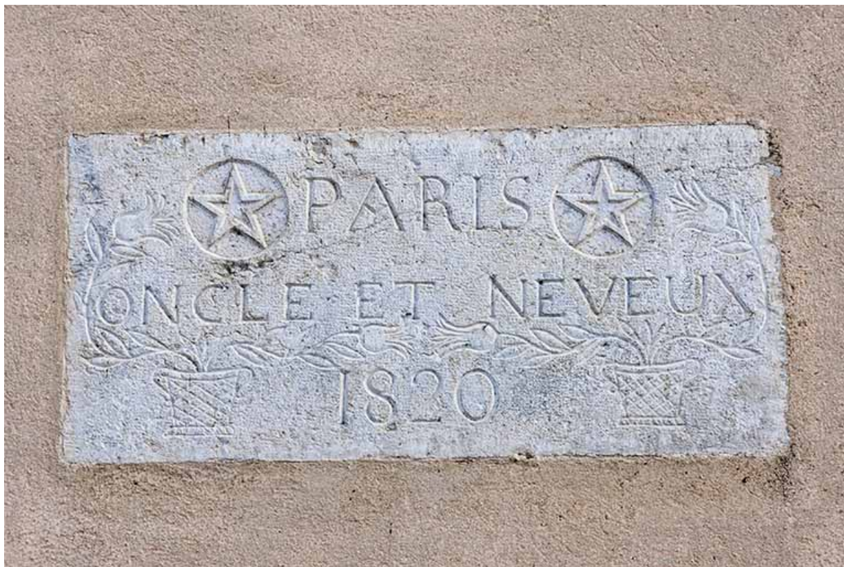
Pierre gravée sur la façade nord.
