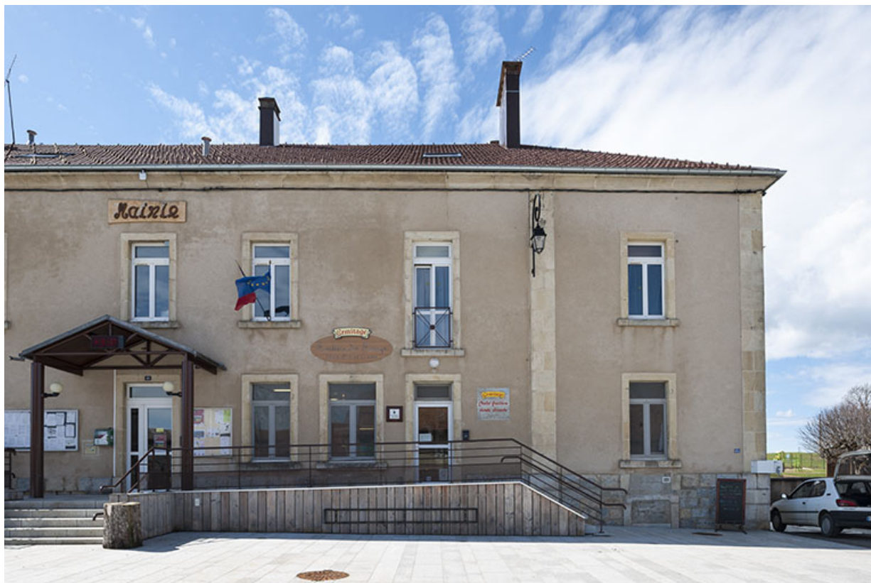
Façade nord (partie fromagerie).
