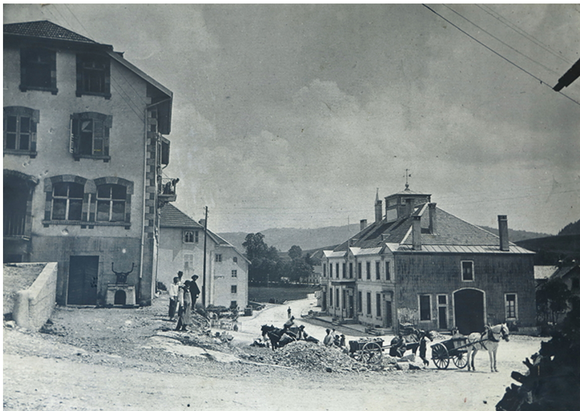
[Construction du mur de soutènement à l'avant de l'usine Cupillard], décennie 1890 ou 1900 ? 25, Villers-le-Lac, 2 place Maxime Cupillard
