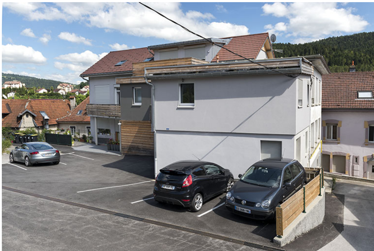
Façade postérieure : bâtiment de 1913 environ (à gauche) et extension de 1950. 25, Villers-le-Lac, 2 place Maxime Cupillard
