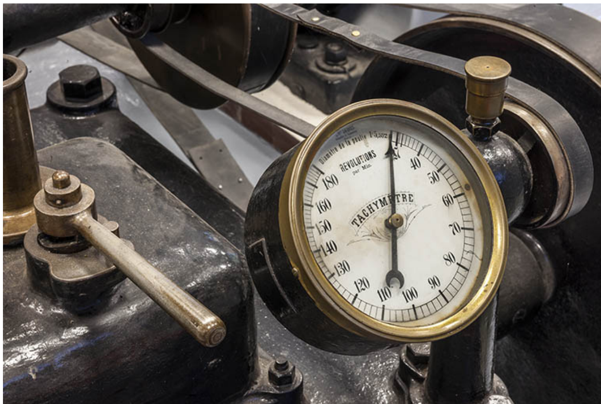
Tachymètre (compte-tours) du régulateur SACM. 25, Labergement-Sainte-Marie, lieudit : le Fourpéret
