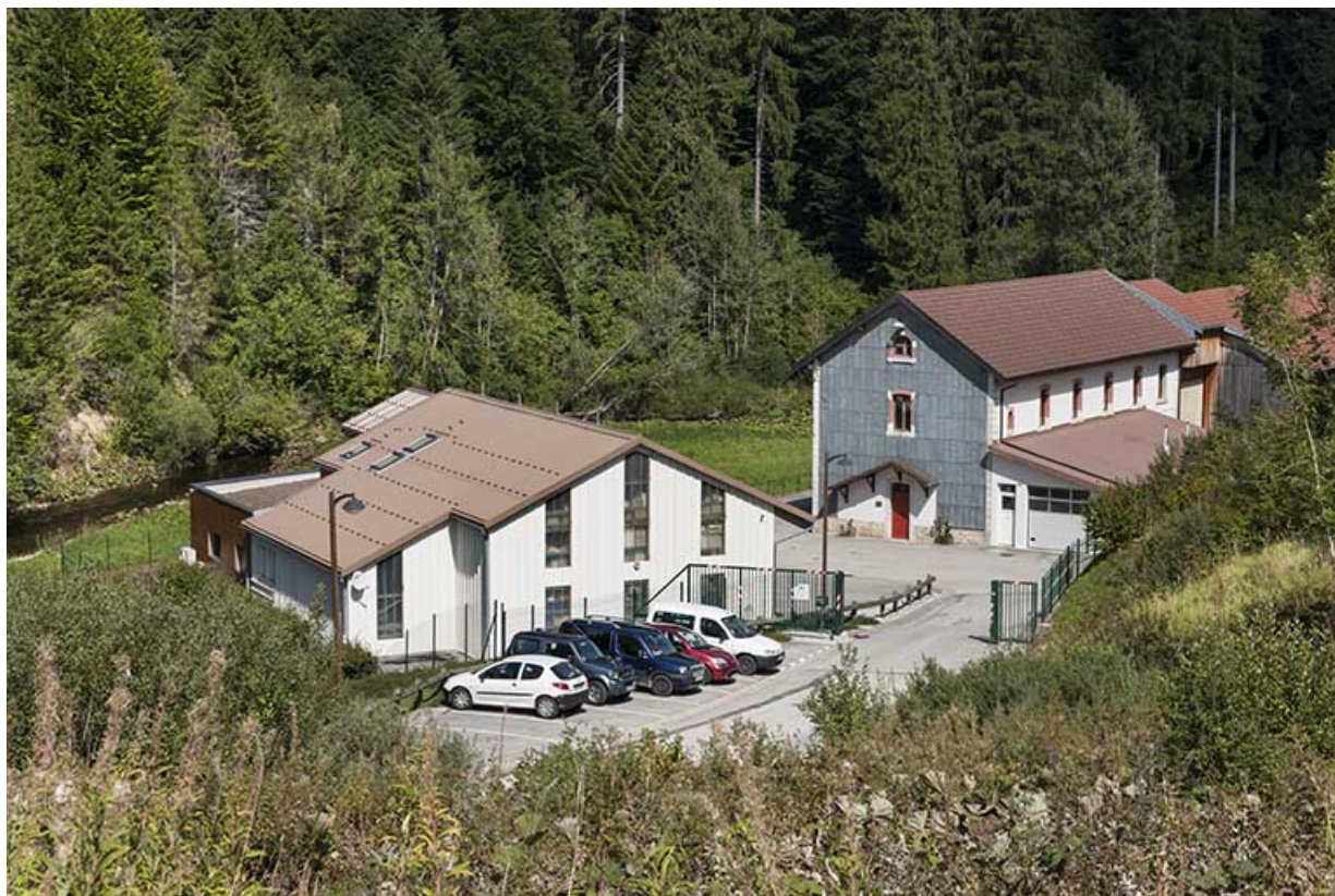
Vue rapprochée depuis le sud-ouest.
