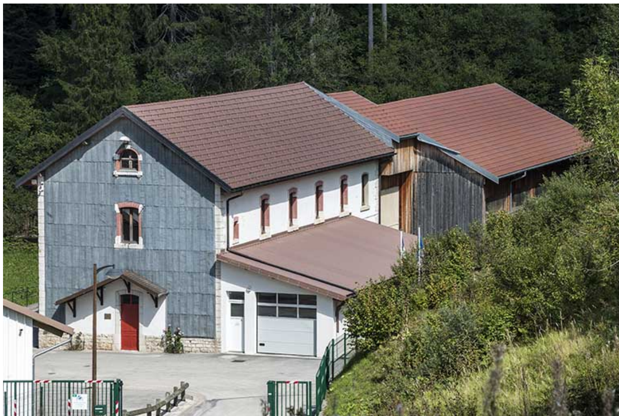
La centrale vue depuis le sud-ouest.
